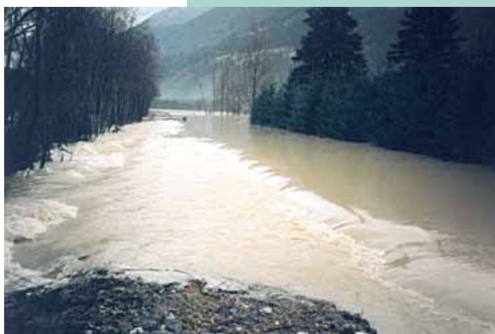
Abb. 5-7: Überströmstrecke der Gail, Kärnten, während des Hochwassers im November 2002
