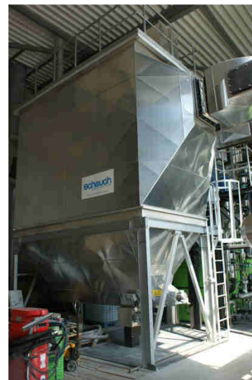
Elektrofilter
