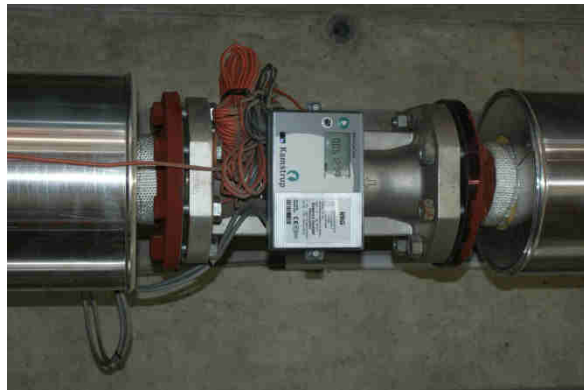
Wärmemengenzähler
