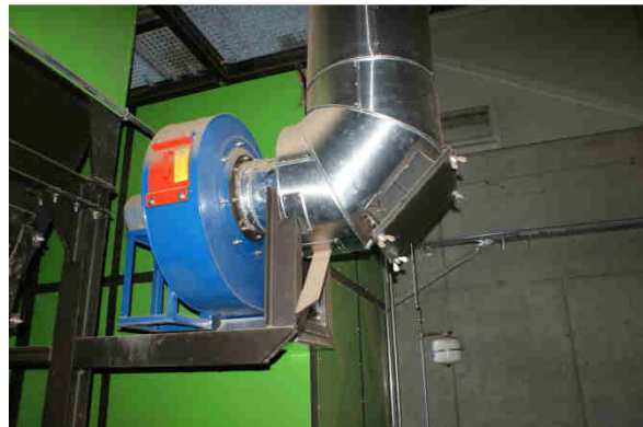
Verbrennungsluftventilator
