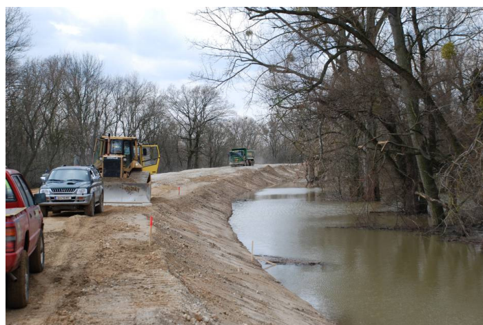
Abb. 3: Arbeiten am Hochwasserschutzdamm im Bereich Marchegg (8.3.2009)
