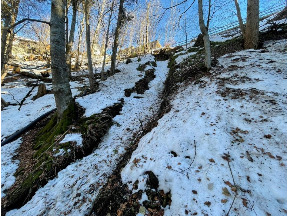
Abbildung 1: Rutschgefährdeter Einhang zum Mühleobel; Gebäude an der Böschungsoberkante
