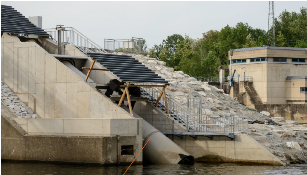
Abbildung 37 Doppelrohrschnecke (oben), Einstiegsbereich (unten)
