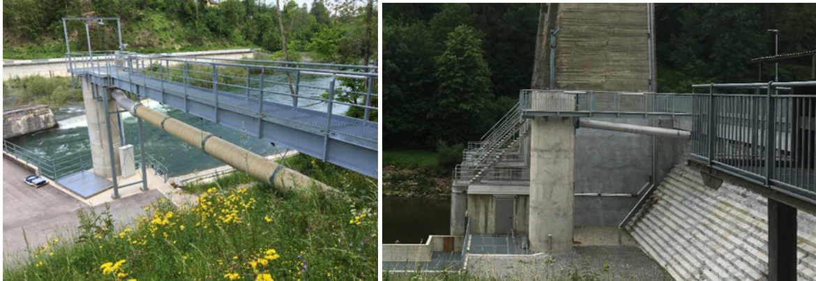
Abbildung 59 Fischliftschleuse mit der Ausschwemmlleitung an zwei Standorten
