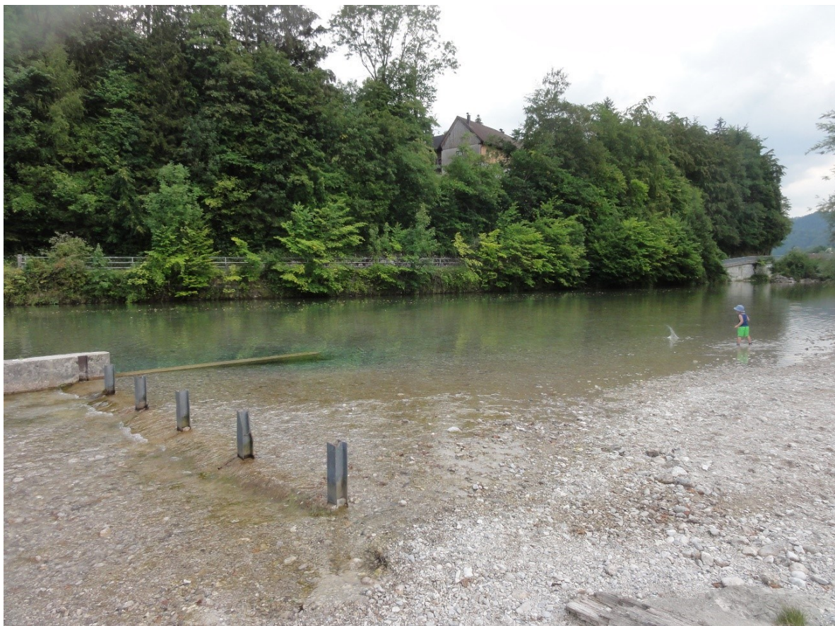
Abbildung 3: Oberwasserbereich OWH - KW Gangljodl (Aufnahme vom 02.08.2018)
