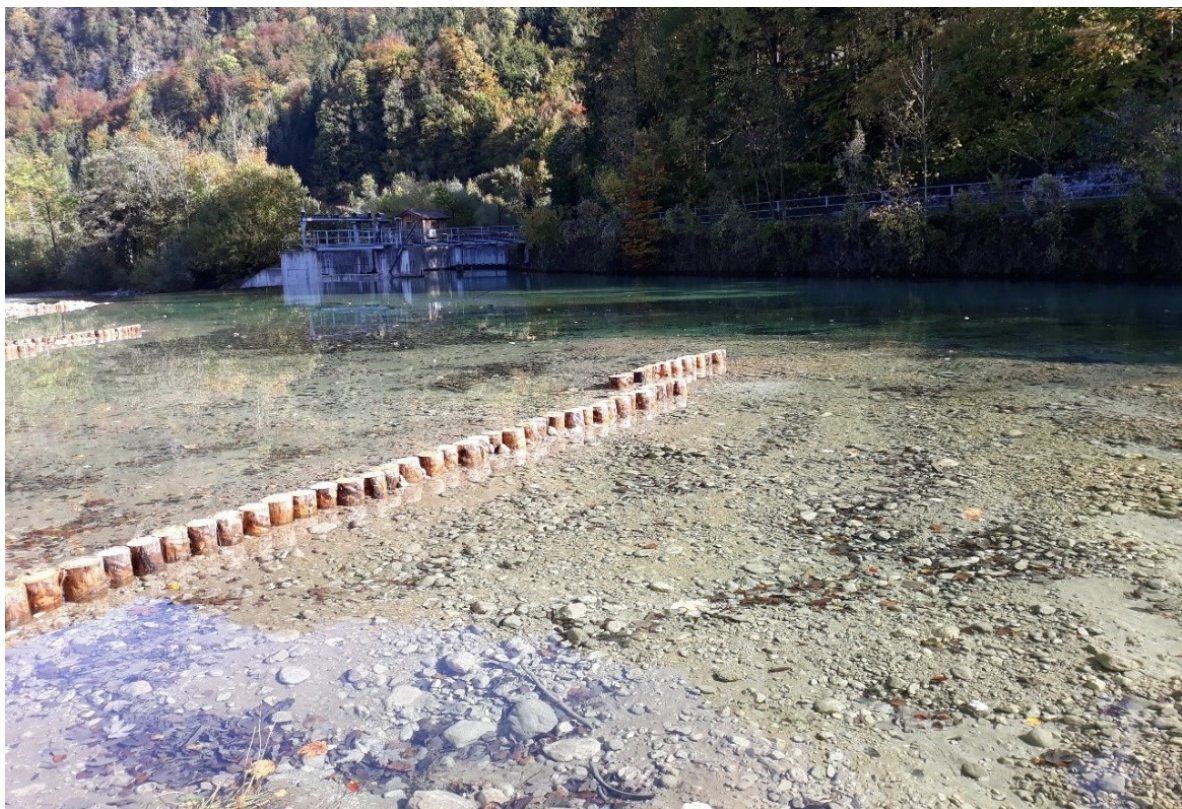
Abbildung 35: Fertiggestellte Pfahlreihe mit Wanderkorridor.
