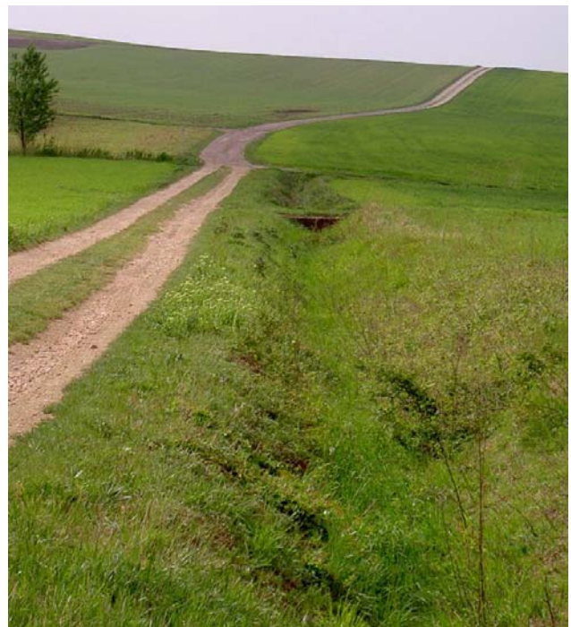
Abb. 3-5: Entwässerungsgraben und Durchlass im Bereich Russbach – Kleinebersdorf (Nö)
