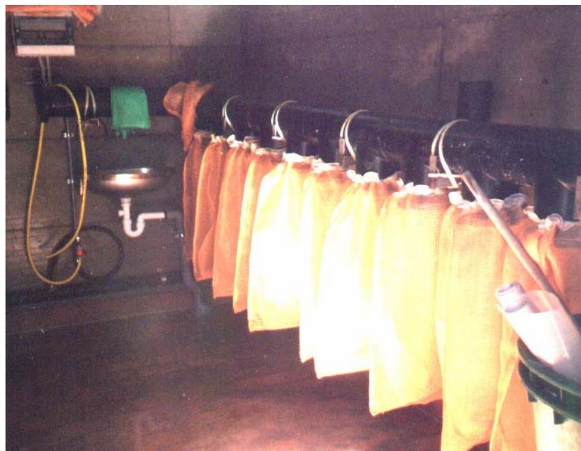
Abbildung 2.2.3.1-2. Großkammertoilette mit externer Kompostierung nach der „Filtersackmethode“
