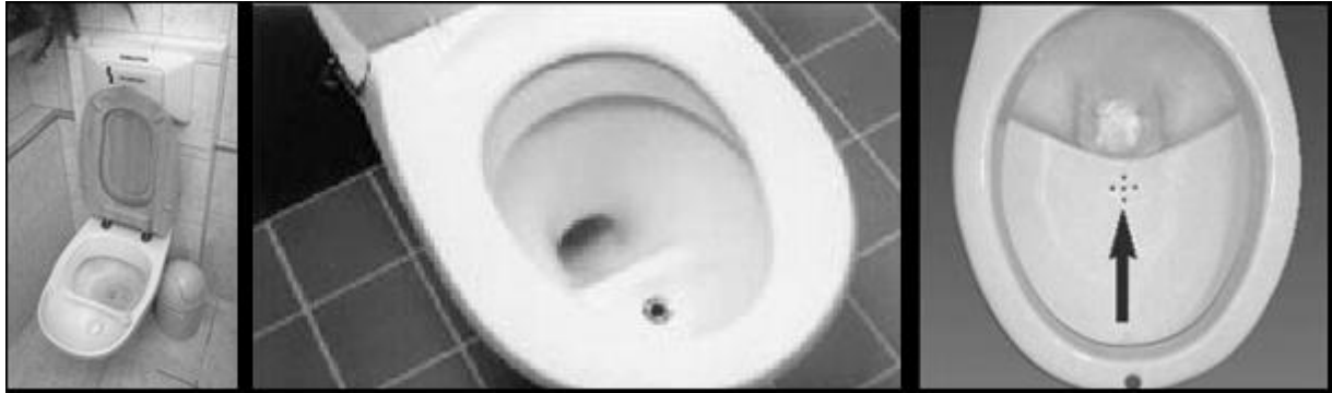
Abbildung 2.1.2-1. Toilettentypen im Vergleich (BB Innovation; Gustavsberg Separationstoilette; Roediger No Mix Toilette)
