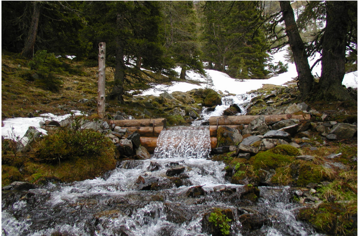
Messstelle mit Stauwerk aus Rundhölzern ausgeführt als Rechteckwehr mit Seitenkontraktion – Ponceletwehr (Schönebenquelle, Steiermark, © HD-Steiermark)
