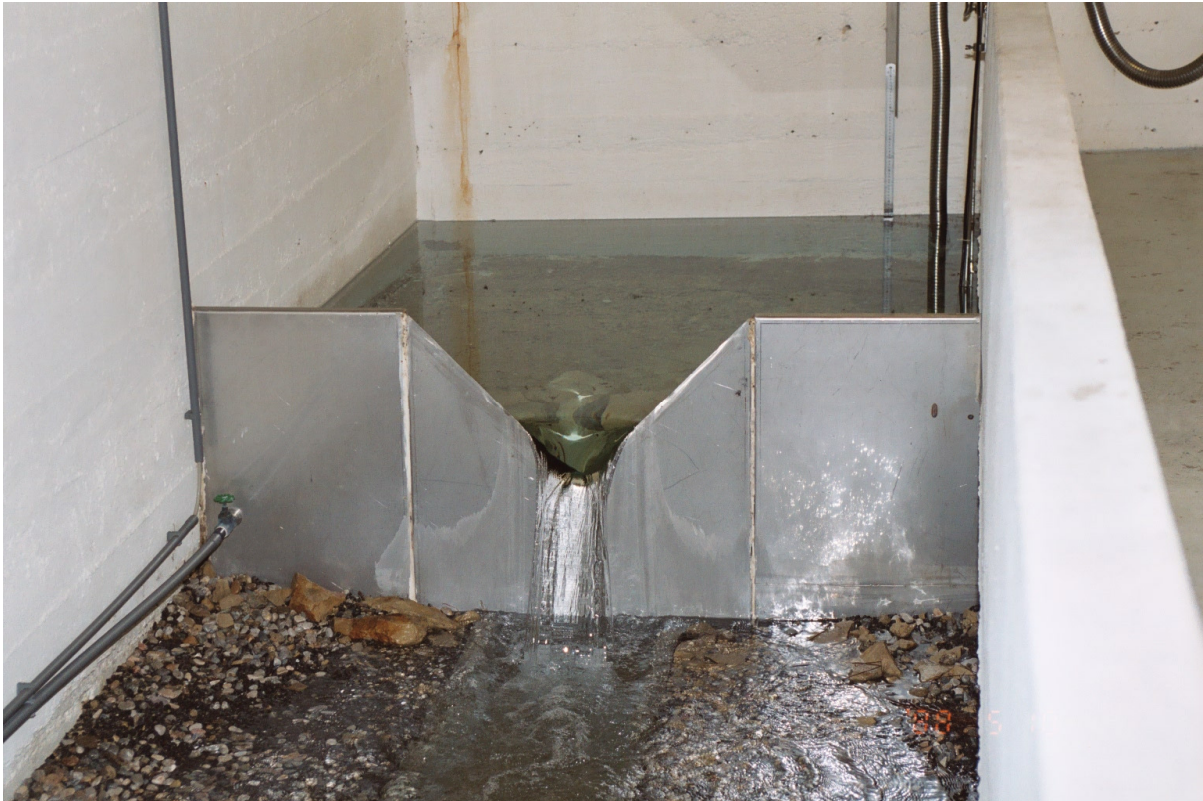
Messstelle in einer Quellstube mit Dreieckswehr (Windener Quelle, Burgenland, © Jutta Eybl)
