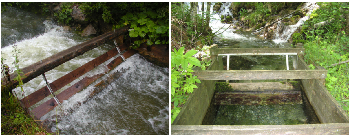
Schwimmkörper nach Gesson zur Wellenreduktion, unterschiedliche Ausführungen (links Sagtümpel, Steiermark, © HD-Steiermark, rechts Katzensteigquelle, Tirol, © HD-Tirol)
