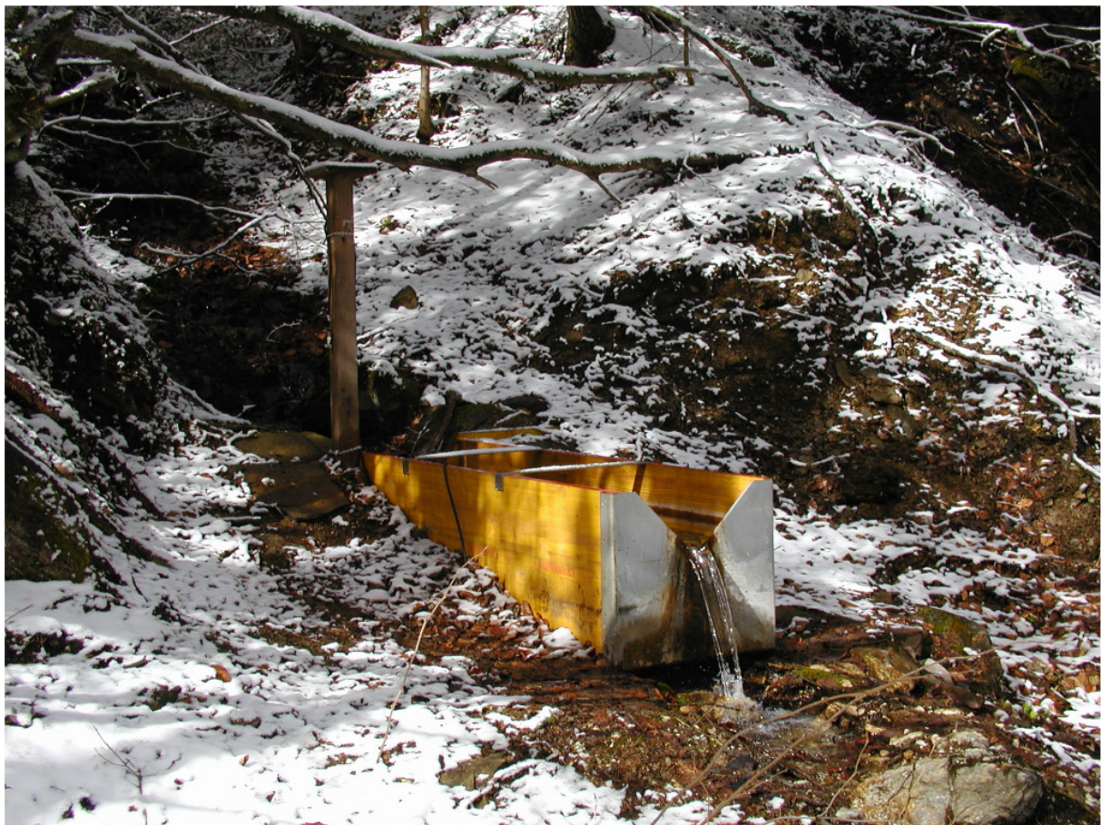
Messstelle mit Wehrkasten aus Schaltafeln und Dreieckswehr (Thompsonwehr) aus NIROSTA (Landesmessstelle Klausbach, Steiermark, © HD-Steiermark)
