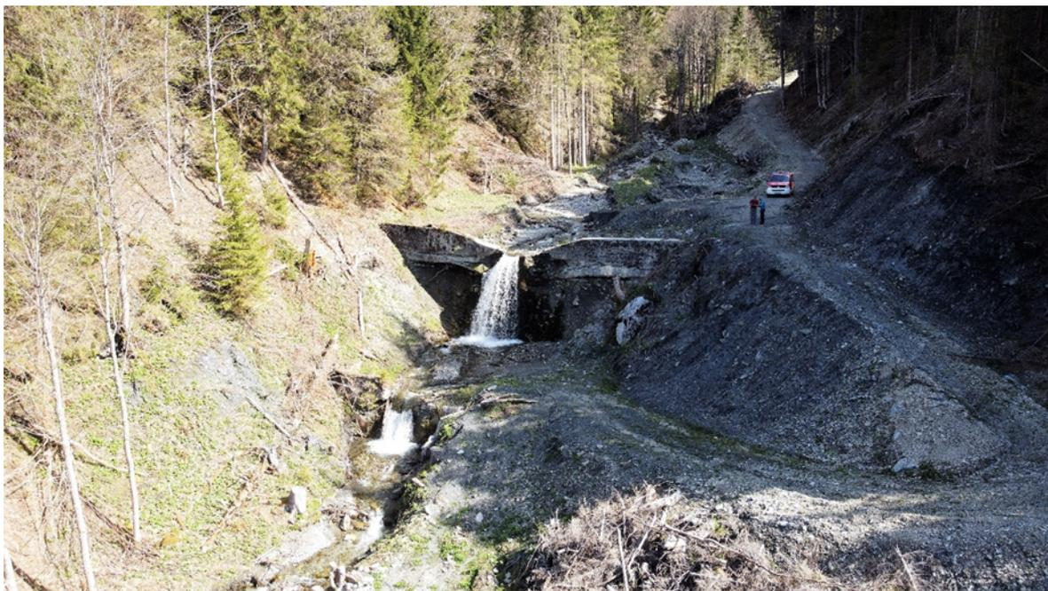
*Abbildung 1: Veraltete Konsolidierungssperre welche im Zuge des geplanten Sanierungs-Projekts durch eine neue halboffene Filtersperre ersetzt wird.*
