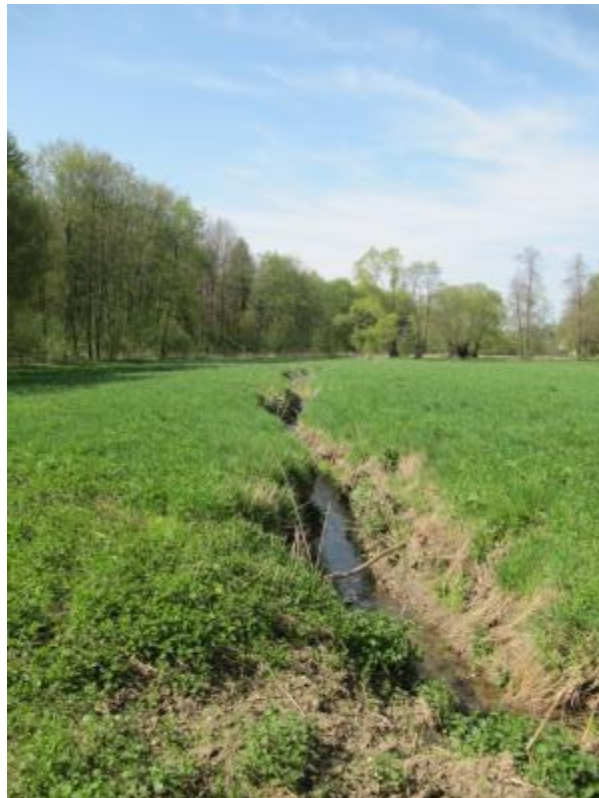
Abbildung 6 Zaya Oberlauf (Foto: M. Schindler)
