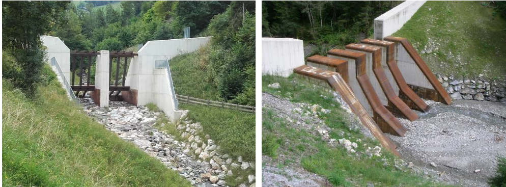
Abbildung 2 und 3: Bautype Dosiersperre und Murbrecher
