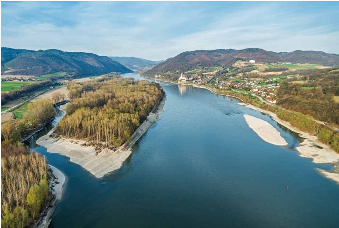
Abbildung 1 Kiesstrukturen und neu errichteter, durchströmter Nebenarm bei Schallemmersdorf-Schönbühel (Foto: extremfotos.com).
