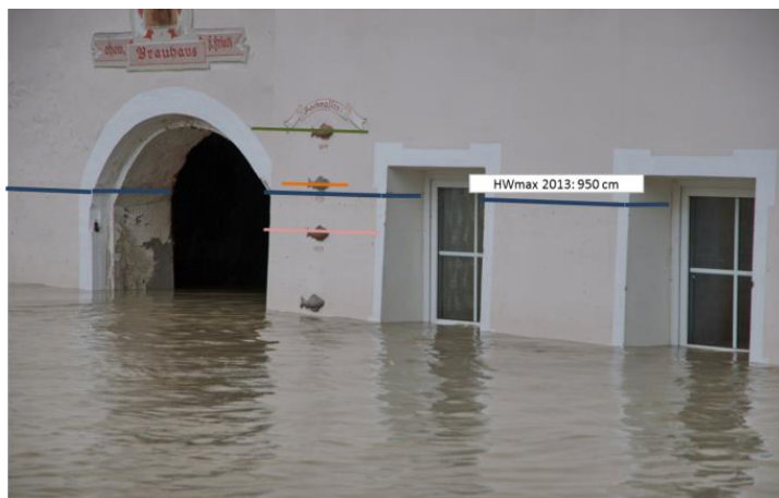
Abbildung 10: Hochwassermarken beim ehemaligen Gasthaus Friedl (Brauhaus) in Burghausen/Ach an der Salzach
