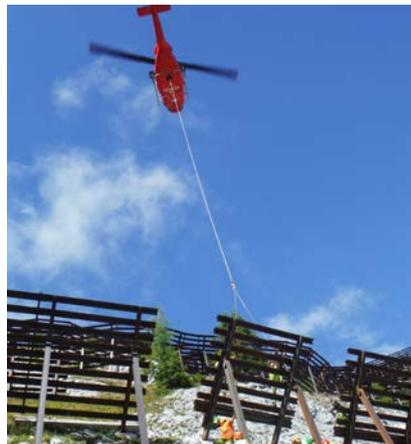
Einfliegen von Stahlschneebrücken
