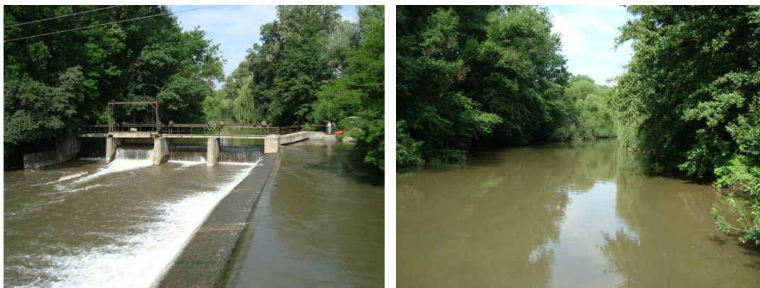
Abb. 16: Wehranlage und Rückstaubereich der Leitha bei Gattendorf
