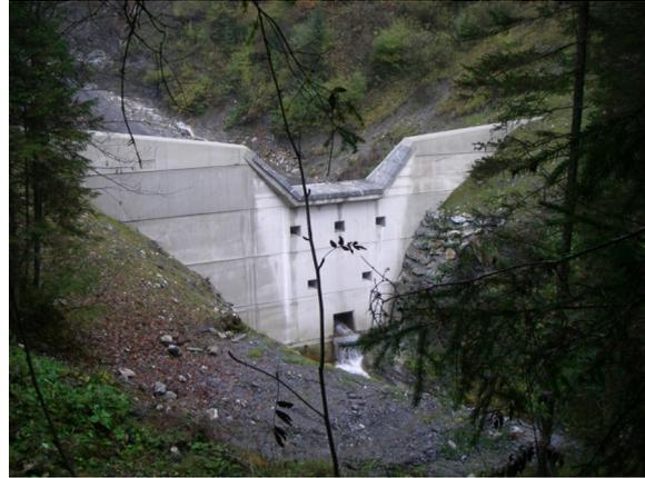
Abb. 3: Bautyp Konsolidierungssperre
