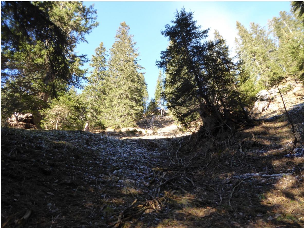
Abbildung 1: Bereich des zu verbauenden Lawinenanbruchgebietes der Rützler- Schwendelawine
