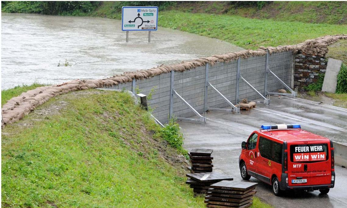
Abbildung 6-9: Dammbalkenverschluss bei der Bundesstraße B3 (Quelle: bilder.mzibo.net)
