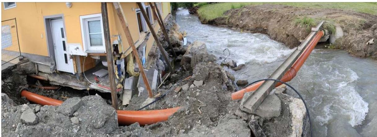
Abbildung 6-31: Beschädigung des Fundamentes (Quelle: IWHW)
