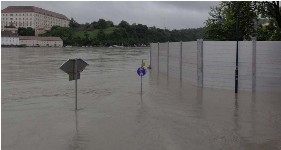
Abbildung 6-5: Mobiler Hochwasserschutz Alt Urfahr West am 02.06.2013 (Quelle: flickr.com)
