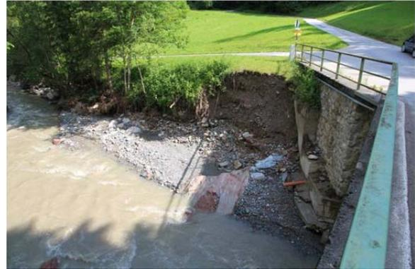
Abbildung 6-29: Links: Absacken der Terrasse in unmittelbarer Ufernähe (Quelle: IWHW); Rechts: Freilegung der Brückeneinbindung in der Gemeinde Söll (Quelle: IWHW)
