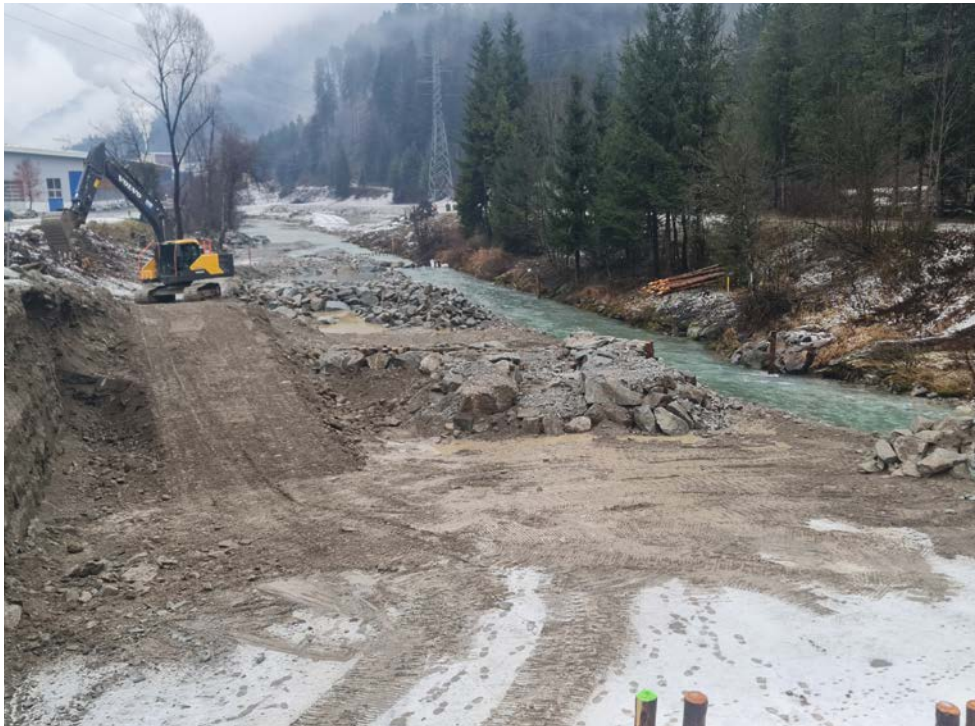
Blocksteinrampe im Dezember 2023, Aufnahme während der Bauarbeiten
