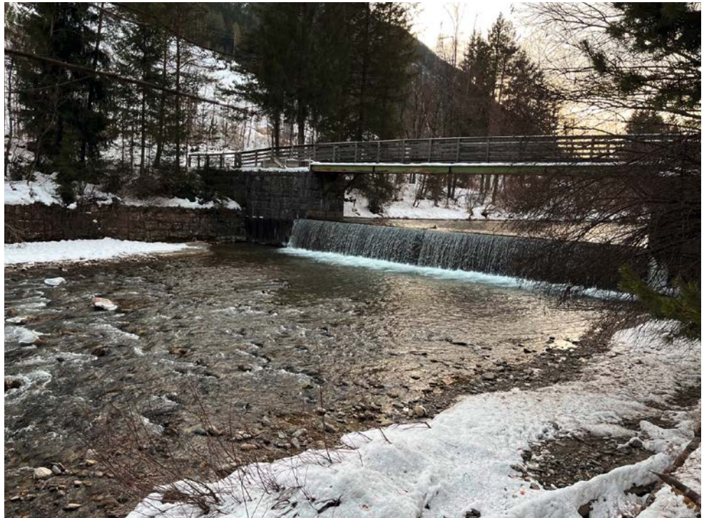
Larsenwehr vor Baubeginn
