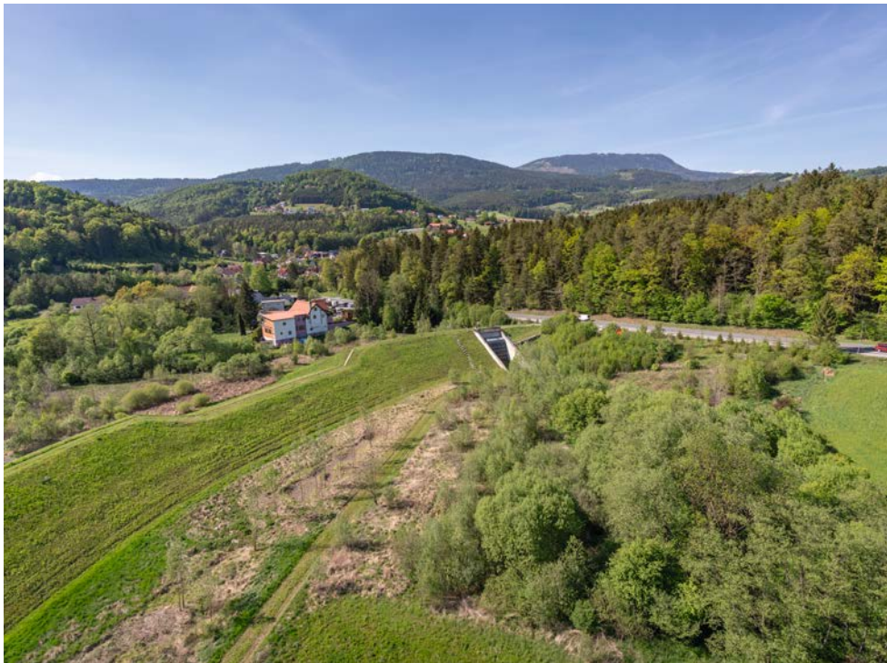
Bereits hergestelltes Hochwasserrückhaltebecken flussabwärts des 4. Bauabschnitt
