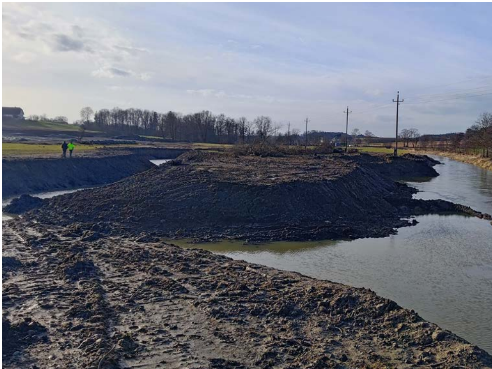
Beginn der Bauarbeiten im Jänner 2024
