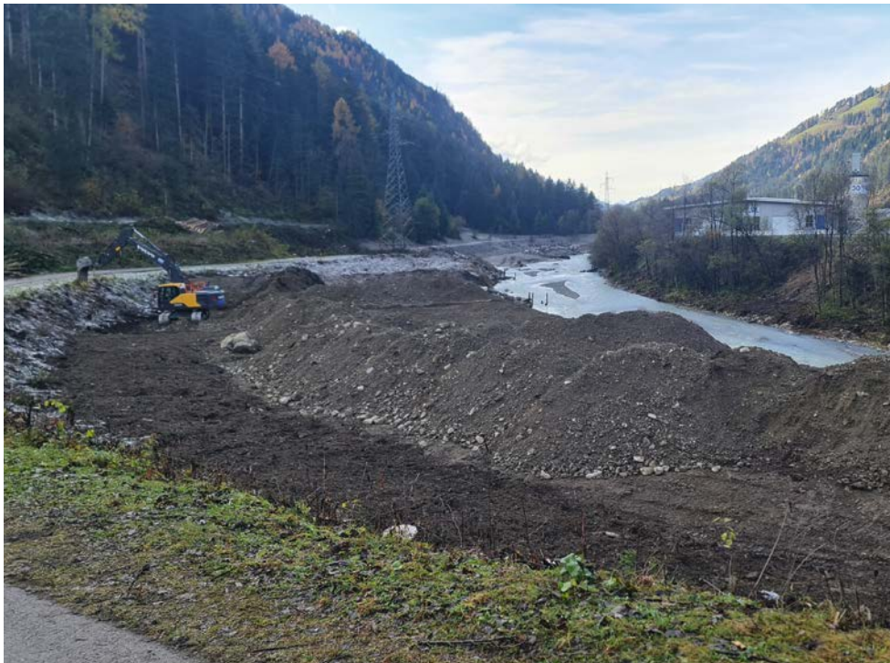
Nebenarm im November 2023, Aufnahme während der Bauarbeiten
