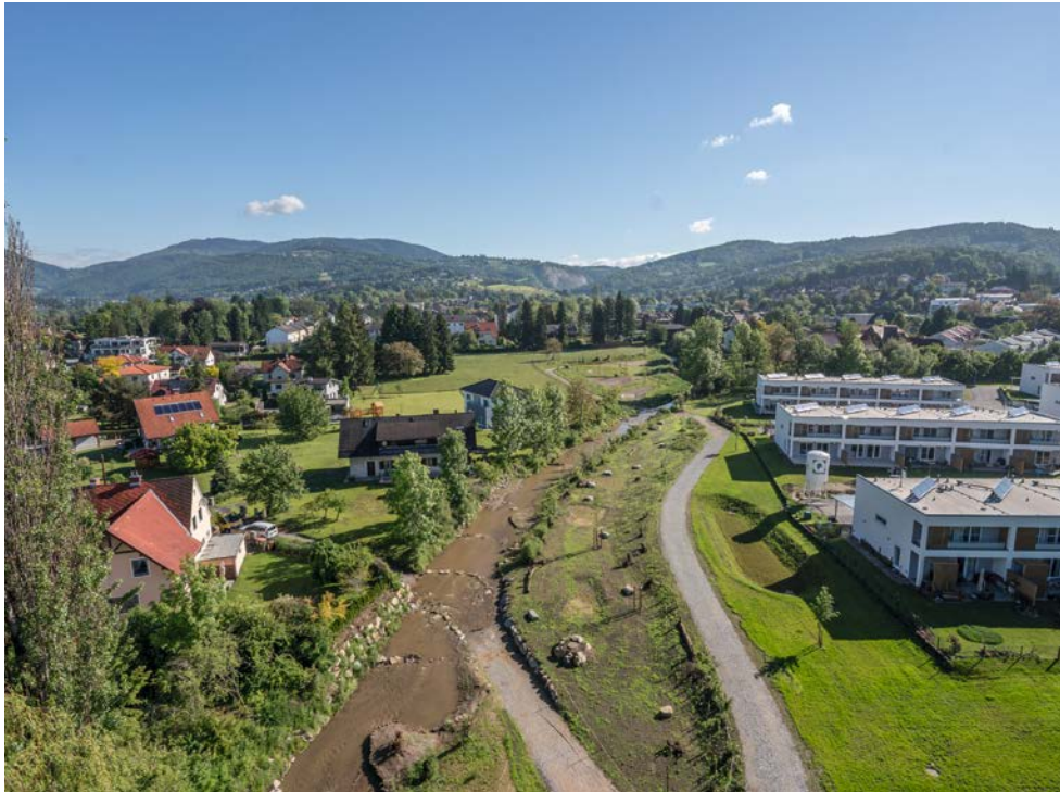
Schöcklbach mit bereits aufgeweitetem und strukturiertem Gewässerbett und abgesenkten Vorländern
