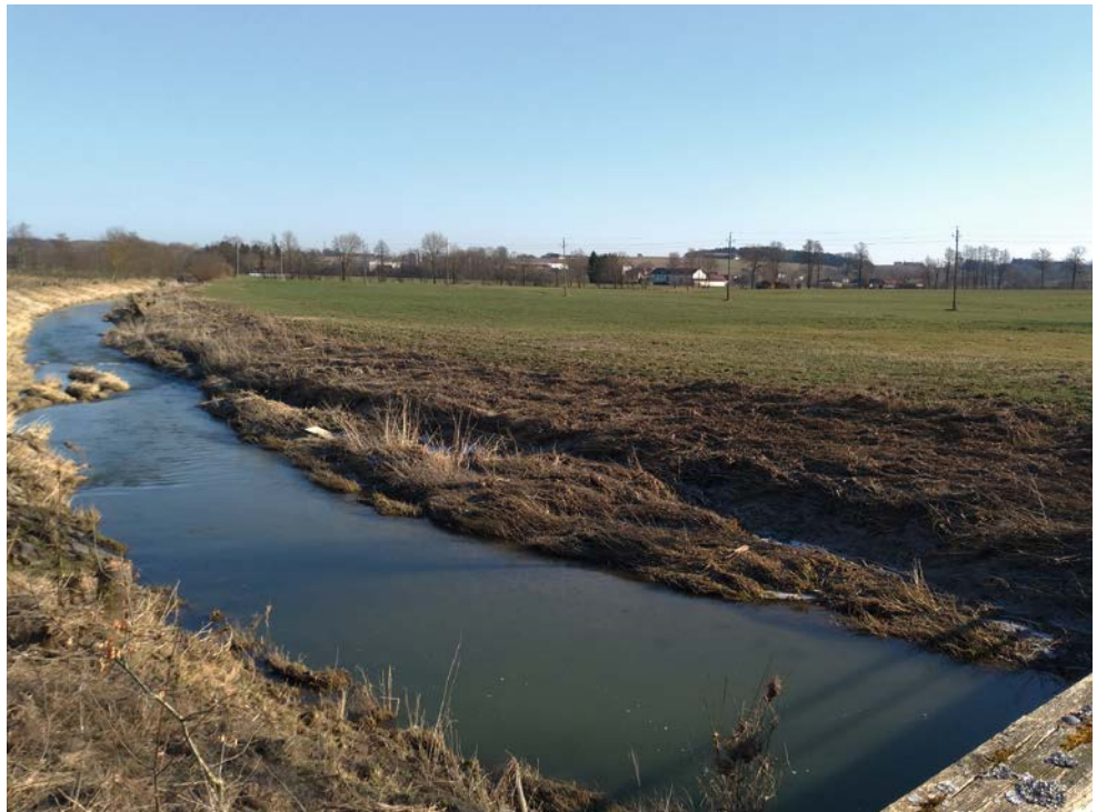
Aschach im Februar 2023, Aufnahme vor Baubeginn
