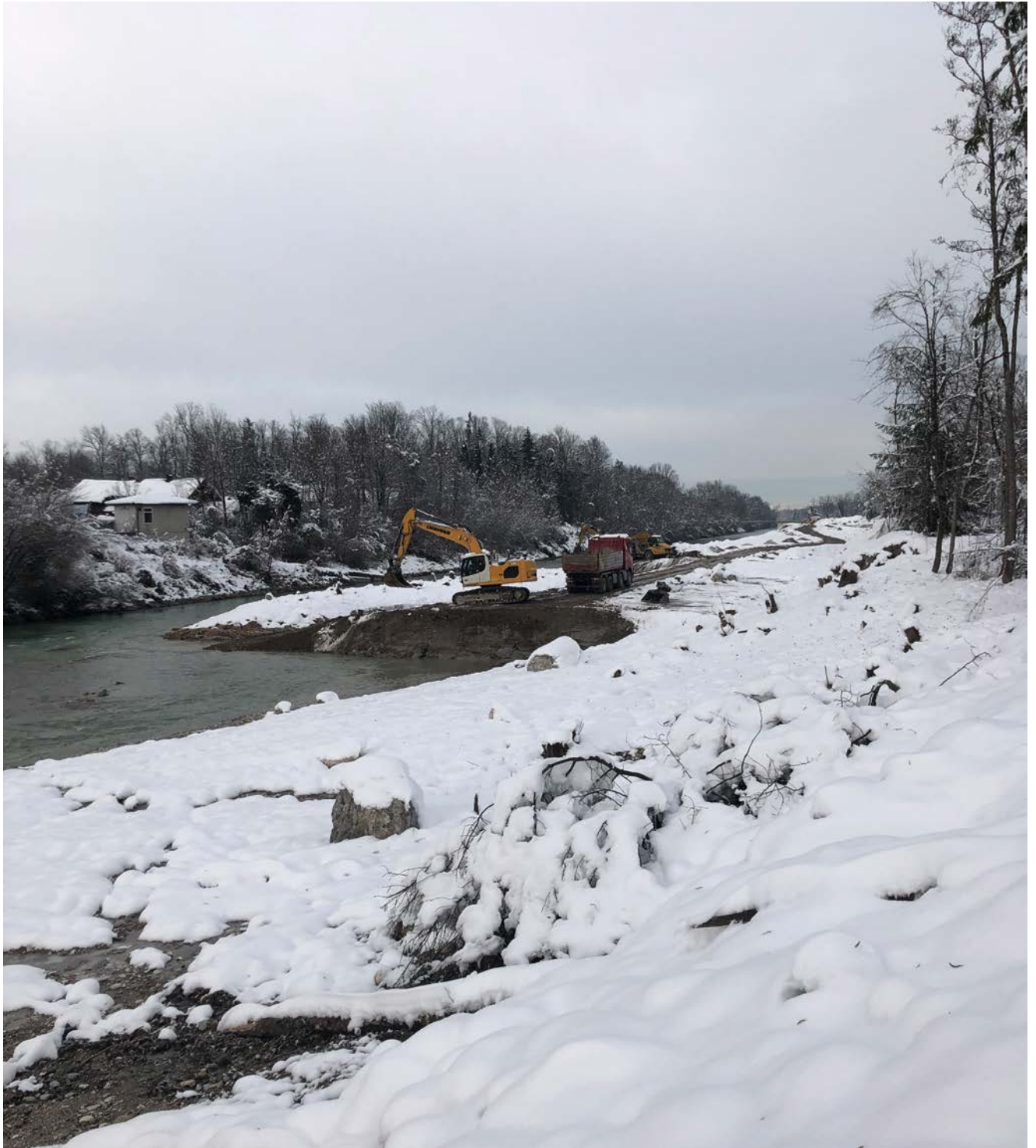
Aushubarbeiten im Aufweitungsbereich des Bauabschnittes 3 im Dezember 2023
