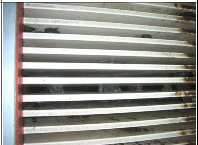
Mikro L2: Nur wenige Stellen mit Verblockungen zwischen den Membranplatten feststellbar.
