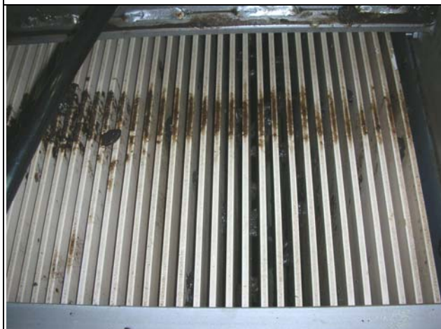
Mikro L2 kurz nach Herausheben aus dem Belebungsbecken.
