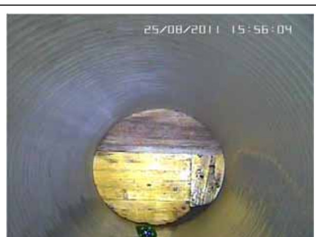
Abbildung 49 - BBE-C: Andere Hindernisse, allgemein; Nennw.-Red.=1%; Kreisprofil DN 800 - Polypropylen; elektr. Spiegel 2
