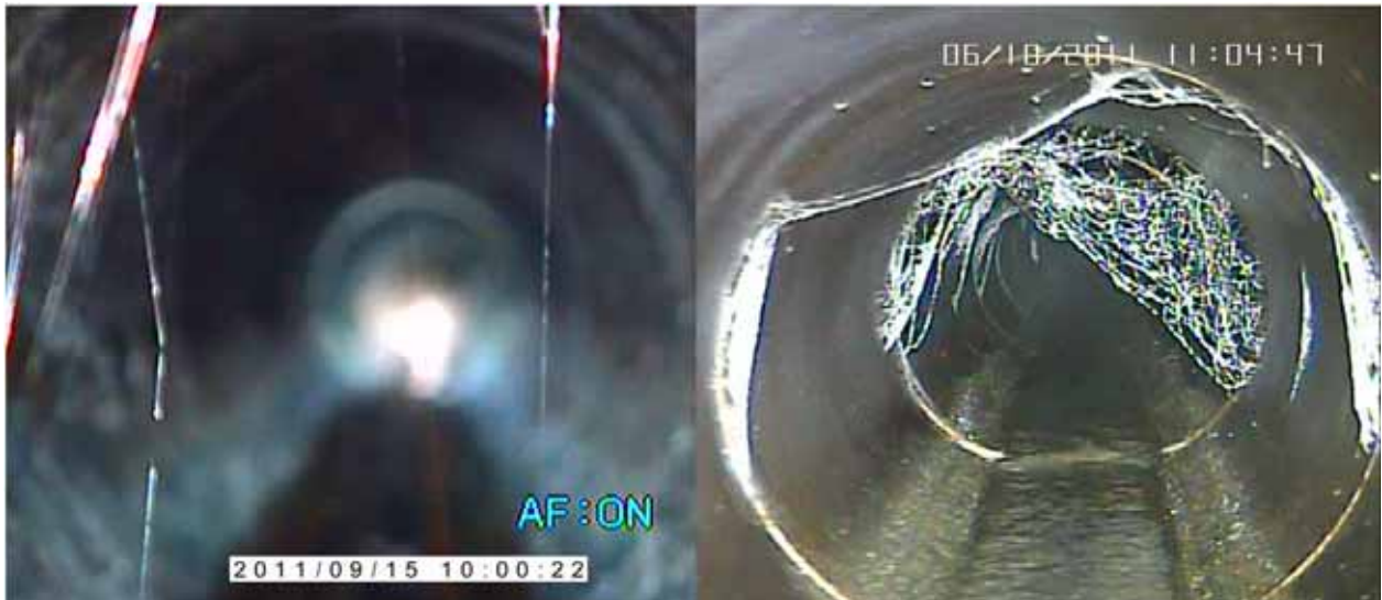
Abbildung 99 - Spinnweben als betriebliche Hindernisse bei der Zustandserfassung
