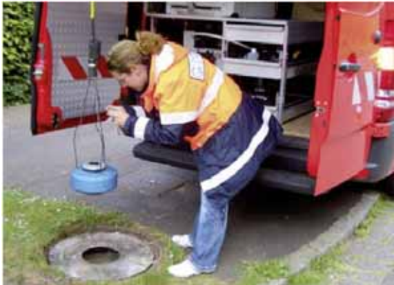
Abbildung 20 - IBAK PANORAMO SI im Einsatz (bi-UmweltBau, 2009)
