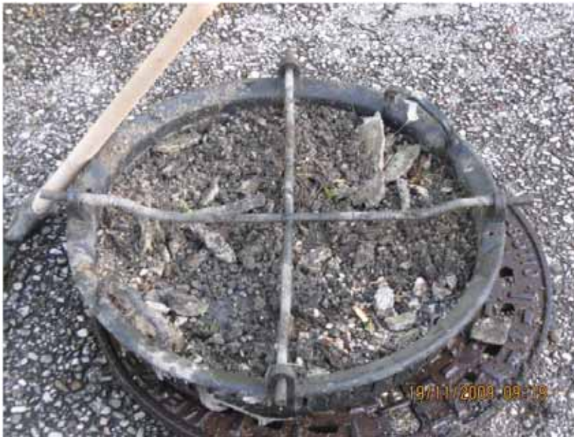
Abbildung 24 - Überfüllter Schmutzfänger
