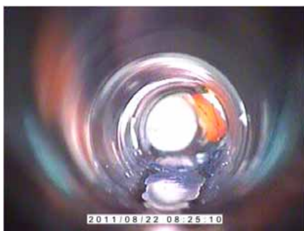
Abbildung 73 - BAG einragender Anschluss; L=17%; Kreisprofil DN 260 - Glasfaserverstärkter Kunststoff; elektr. Spiegel 1
