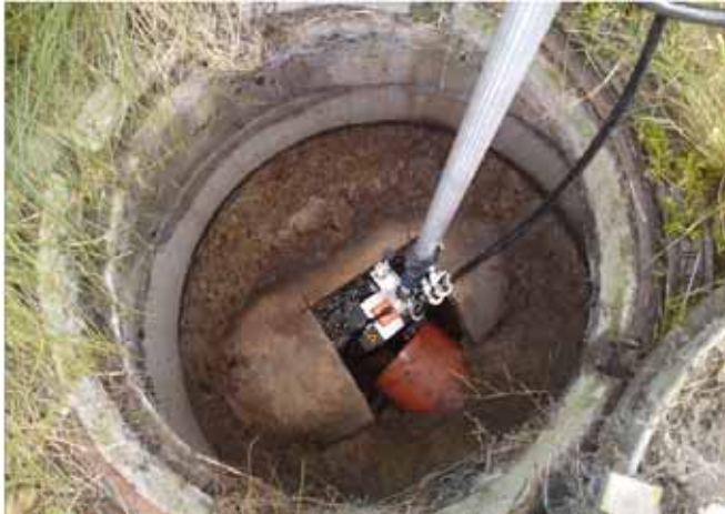
Abbildung 97 - nachträglich gesetzter Schacht für Hausanschluss
