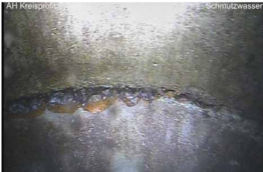
Abbildung 201 - DAI - Einragendes Dichtungsmaterial
