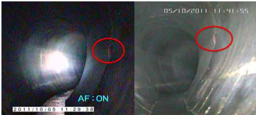
Abbildung 83 - unterschiedliche Ausleuchtung einer Haltung (Plihal, 2013b)
