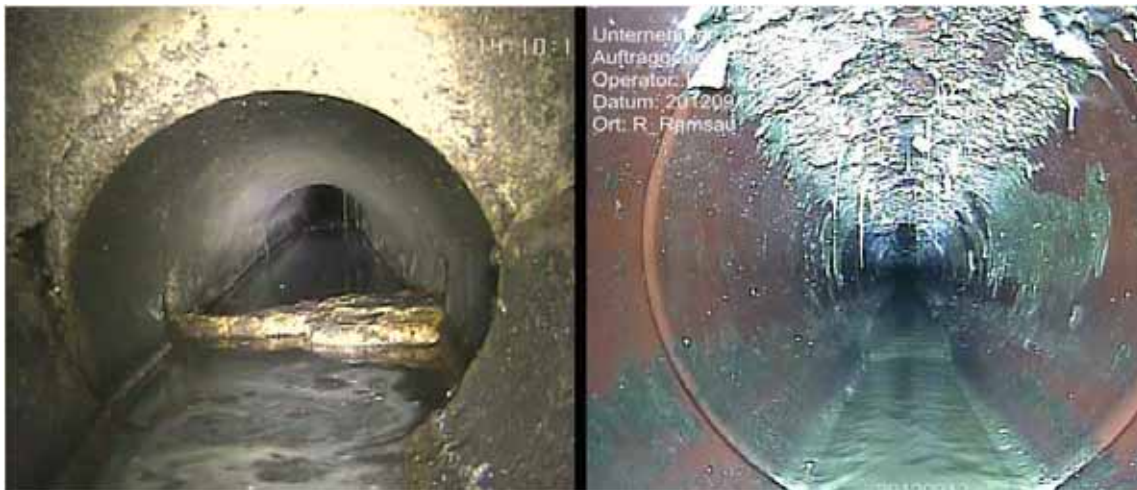
Abbildung 23 - Haltungen mit Reinigungsbedarf
