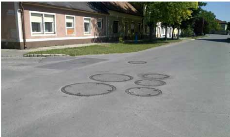
Abbildung 150 - Anhäufung von Schachtdeckeln (BOKU Wien, 2011)
