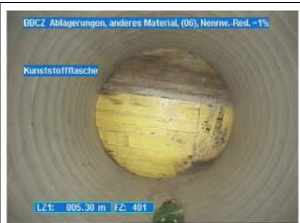
Abbildung 47 - BBE-C: Andere Hindernisse, allgemein; Nennw.-Red.=1%; Kreisprofil DN 800 - Polypropylen; TV-Kamera 1
