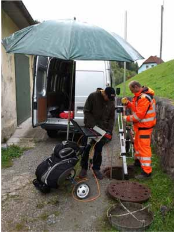
Abbildung 210 - Schachtinspektion mit Golf-Caddy bei schlechtem Wetter
