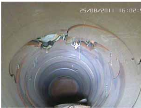
Abbildung 42 - BAB-C-C Rissbildung, klaffender Riss, komplex - Scherbe; B=8mm; Kreisprofil DN 300 - Steinzeug; elektr. Spiegel 2
