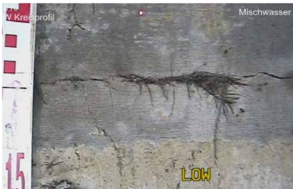
Abbildung 203 - DBA - Wurzeln
