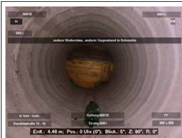
Abbildung 46 - BBE-C: Andere Hindernisse, allgemein; Nennw.-Red.=1%; Kreisprofil DN 800 - Polypropylen; Scan System 2
