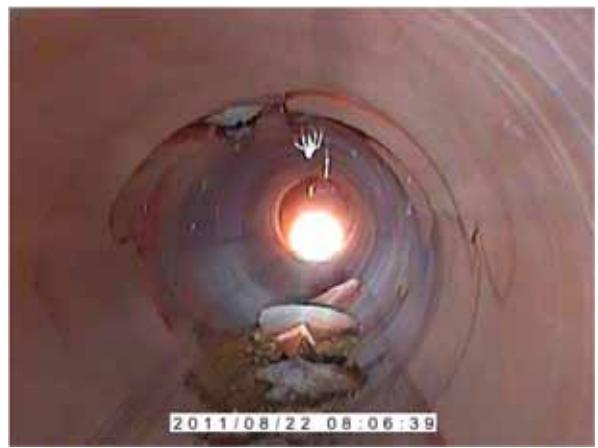
Abbildung 43 - BAB-C-C Rissbildung, klaffender Riss, komplex - Scherbe; B=8mm; Kreisprofil DN 300 - Steinzeug; elektr. Spiegel 1
