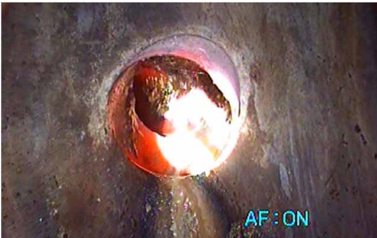
Abbildung 205 - Einragender Anschluss, DCA - Anschluss, DCG - Anschlussleitung
