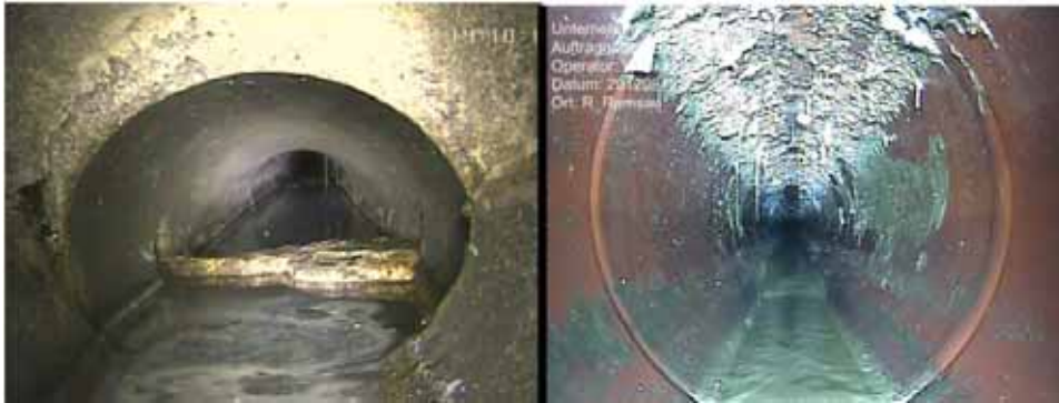
Abbildung 87 - Beispiele zur betrieblichen Zustandserfassung
