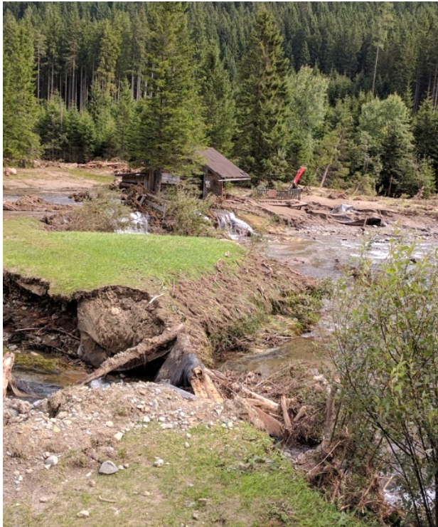
Bild 5: Hochwasserschäden am 6. August 2017 im steirischen Katschtal
