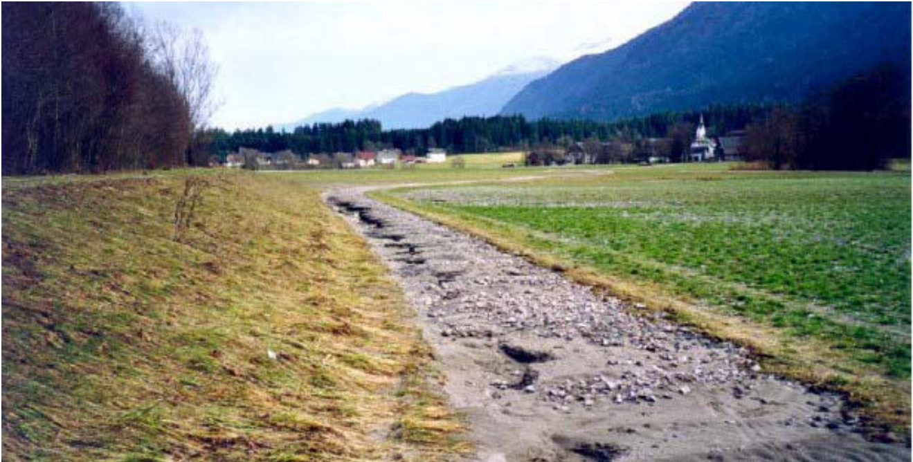
Abbildung 2-18: Überströmstrecke der Gail, Erosionsschäden am Begleitweg nach dem Hochwasser 2002
