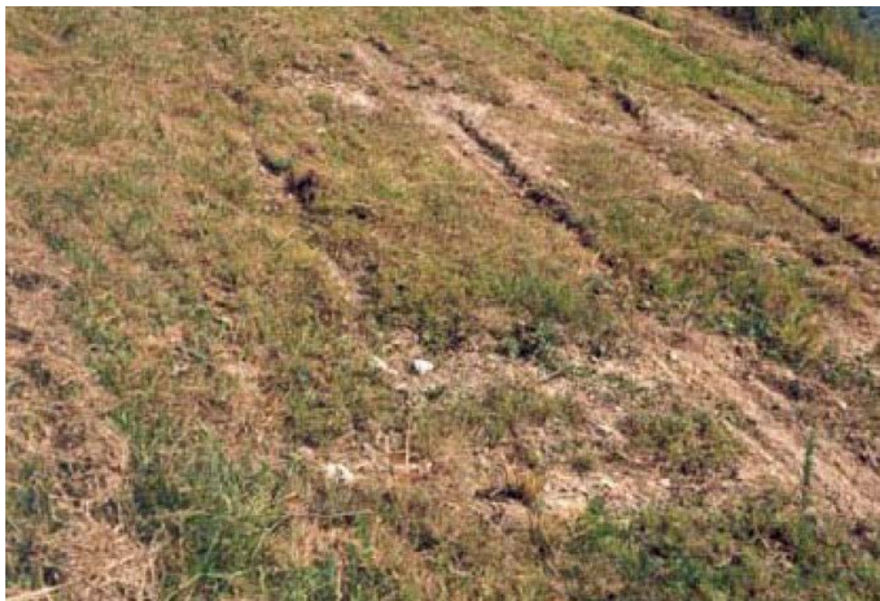
Abbildung 2-16: Rillen und Gully-Erosion
