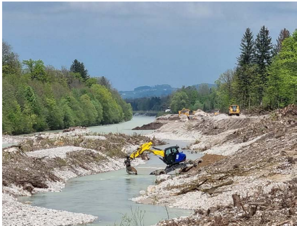
Abbildung 1-10: Sohlräumung an der Saalach
