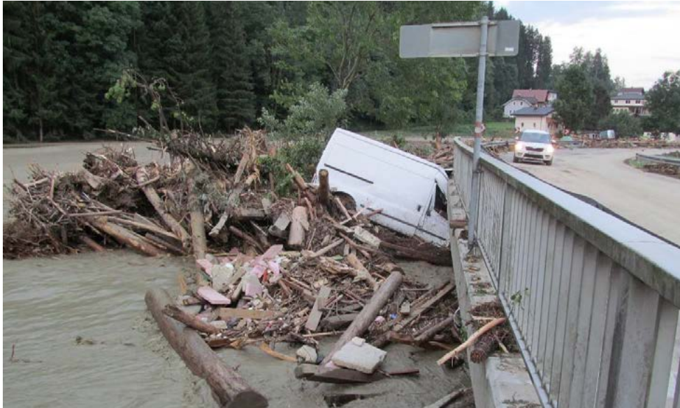
Abbildung 1-9: Verklauung einer Straßenbrücke
