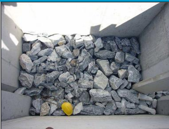
Abbildung 17: Beispiel der baulichen Umsetzung der rauen Sohle, (Foto: LEHMANN)
