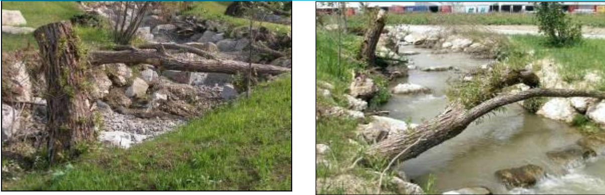
Abbildung 30 und Abbildung 31: Kristeinerbach, Sohlraugigkeit und bis zur Sohle durchgehende raue Beckenübergänge, Beschattung und Unterstände durch austriebsfähige Weidenstöcke vor und nach Flutung (Bauaufsichtsbericht Kristeinerbach, ULLMANN 2008).
