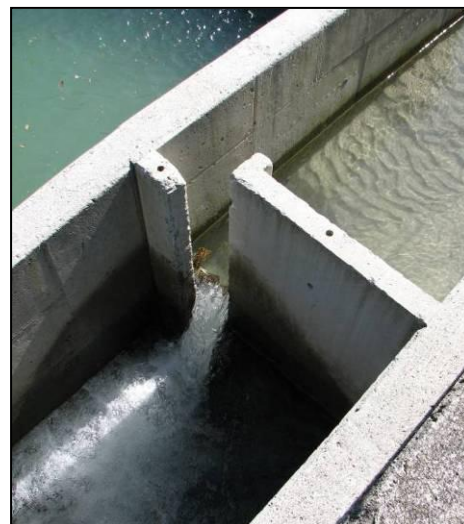
Abbildung 12 und Abbildung 13: Typische Verklausungsprobleme bei Schlitzpässen, weshalb von allen Autoren auf die Wahl einer ausreichenden Schlitzweite hingewiesen wird (beide Fotos: A. LUNARDON).
