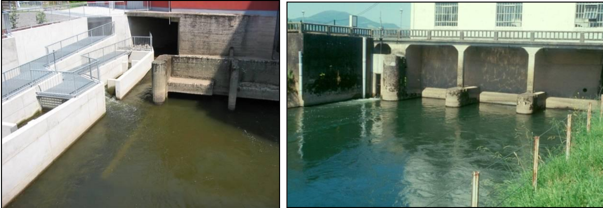
Abbildung 9 und Abbildung 10: Optimale Anordnung eines FAH Einstieges an einem Wehr mit Turbine, am Ufer auf der Höhe des Wehres mit deutlich zu erkennendem Leitstromimpuls im Bereich des FAH Einstieges, die sich deutlich von der Umgebungsströmung abhebt (DUMONT et al. 2005).
