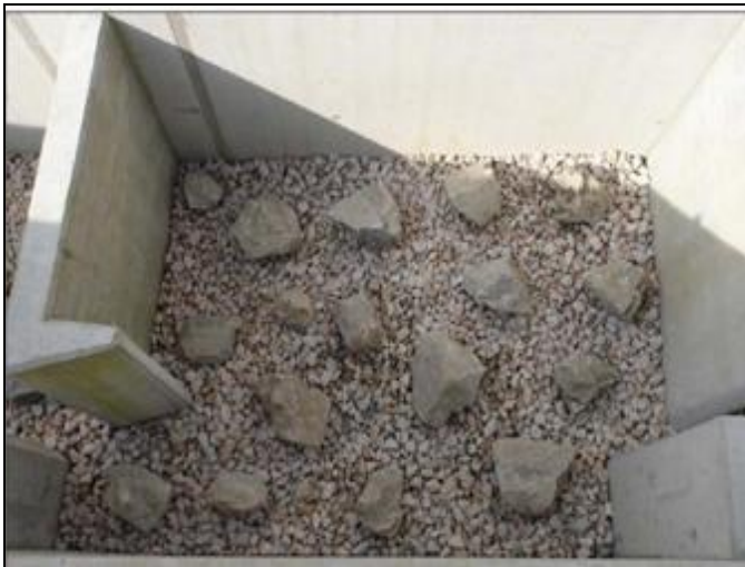
Abbildung 19: Beispiel der baulichen Umsetzung der rauen Sohle. Nach neuen Erkenntnissen sollte die Belegung weniger dicht sein. Sohlsubstrat muss ausreichend groß dimensioniert werden, sodass es vor allem im Bereich des Schlitzes und flussab zu keiner Verlagerung des Substrates kommt ( Foto: RÜCKER)
