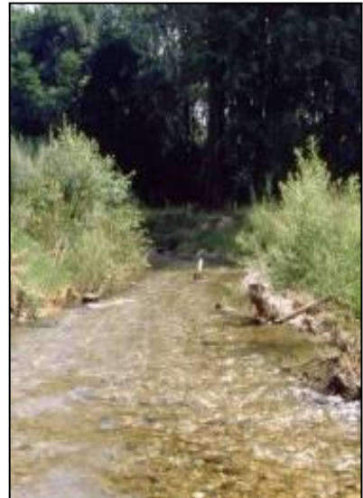
Abbildung 25 und Abbildung 26: Gewässertypspezifisches Umgehungsgerinne vom Gewässerbett völlig abgesetzt, dynamisch dotiert (Fotos: ezb).
