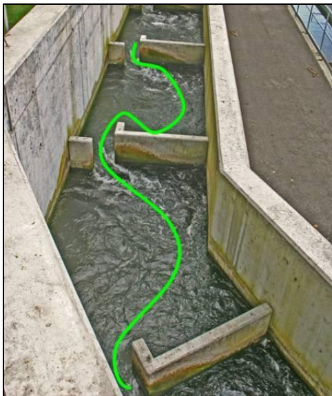
Abbildung 35: Schlitzpass („Vertical slot“) mit der erforderlichen Strömungsausprägung (JÄGER und ZITEK 2009)
