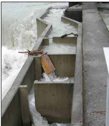
Abbildung 12 und Abbildung 13: Typische Verklausungsprobleme bei Schlitzpässen, weshalb von allen Autoren auf die Wahl einer ausreichenden Schlitzweite hingewiesen wird (beide Fotos: A. LUNARDON).
