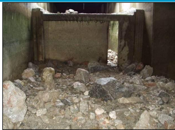
Abbildung 18: Beispiel der baulichen Umsetzung der rauen Sohle, (Foto: P. JÄGER)
