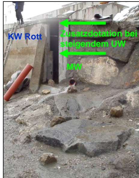
Abbildung 3 und Abbildung 4: Sohlanbindung im Unterwasser im Bereich des Turbinenauslasses durch ansteigende Rampe mit rauer Sohle, KW Werfen, Salzach (links) und Sohlanbindung im Unterwasser an natürliche Sohle, im direkten Bereich des Einstieges befestigt, KW Rott, Saalach; ersichtlich ebenfalls die Lage des Unterwasserspiegels bei unterschiedlichen Wasserführungen und die daraus abgeleitete Notwendigkeit einer dynamischen Zusatzdotierung zur Aufrechterhaltung der Ausströmgeschwindigkeit und damit der Auffindbarkeit (rechts) (JÄGER und ZITEK 2009).
