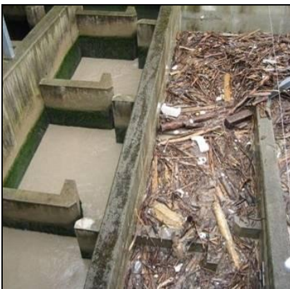
Abbildung 21: Massiver Eintrag von Geschwemmel in einen Schlitzzpass (Foto: A. LUNARDON)
