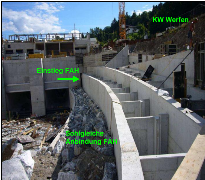
Abbildung 3 und Abbildung 4: Sohlanbindung im Unterwasser im Bereich des Turbinenauslasses durch ansteigende Rampe mit rauer Sohle, KW Werfen, Salzach (links) und Sohlanbindung im Unterwasser an natürliche Sohle, im direkten Bereich des Einstieges befestigt, KW Rott, Saalach; ersichtlich ebenfalls die Lage des Unterwasserspiegels bei unterschiedlichen Wasserführungen und die daraus abgeleitete Notwendigkeit einer dynamischen Zusatzdotierung zur Aufrechterhaltung der Ausströmgeschwindigkeit und damit der Auffindbarkeit (rechts) (JÄGER und ZITEK 2009).
