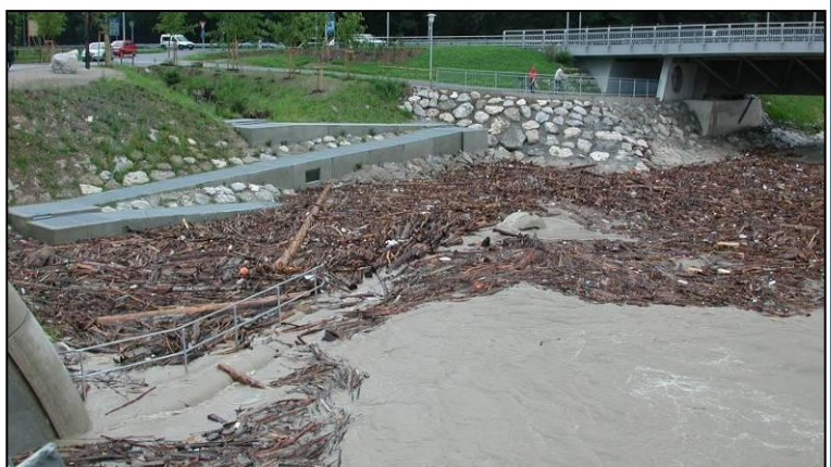
Abbildung 22: Treibgutbelastung im unterwasserseitigen Einstiegsbereich des KW Rott, Saalach (rechts, Foto: Salzburg AG).
