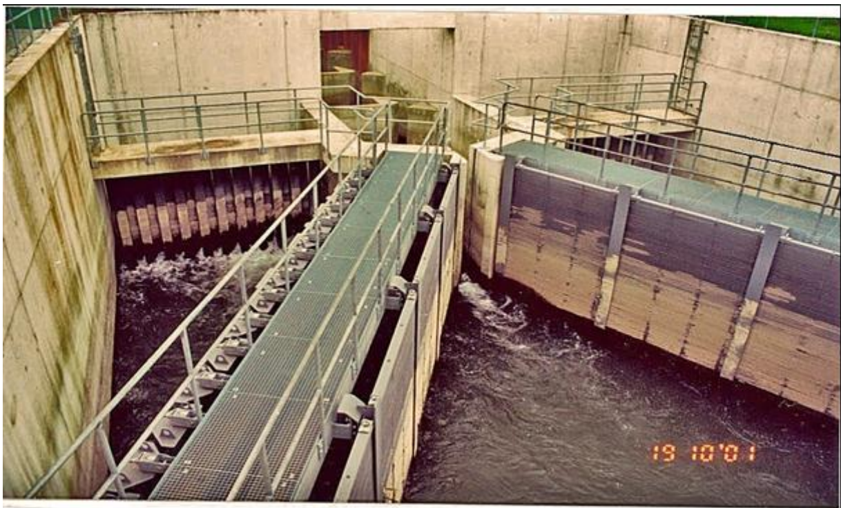
Abbildung 11: KW Iffezheim, energiearmes Einbringen der Leitstromzusatzdotation in den Fischpasseinstieg über strömungsberuhigende senkrechte und waagrechte Leiteinrichtungen. Im spitzen Winkel mündet die Basisdotation der FAH. Verhältnis Leitstrom zur Basisdotation 10 : 1 (Foto: P. JÄGER, 2001).
