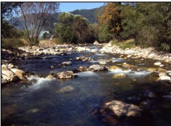
Abbildung 37: Aufgelöste Sohlrampe (Foto: ezb)
