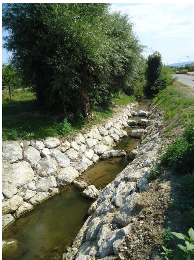
Naturnahes Umgehungsgerinne beim Kraftwerk Niklasdorf an der Mur, © BMLFUW/DI Verena Ressel
