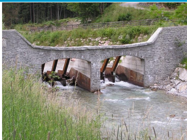
Geschiebesperre Foto: © Helena Mühlmann
