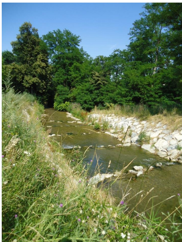
Aufgelöste Rampe an der Wulka in Pöttelsdorf, © BMLFUW/DI Verena Ressel
