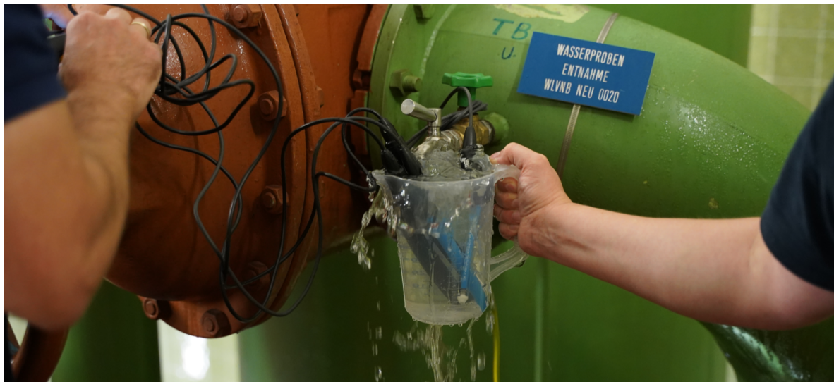
Bei einer Wasserprobenentnahme
