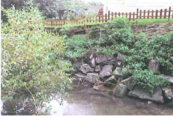
Abbildung 7-115: Links: Abgesackte Steinsicherung in der Polsenz (Quelle: GWB Grieskirchen); Rechts: Brückendurchlass an der Kleinen Rodl (Quelle: GWB Grieskirchen)
