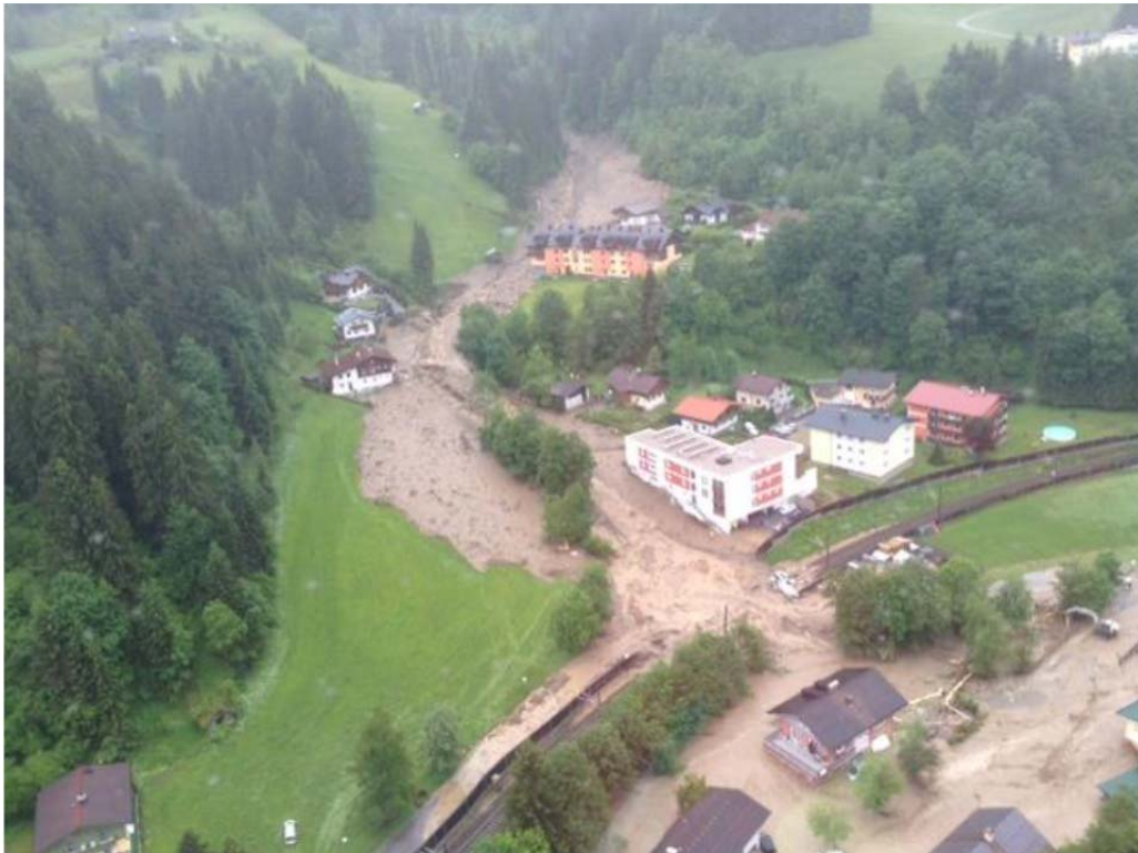
Abbildung 8-13: : Übersicht Kegelbereich des Sattelbaches unmittelbar nach dem Ereignis (die-wildbach, 2013)
