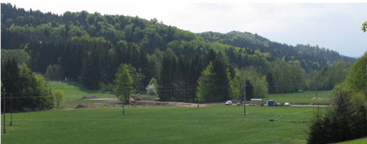
Abbildung 8-24: Rückhaltebecken am Grubmühlbach (Quelle: wv-ache.at)
