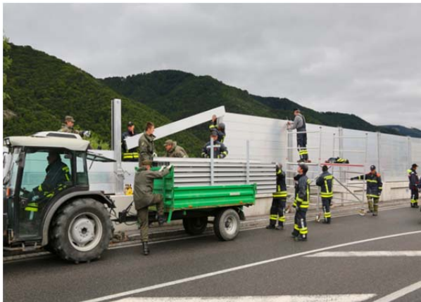
Abbildung 8-5: Links: Mobiler Hochwasserschutz in Weißkirchen (wachaufoto.at, 2013); Rechts: Mobiler Hochwasserschutz in Spitz an der Donau (BVZ, 2013)
