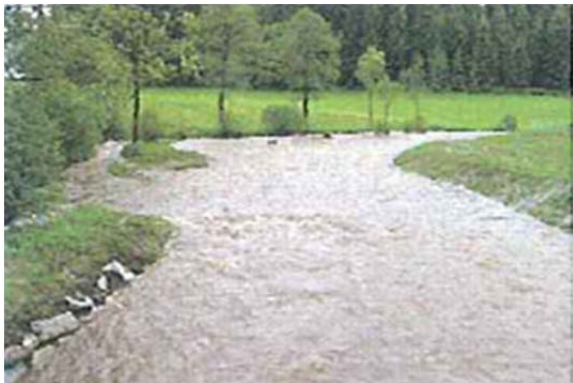
Abbildung 7-110: Links/Rechts: Unterspülte Steinsicherung des Distelbaches (Quelle: GWB Grieskirchen)
