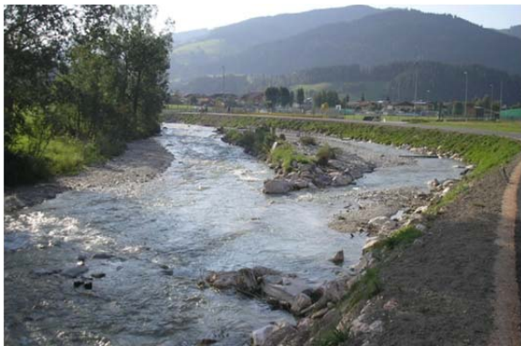
Abbildung 8-12: Links: Ennsaufweitung im Zuge HWS Enns Flachau 2012 (Quelle: Amt der Salzburger Landesregierung); Rechts: Die Enns in Altenmarkt (Quelle: Amt der Salzburger Landesregierung)
