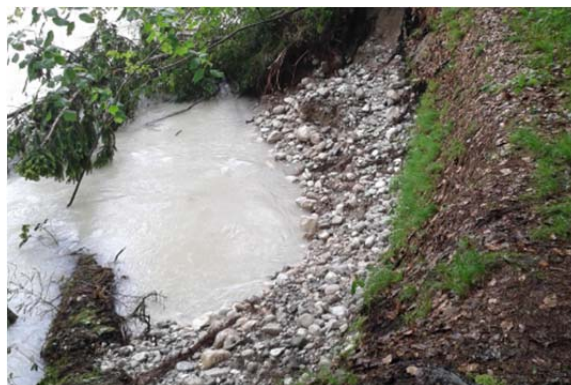
Abbildung 7-114: Links: Geschiebeablagerungen entlang des Ufers der Alm (Quelle: GWB Gmunden); Rechts: Abgerutschter Uferbegleitweg in Pettenbach (Quelle: GWB Gmunden)
