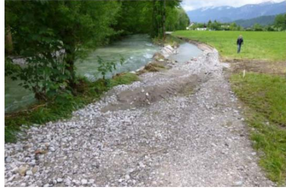
Abbildung 7-120: Links: Zerstörte Uferverbauung entlang der Teichl (Quelle: GWB Linz); Rechts: Weggespülter Güterweg (Quelle: GWB Linz)
