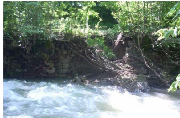
Abbildung 7-118: Links: im Bereich der Zufahrtsstraße der Landwirtschaftsschule (GWB Linz) Rechts: Die beschädigte Trockensteinmauer (Quelle: GWB Linz)
