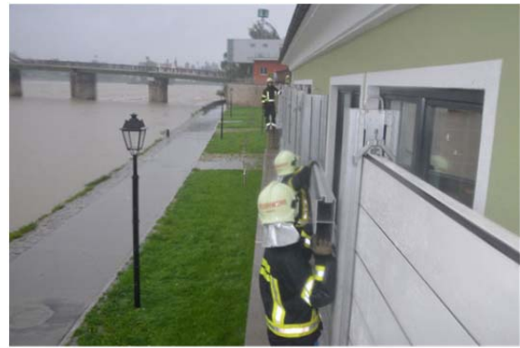
Abbildung 8-25: Links: Mobiler Hochwasserschutz in Schärding (Quelle: ooe.orf.at); Rechts: Aufbau der mobilen Elemente von der Feuerwehr (Quelle: regionalnews.at)
