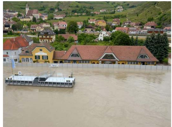
Abbildung 8-5: Links: Mobiler Hochwasserschutz in Weißkirchen (wachaufoto.at, 2013); Rechts: Mobiler Hochwasserschutz in Spitz an der Donau (BVZ, 2013)
