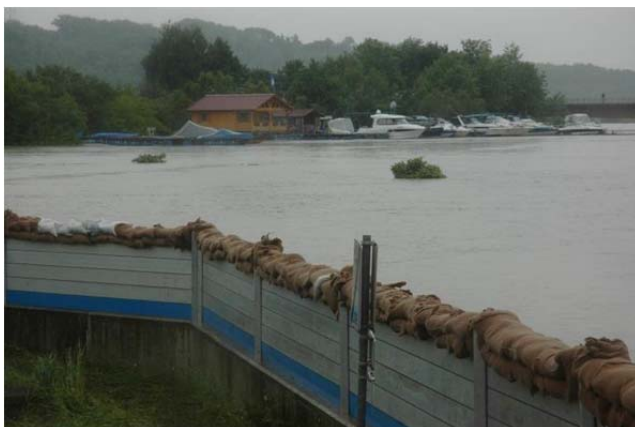
Abbildung 8-3: Mobile Hochwasserschutz-Maßnahmen in Wallsee-Sindelburg (BVZ, 2013)
