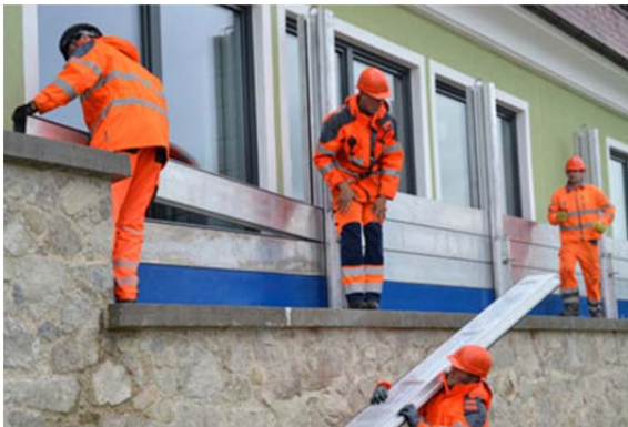
Abbildung 8-25: Links: Mobiler Hochwasserschutz in Schärding (Quelle: ooe.orf.at); Rechts: Aufbau der mobilen Elemente von der Feuerwehr (Quelle: regionalnews.at)
