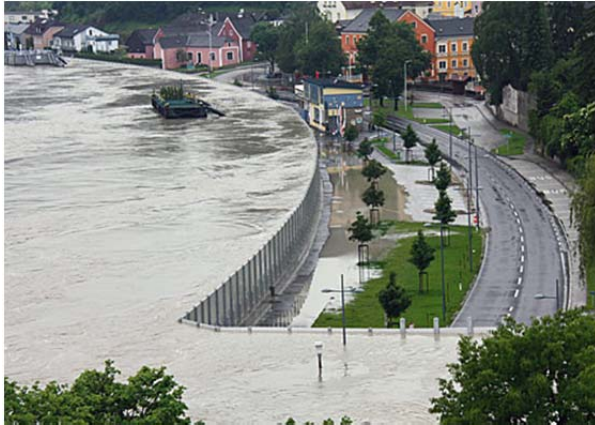
Abbildung 8-4: Mobiler Hochwasserschutz in Grein (Der Standard / OÖN, 2013)
