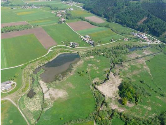
Abbildung 8-23: Rückhaltebecken Teichstätt (Quelle: land-oberoesterreich.gv.at)
