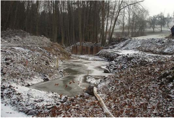
Abbildung 8-27: Links: Rückhaltebecken in Neuhofen an der Ybbs während der Bauzeit (Quelle: neuhofen-ybbs.gv.at)
