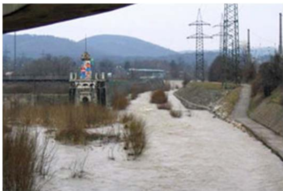
Abbildung 8-28: Links: Hochwasserschutz am Wienfluss (Quelle: wien.gv.at)
