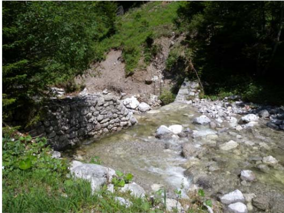
Abbildung 8-15: Links/Rechts: Steinbachgraben ~hm22 – Sperre beeinträchtigt durch seitlichen Anbruch, Vorfeldsicherung beschädigt (Quelle: IAN-Report 155)
