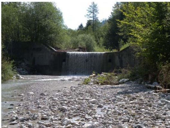
Abbildung 8-16: Links: hm 33,5, seitliche Hinterspülung, Freilegung der Sperrenflügel luftseitig (Quelle: IAN-Report 155); Rechts: hm 27,3, Vorsperre links- und rechtsufrig umflossen und freigelegt (Quelle: IAN-Report 155)
