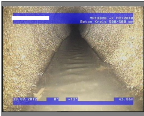
44,63m, Oberflächenschaden, Ursache nicht eindeutig feststellbar, von 4 bis 6 Uhr #continuous / Ausgewaschen
