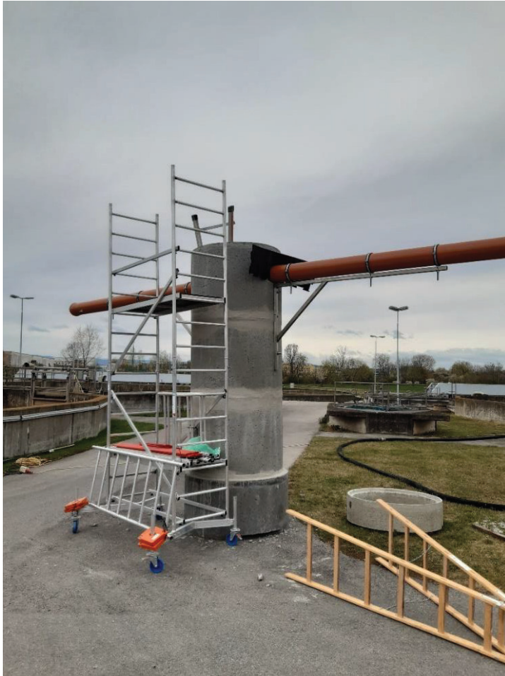
Abbildung 4 Geschlitzte Tauchrohre zur Überschussschlammmentnahme auf der großtechnische Anlage A
