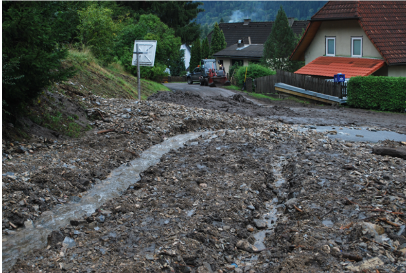
Abbildung 1: Vermurung der Gemeindestraße und des Siedlungsbereiches durch den Sonnseitenbach 2020
