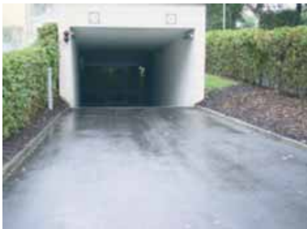
Abbildung 7-19: Gefahr des Wassereintritts bei einer Tiefgarageneinfahrt im Bereich Radkersburg (TP6.3).
