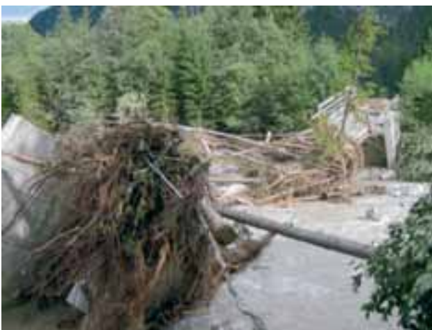
Abbildung 6-4 a, b: Verklauungen durch Schwemmholz bei Reutte (Tirol) Hochwasser 2005 (Quelle: Land Tirol).
