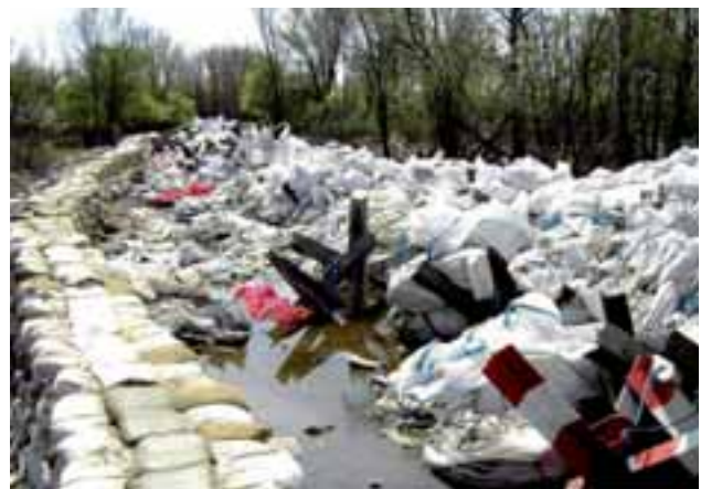
Abbildung 14-17: Dammbbruch bei Mannersdorf (links) und Jedenspeigen (rechts) (Quelle: via donau).
