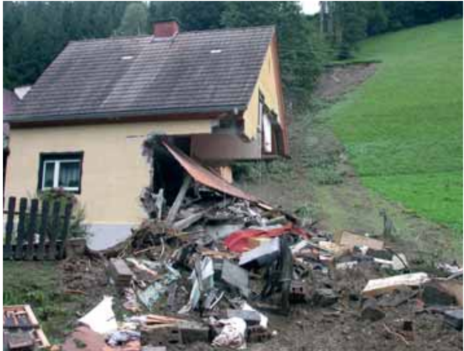
Abbildung 7-1: Ein durch eine Hangmure zerstörtes Haus in der Gemeinde Gasen (Objekt 134/7045).
