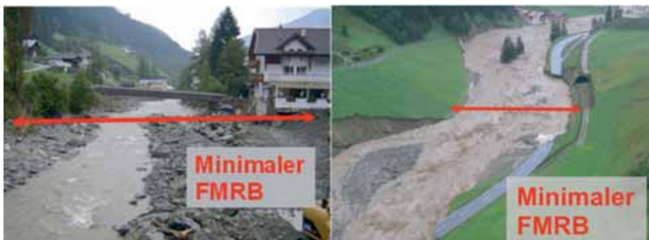
Abbildung 5-1: Darstellung des benötigten minimalen flussmorphologischen Raumbedarfs beim Hochwasser 2005 an der Trisanna. (Quelle: links BOKU-IWHW, rechts ASI.)
