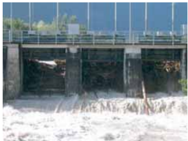
Abbildung 6-4 a, b: Verklauungen durch Schwemmholz bei Reutte (Tirol) Hochwasser 2005 (Quelle: Land Tirol).
