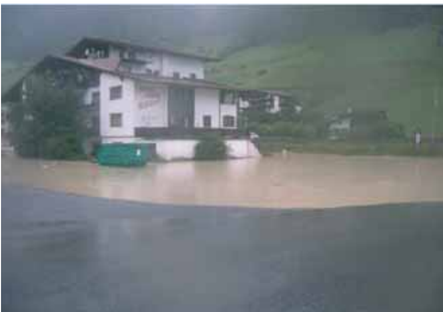
Abbildung 7-12: In einer Senke situiertes Objekt, das auch nach dem Rückgang des Hochwassers noch geflutet bleibt. (Walser, 2005).
