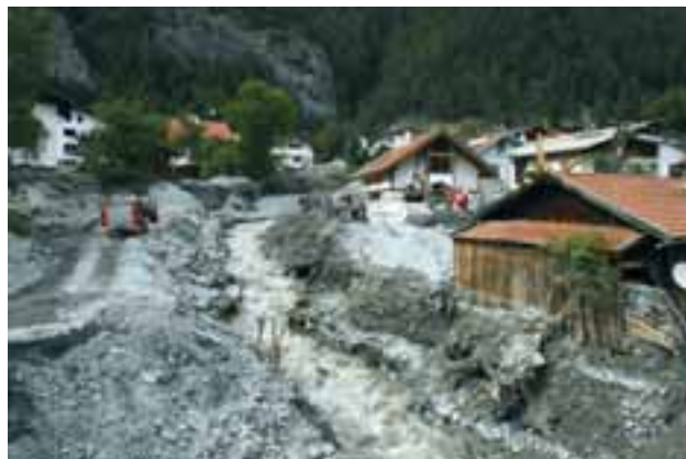
Abbildung 14-14: Mehrere Meter mächtige Überschotterung der Gemeinde Pfunds/Tirol durch das Hochwasserereignis im Stubenbach. (Quelle: IAN-BOKU).
