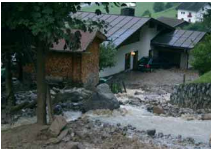
Abbildung 7-13: Zum Haus hin abfallendes Gelände bei gleichzeitig bergseitiger Anordnung von Zufahrt, Garage und Eingangstüre führen zu Wasser- und Feststoffeintritt in das Objekt. (Zauser, 2005).
