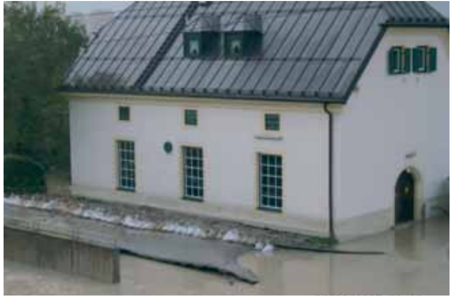
Abbildung 8-11: Feststellung der Wassertiefe nach dem Ereignis anhand von Spuren an einem Haus.
