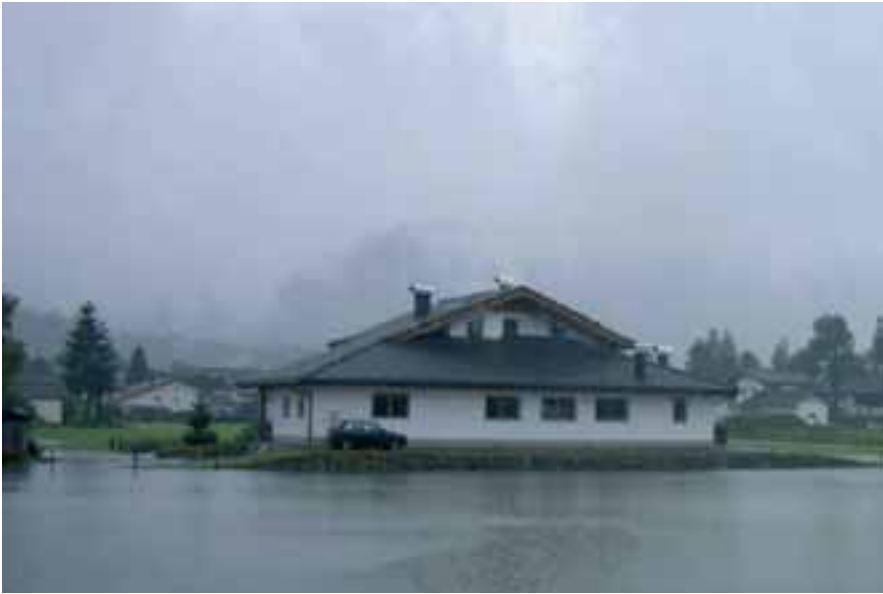
Abbildung 7-14: Gebäude, das durch Geländeanschüttung aus dem Hochwassereinflussbereich gehoben wurde. (die.wildbach, 2005).
