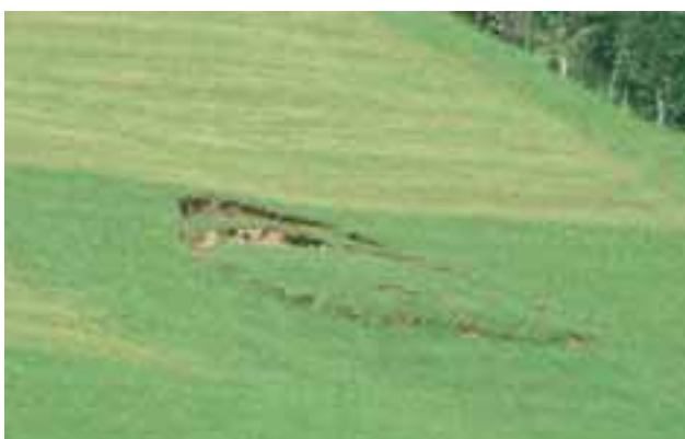
Abbildung 7-4: Stadium 2: Abrisskanten (kleine Geländestufen) und erste initiale Bewegung des Materials (initiale Rutschung), (© N. Tilch, Fotoarchiv der GBA).
