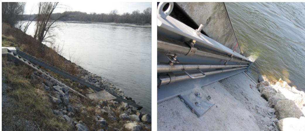
Abbildung 3: Schienenkonstruktion für Solitax ts-line Hainburg/Donau (Fotos: viadonau)
