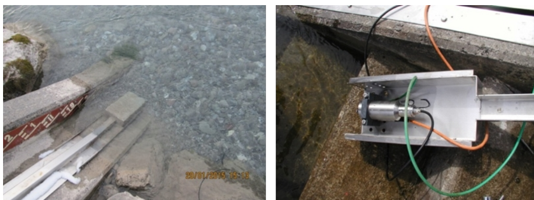
Abbildung 4: Schienenkonstruktion für Solitax ts-line in Tirol (Fotos: HD Tirol)
