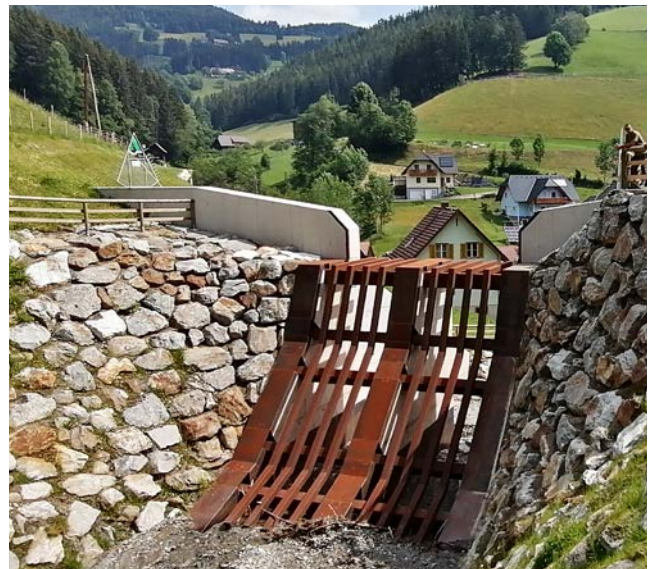
Filtersperre Haberlbach, Gde. Gasen
