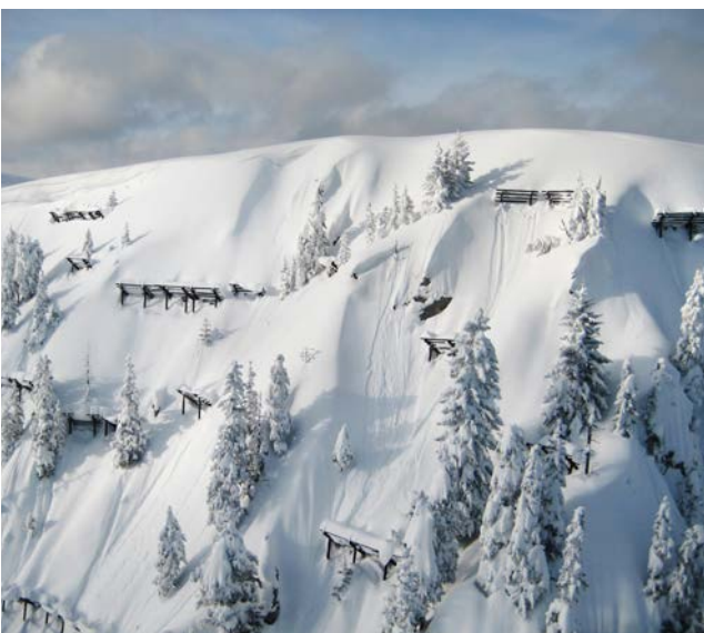
Stahlschneebrücken Wetterinlawinen, Stgde. Mariazell
