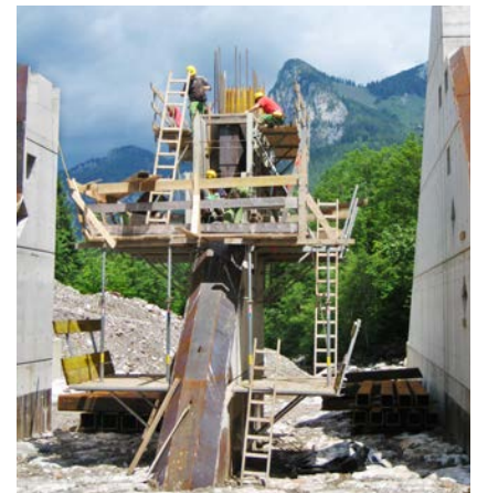
Errichtung Filtersperre Radmerbach, Gde. Radmer
