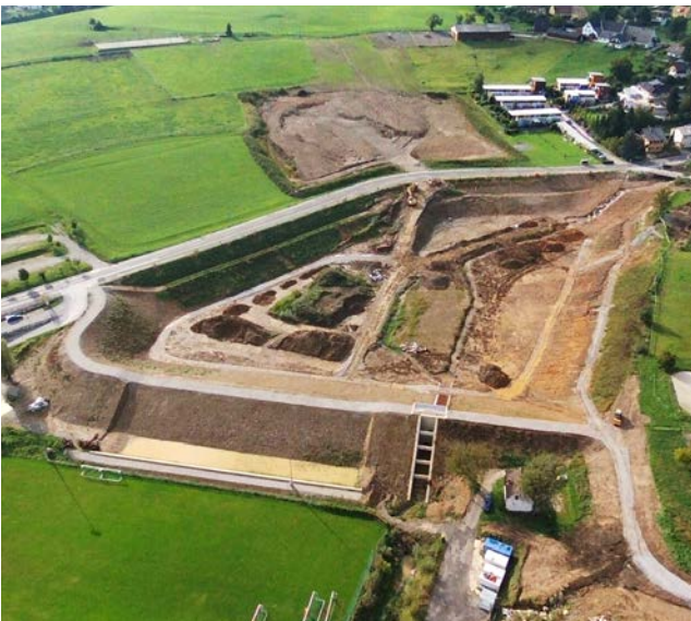
Errichtung Hochwasserrückhaltebecken Andritzbach, Gde. Stattegg
