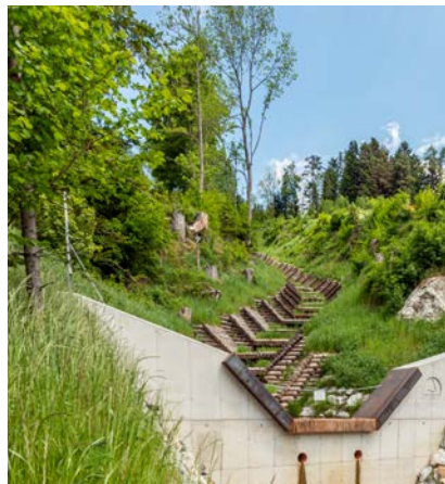
Gerinnkonsolidierung Hagenhofergraben, Gde. Gasen
