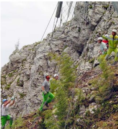
Setzen eines Schneenetzes Vordernberger Mauern, Mgd. Vordernberg
