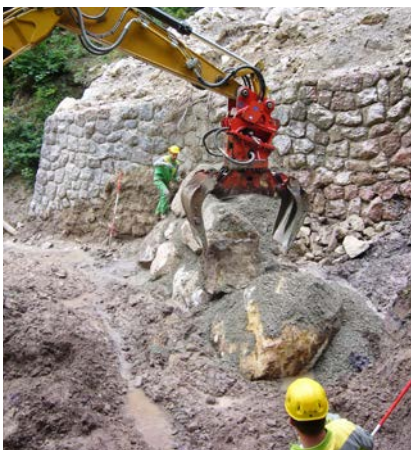
Errichtung Zyklopenmauer Schüsserbach, Gde. Radmer
