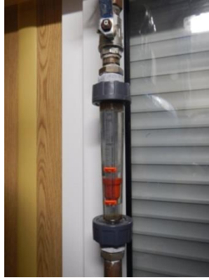
Abbildung 28: gereinigter Durchflussmesser
