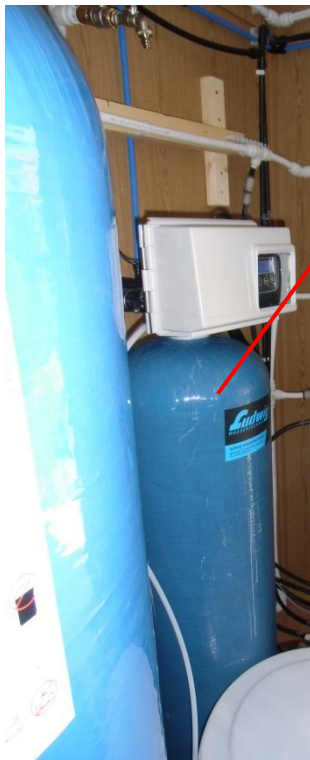
Abbildung 13: Zeolithfilter
