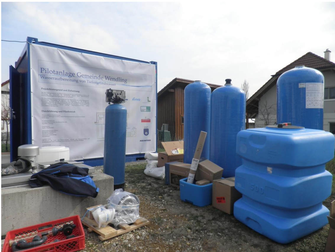
Abbildung 32: Lieferung der Pilotanlagekomponenten (16.04.2013)
