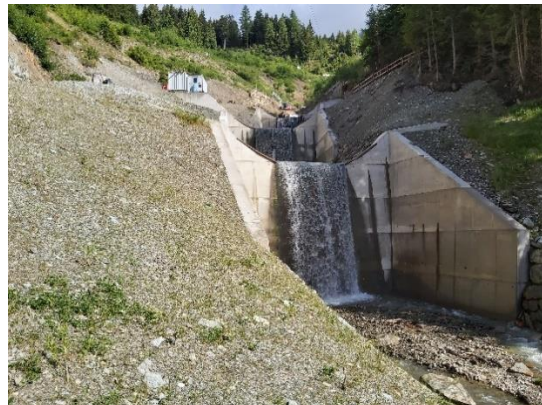
Abbildung 2: Sperrenstaffelung des Diasbaches
