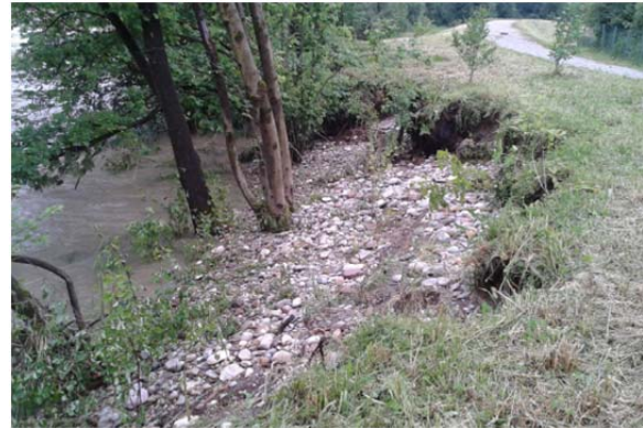
Abbildung 7-86: Links/Rechts: Beschädigter Hochwasserschutzdamm bei Fkm 9.90 (Quelle: GWB Gmunden)
