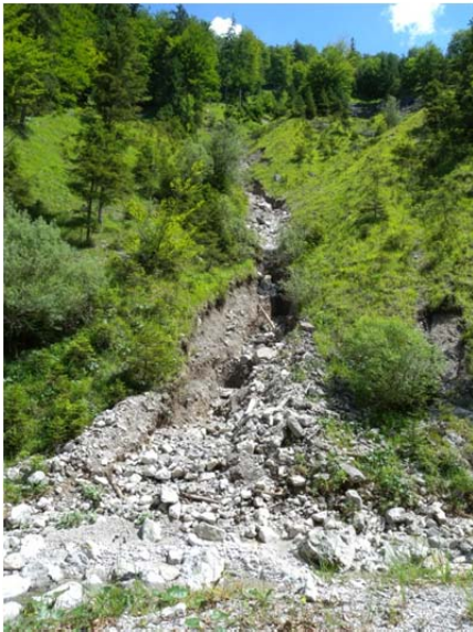
Abbildung 7-59: Links: Zubringer Steinbachgraben ~hm 30 – seitliche Einträge durch Grabenerosion; Rechts: Zubringer Steinbachgraben ~hm 29,0 – Zerstörung der Grabensicherung (Quelle: IAN-Report 155)
