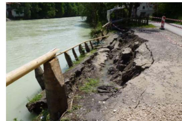
Abbildung 7-92: Links: Unterspülter Promenadenweg (Quelle: GWB Linz); Rechts: Setzungen an der Promenade (Quelle: GWB Linz)
