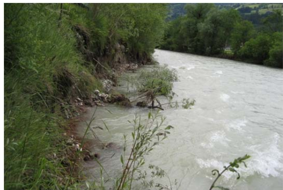
Abbildung 7-66: Links/Rechts: Linkes Ufer der Enns; HW- Schutzdamm wurde zerstört (Quelle: Amt der Steiermärkischen Landesregierung)
