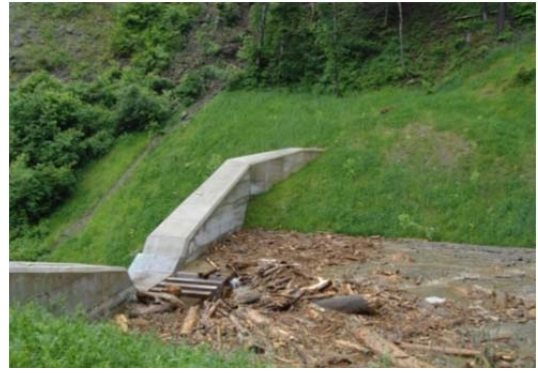
Abbildung 7-50: Links: Ablagerung von Feststoffen und Wildholz hinter dem Murbrecher (Quelle WLW GBL Pinzgau); Rechts: Ablagerung von Feststoffen und Wildholz hinter der Filtersperre (Quelle: WLW GBL Pinzgau).
