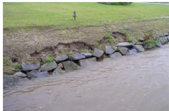
Abbildung 7-102: Links: Abgelagerter Flusssand in Schwertberg (Quelle: GWB Linz); Rechts: Hinterspülte Ufersicherung in Schwertberg (Quelle: GWB Linz)
