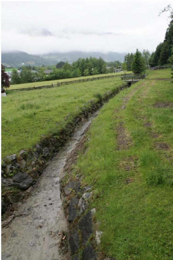
Abbildung 7-53: Künette unterhalb der Retentionssperre am Reitersbach (Quelle: IAN-Report 155)
