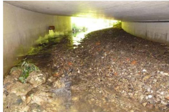
Abbildung 7-96: Links: Uferschaden bei der Autobahnbrücke PY29 (Quelle: GWB Linz); Rechts: Geschiebeablagerungen beim einem Durchlass des Moserbaches (Quelle: GWB Linz)
