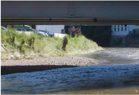
Abbildung 7-100: Links: Anlandungen von Flusssedimenten bei der Landesstraßenbrücke (Quelle: GWB Linz); Rechts: Erosionen des Oberbodens an der Aist (Quelle: GWB Linz)
