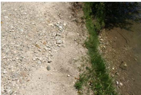
Abbildung 7-84: Links: Erosion am linken Traunufer (Quelle: Gewässerbezirk Linz); Rechts: Beschädigter Radweg entlang der Traun (Quelle: Gewässerbezirk Linz)
