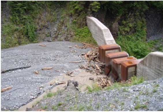
Abbildung 7-49: Links: Feststoffe und Wildholz hinter Murbrecher Aufhausnerbach (Quelle: IAN-Report 155); Rechts: Feststoffablagerung hinter Filtersperre Aufhausnerbach (Quelle: IAN-Report 155)
