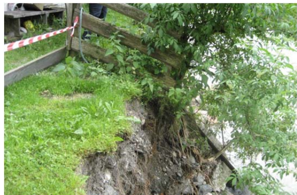
Abbildung 7-65: Links/Rechts: Zerstörter Steinverbau am linken Ennsufer (Quelle: Amt der Steiermärkischen Landesregierung)
