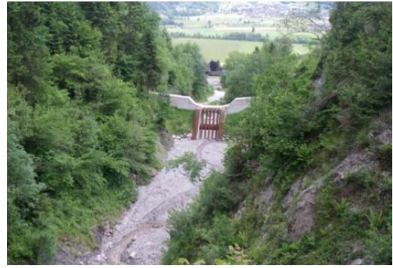
Abbildung 7-49: Links: Feststoffe und Wildholz hinter Murbrecher Aufhausnerbach (Quelle: IAN-Report 155); Rechts: Feststoffablagerung hinter Filtersperre Aufhausnerbach (Quelle: IAN-Report 155)
