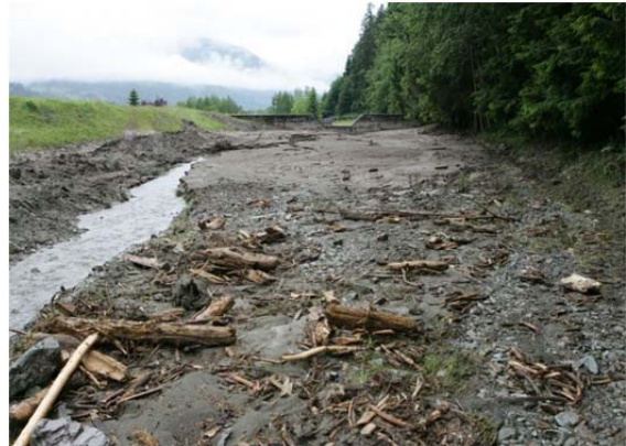
Abbildung 7-52: Links: Dosiersperre mit Geschiebeablagerung am Reitersbach; Rechts: Retentionssperre mit Sedimentablagerung und Wildholz am Reitersbach (Quelle: IAN-Report 155)
