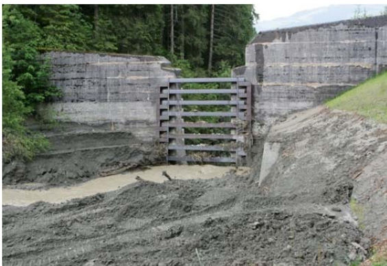
Abbildung 7-51: Links: Obere Filtersperre am Walcherbach (Quelle: IAN-Report 155); Rechts: Kronenoffene Sperre mit Ablagerungsraum im Unterlauf des Walcherbaches (Quelle: IAN-Report 155)
