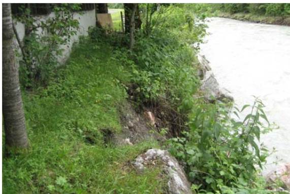
Abbildung 7-65: Links/Rechts: Zerstörter Steinverbau am linken Ennsufer (Quelle: Amt der Steiermärkischen Landesregierung)
