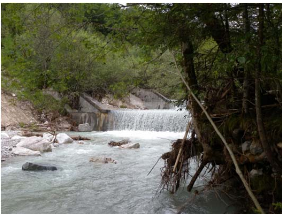
Abbildung 7-63: Links/Rechts: hm 37 bis hm 37,5 seitliche Hinterspülung der Sperren, dadurch teilweise Freilegung der Sperrenflügel (Quelle: IAN-Report 155)
