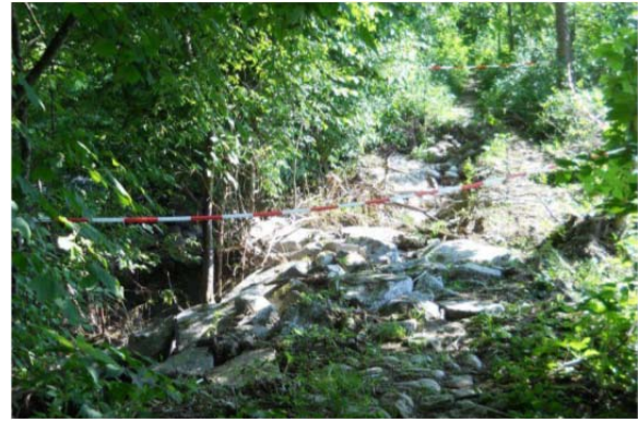
Abbildung 7-83: Links/Rechts: Erosierte Böschung samt Bewuchs (Quelle: Gewässerbezirk Linz)
