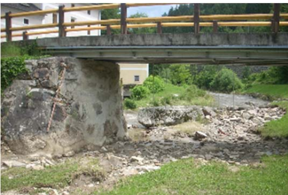
Abbildung 7-101: Links: Im Bereich der sogenannten Schiepermühle (Quelle: GWB Linz); Rechts: Massive Erosionen an der Feldaist bei Fkm 18.70 (Quelle: GWB Linz)
