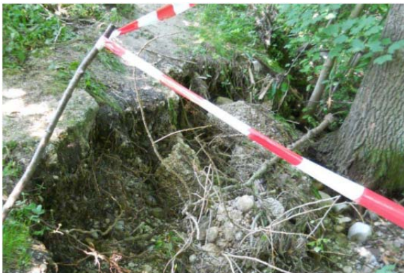
Abbildung 7-83: Links/Rechts: Erosierte Böschung samt Bewuchs (Quelle: Gewässerbezirk Linz)
