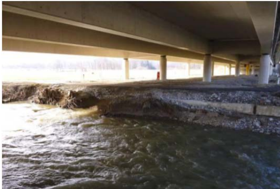
Abbildung 7-96: Links: Uferschaden bei der Autobahnbrücke PY29 (Quelle: GWB Linz); Rechts: Geschiebeablagerungen beim einem Durchlass des Moserbaches (Quelle: GWB Linz)
