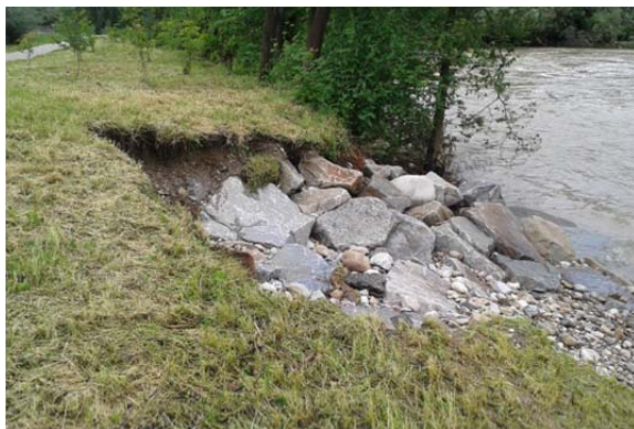
Abbildung 7-86: Links/Rechts: Beschädigter Hochwasserschutzdamm bei Fkm 9.90 (Quelle: GWB Gmunden)
