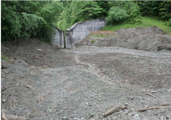
Abbildung 7-52: Links: Dosiersperre mit Geschiebeablagerung am Reitersbach; Rechts: Retentionssperre mit Sedimentablagerung und Wildholz am Reitersbach (Quelle: IAN-Report 155)
