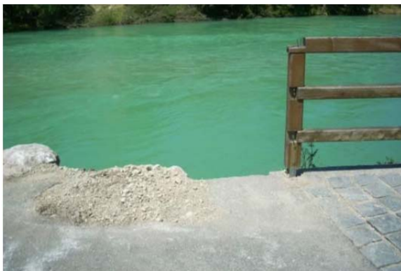
Abbildung 7-92: Links: Unterspülter Promenadenweg (Quelle: GWB Linz); Rechts: Setzungen an der Promenade (Quelle: GWB Linz)
