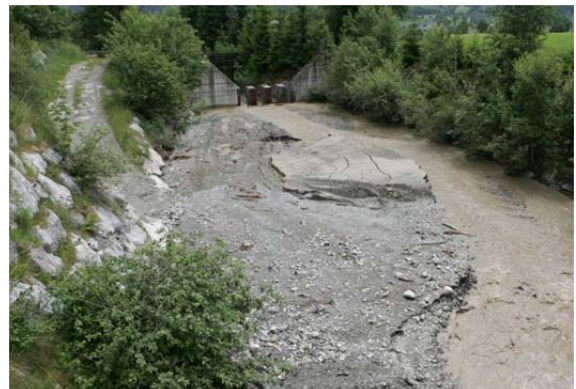
Abbildung 7-51: Links: Obere Filtersperre am Walcherbach (Quelle: IAN-Report 155); Rechts: Kronenoffene Sperre mit Ablagerungsraum im Unterlauf des Walcherbaches (Quelle: IAN-Report 155)
