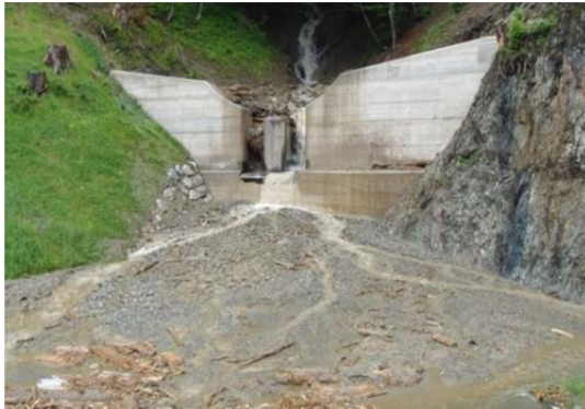
Abbildung 7-50: Links: Ablagerung von Feststoffen und Wildholz hinter dem Murbrecher (Quelle WLW GBL Pinzgau); Rechts: Ablagerung von Feststoffen und Wildholz hinter der Filtersperre (Quelle: WLW GBL Pinzgau).
