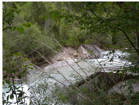
Abbildung 7-63: Links/Rechts: hm 37 bis hm 37,5 seitliche Hinterspülung der Sperren, dadurch teilweise Freilegung der Sperrenflügel (Quelle: IAN-Report 155)
