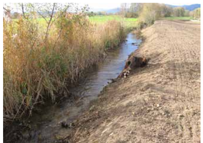
Uferseitig alternierende Räumung außerhalb des MW-Bettes. Ohne Trübung des Gewässers. Monotone Linienführung/ Strukturierung des Gewässers jedoch unverändert.
