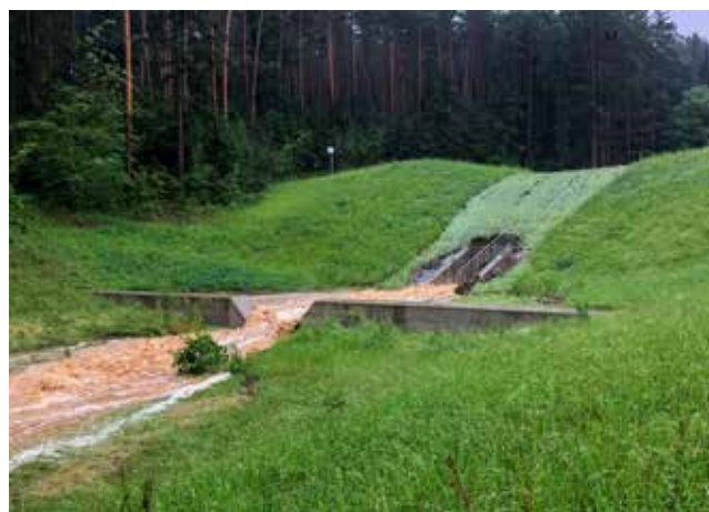
HRB Wartmannstetten, Ortsbach bei HW 2018. © Perzplan
