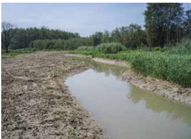
Einseitige Räumung im Gewässerbett und gleichzeitige Herstellung einer pendelnden Linienführung an der Schmida.
