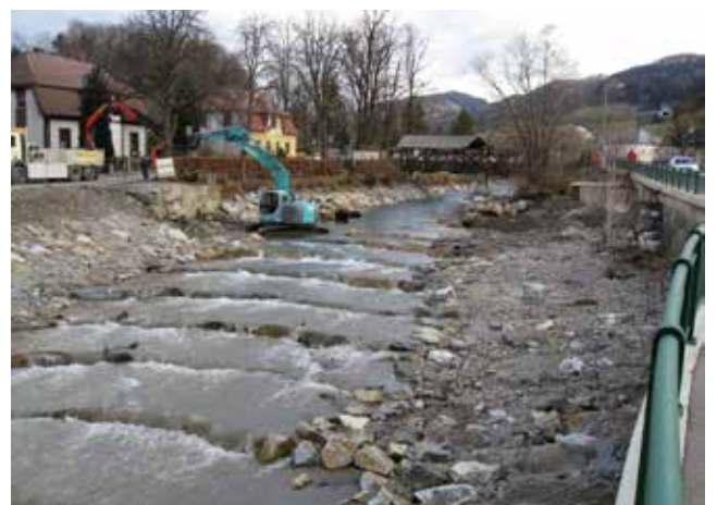
Zöchling-Wehr nach Umbau zu Rampe.
