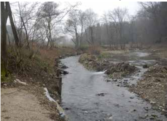
Neu errichtetes Ausschotterungsbecken nach dem ersten Hochwasser. Sattelbach.
