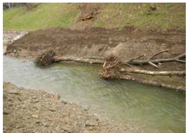
Mit Stahlseil (Erdanker) fixierte Raubäume.
