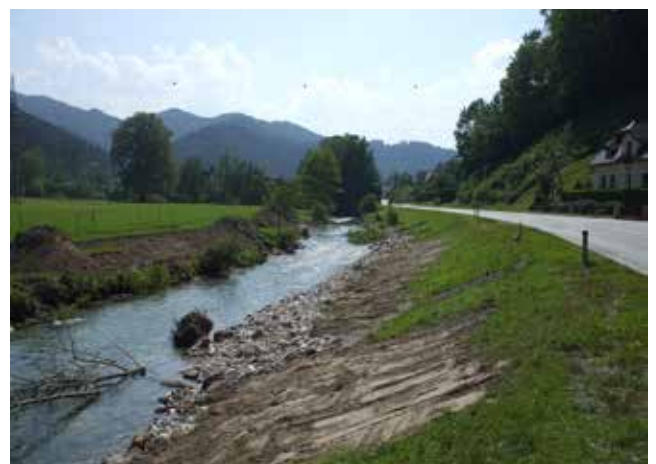
Zustand nach Aufweitung und Strukturierung, Ersatzpflanzung von Gehölzen an der Böschungsoberkante. Entfernte Gehölze wurden als Strukturierungselement eingebaut.
