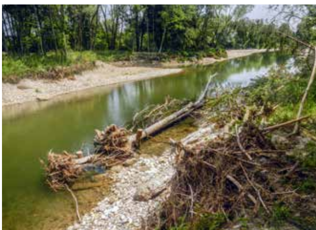
Mit Piloten befestigter Raubaum an der Ybbs.
