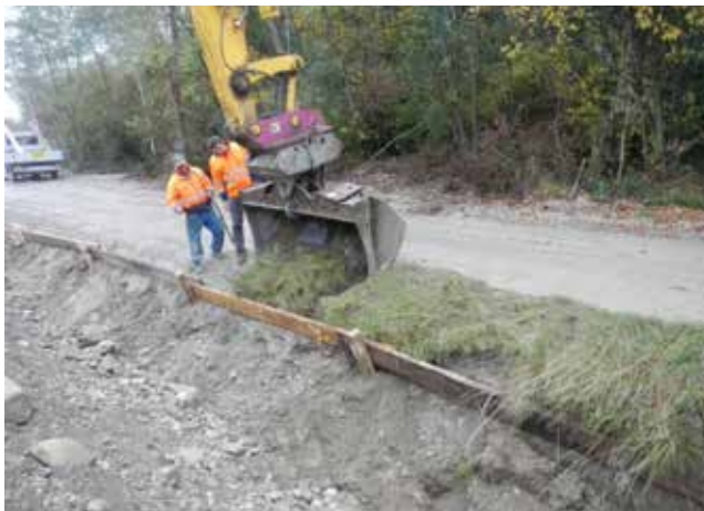
Auftrag von mit dem Böschungslöffel abgetragenen Soden an der Böschungsoberkante.
