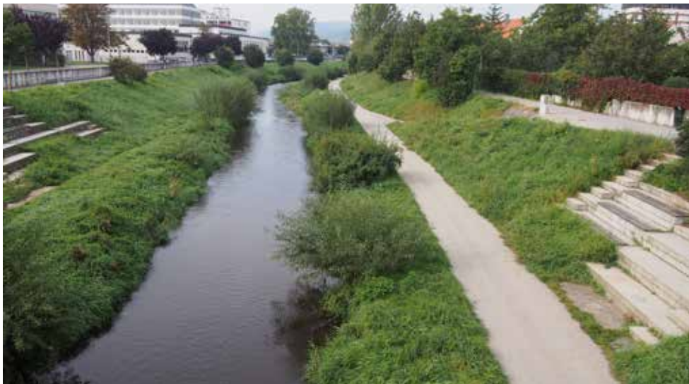
Situationstyp 2: Gemähte Böschung am Ufer; vereinzelt Bepflanzung mit Sträuchern oder hochstäm- migen Gehölzen (geringe Blockierung des Abflusses) im Abflussprofil. Krems.
