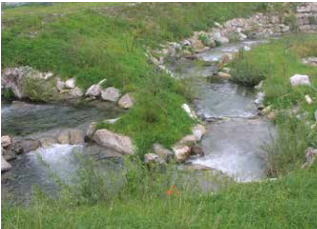
Naturnaher Beckenpass an der Traisen.
