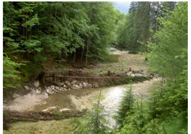
Sicherung stark beanspruchter Böschungsbereiche durch den Einbau von Raubäulen.
