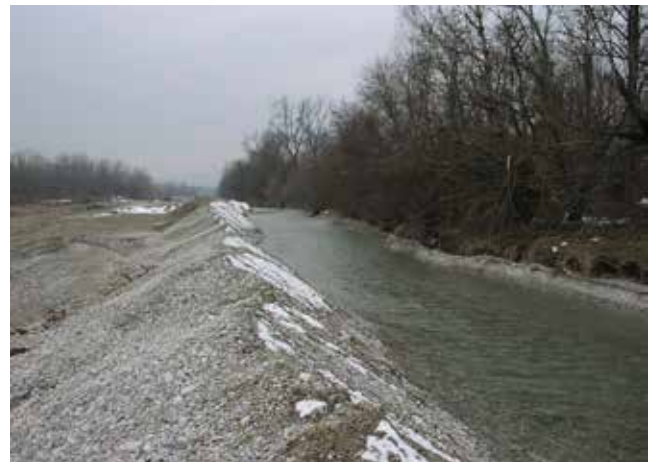
Baggerung an der Leitha. Belassen eines Uferwalls.
