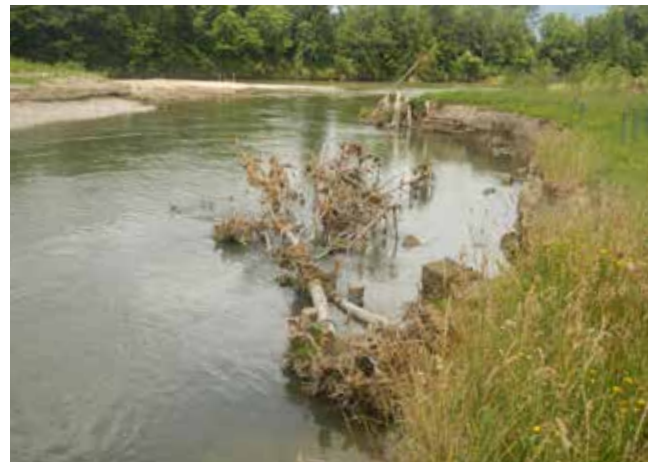
Mit Piloten befestigte Totholzstruktur zur Ufersicherung. Ybbs bei Hausmening.
