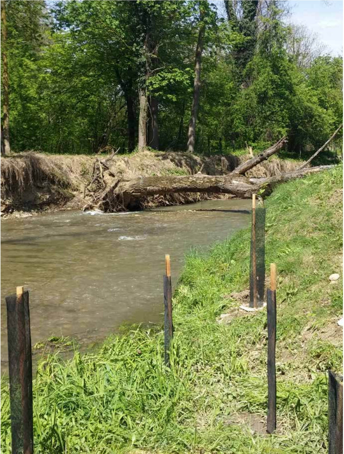
Bepflanzte Böschungen am Laabenbach in Neulengbach.
