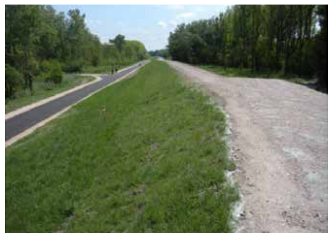
Verpflanzte Rasensoden nach dem Anwachsen. Lücken zwischen den Soden können angesät werden. © land.und.wasser
