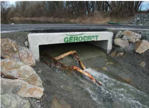
Durchlass unter Radweg an der Traisen.
