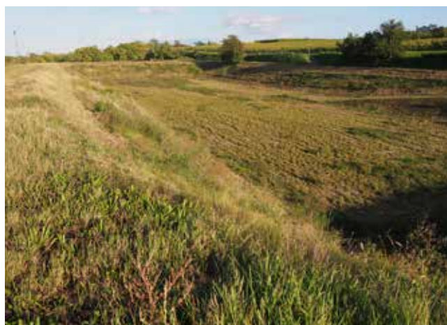
Gemähte Dammböschungen an einem Rückhaltebecken.
