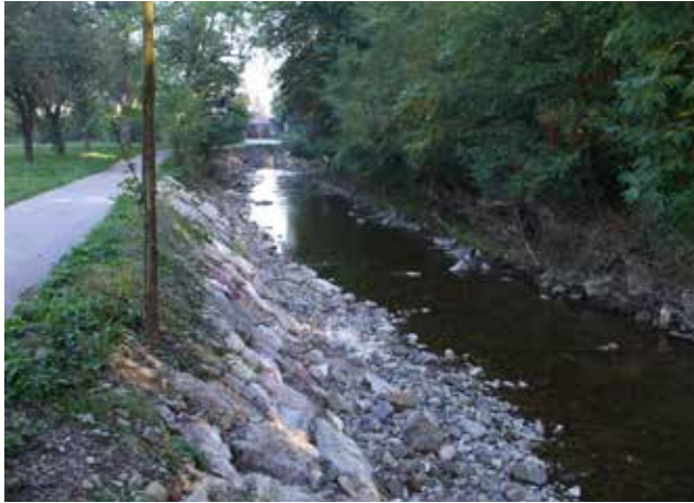
Durch Blockwurf sanierter Uferbereich an der Großen Tulln.
