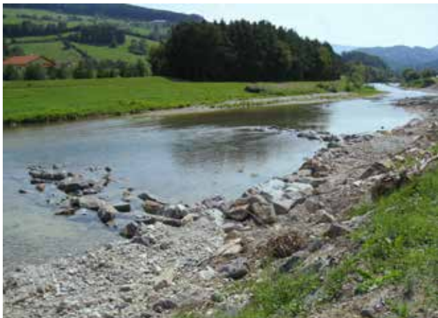
Ortsstrecken: Buhnen an der Traisen bei Wasenmühle.
