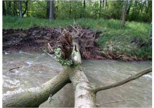
Sturzbaum mit Uferanriss. Wurzelstöcke sollten nach Möglichkeit als Strukturierungselement belassen werden.
