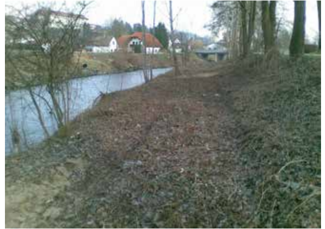
Das Freischneiden der Böschungsoberkante ist nicht zwingend erforderlich, da Gehölze nicht den Abfluss beeinträchtigen. Lavant. © Umweltbüro
