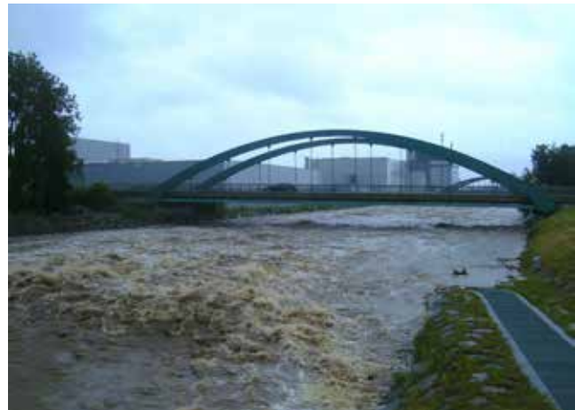
Hochwasserschutz Schwertberg. © BMLRT
