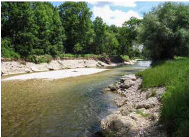
Tolerierter Uferanriss an der Ybbs, Freilandstrecke.
