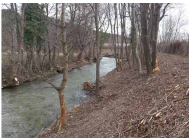
Gehölzbestand nach Entfernung der einhängenden Stammteile an der Piesting bei Wöllersdorf. © land.und.wasser
