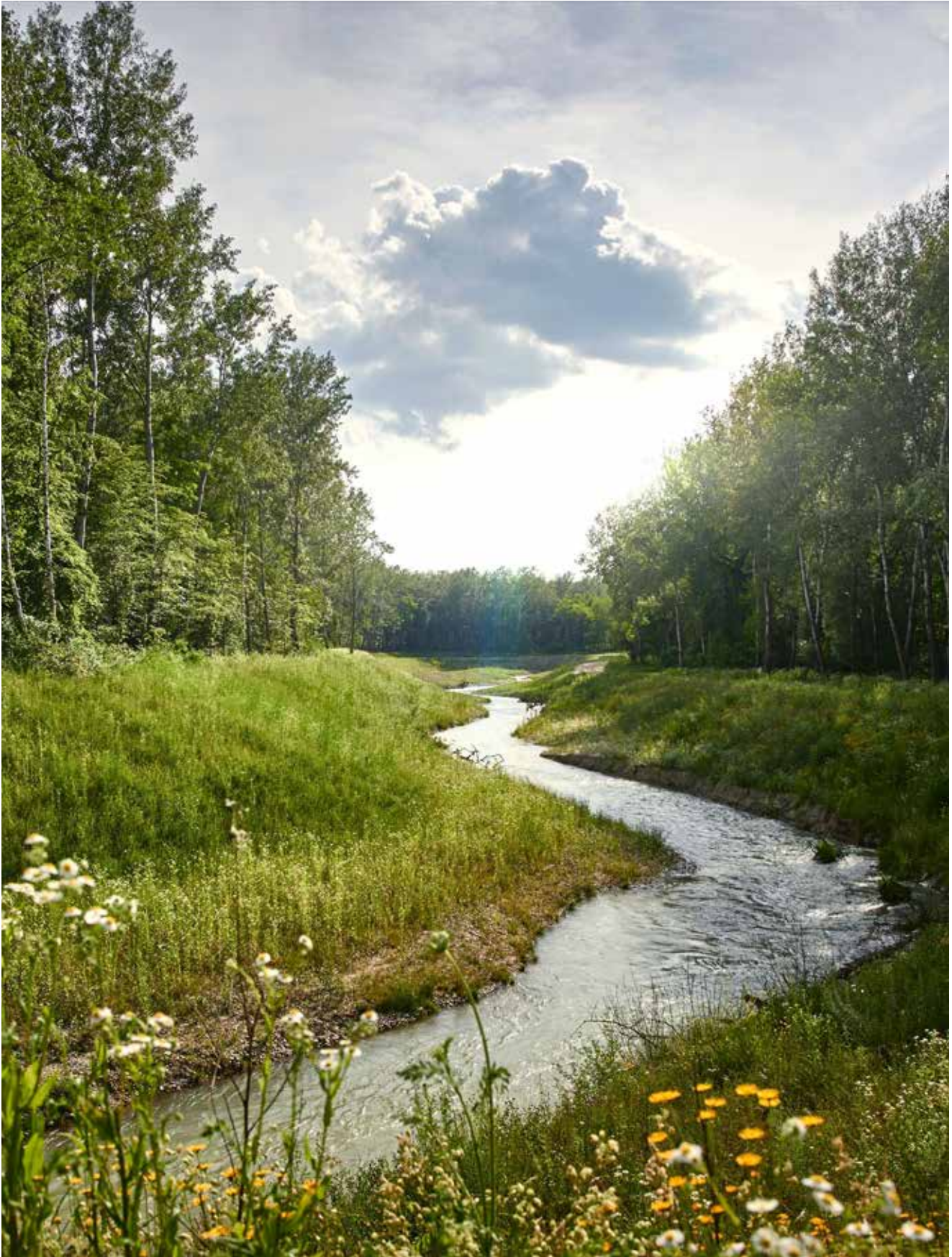
Begrünte Uferböschungen an der FAH Greifenstein. © BMLRT
