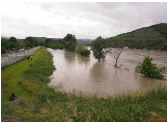
Längsdamm an der Donau bei Mautern, Hochwasser 2013.
