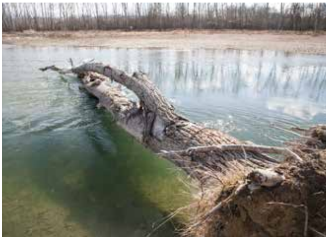
Umgestürzter, mit Stahlseil in der Uferböschung fixierter Stamm.
