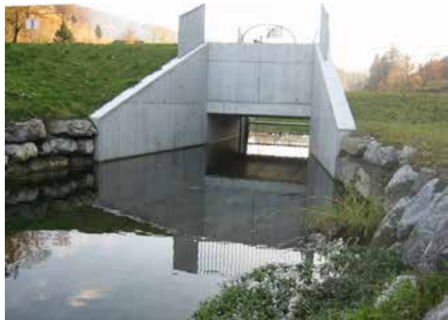
Durchlass eines Rückhaltebeckens am Ehbach.
