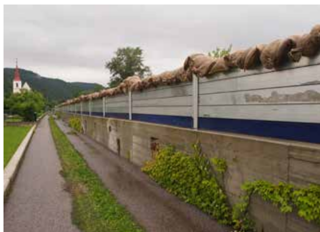
Luftseitiger Betreuungsweg in Mauternbach. Aufgesetzte Mobilelemente, Hochwasser Juni 2013.
