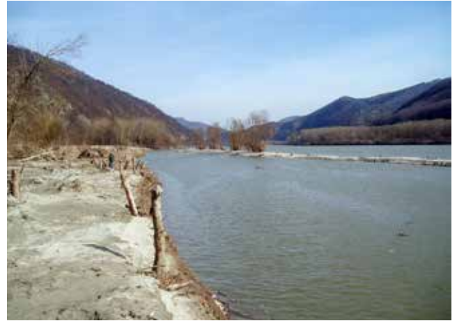
Wurzelstöcke an der Donau im Nebenarm Grimling, unmittelbar nach Einbau.
