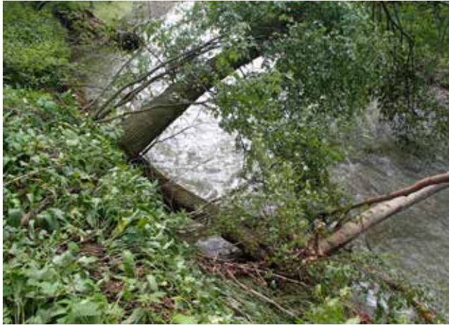
Sturzgefährdete Gehölze (z.B. wurfgefährdete Altbäume, unterspülte Bäume) sind gegebenenfalls zu fällen. Alternativ kann eine Sicherung mit Erdankern erfolgen.
