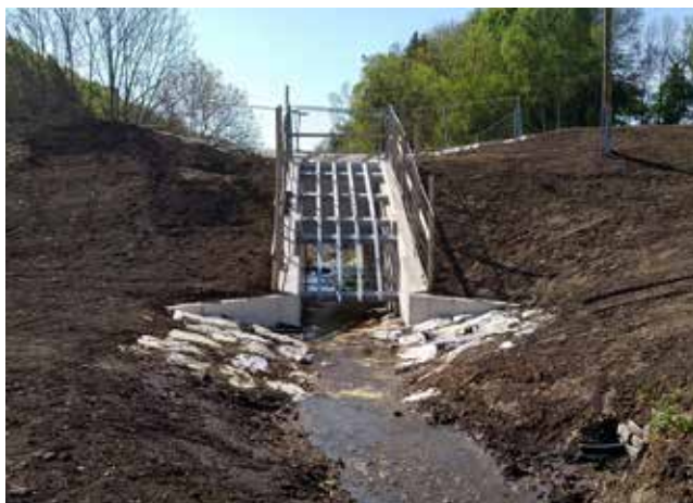
Einlaufbauwerk mit Rechenanlage am Mödlingbach.
