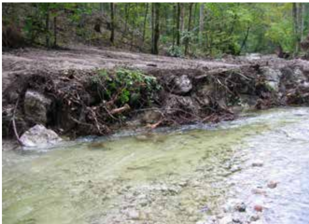
Ufersicherung durch Kombination von Steinwurf, Wurzelstöcken und Gehölzpflanzung am Toplitzbach.
