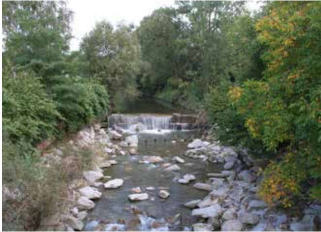
Wehr Leitsberg am Laabenbach vor Umbau.
