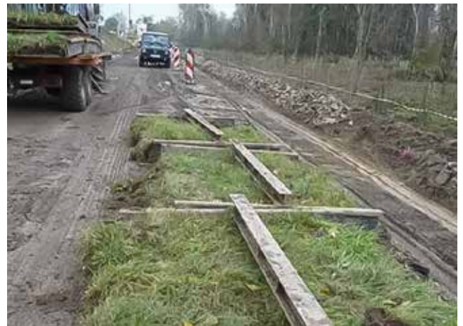
Rasensoden auf Versatzblech. © land.und.wasser
