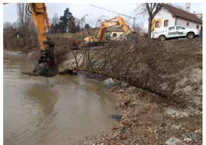
Einbau eines Raubaumes in Judenau an der Großen Tulln.
