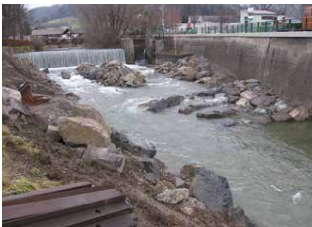
Zöchling-Wehr (Gölsen) vor Umbau.
