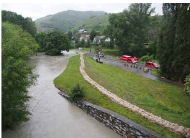
Mit Sandsäcken aufgehöhter Damm an der B3 bei Stein an der Donau, Hochwasser 2013.
