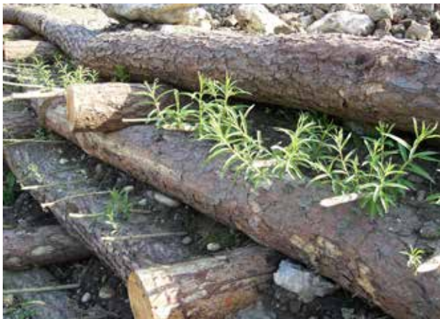
In Kraierwand eingelegte Stechhölzer.
