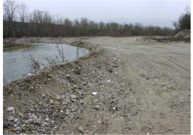
Belassen eines Sedimentstreifens entlang der NW-Anschlaglinie, um Trübungen des Gewässers zu vermeiden.
