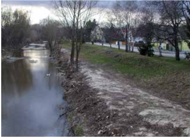
Ortsbereich: Im Rahmen der Gewässerpflege zur Abflusssicherung freigeschnittenes Doppeltrapezprofil.
