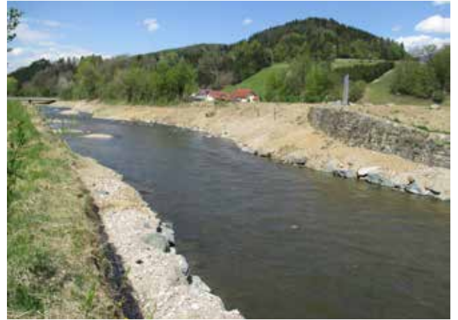
Sinuidalschwelle Altach nach Umbau. © Umweltbüro
