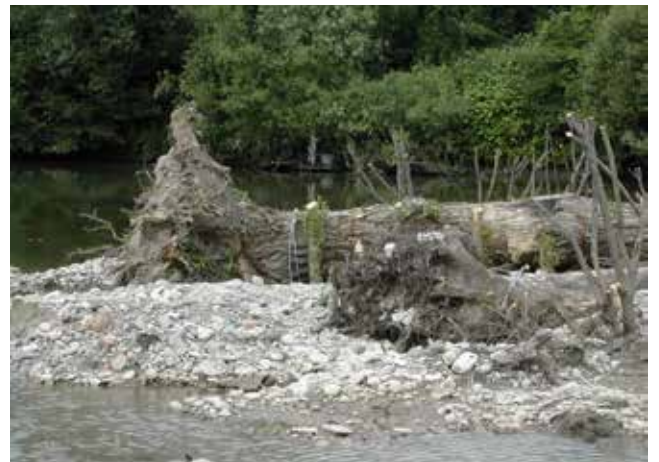
Mit Erdanker und Steckhölzern befestigte Holzstruktur.
