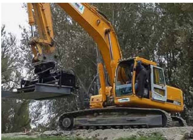
Versetzen der Rasensoden mit Versatzblech. © land.und.wasser
