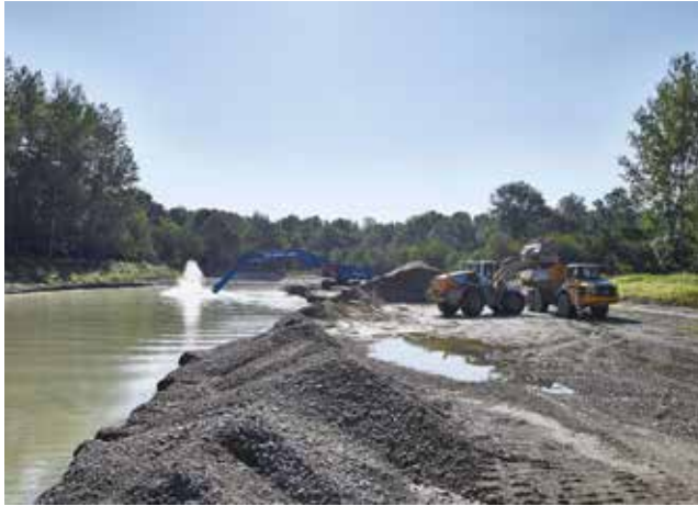
Baggerung im Flussbett. © BMLRT
