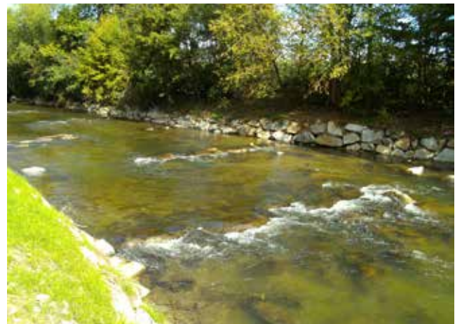
Nach Umbau in fischpassierbare Rampe, © A14, Amt der Stmk. LReg
