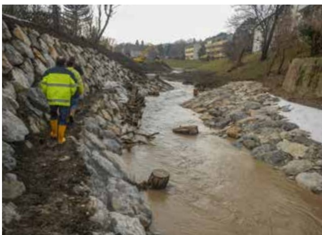
Blockwurf mit verankerten Totholzstrukturen in beengten Raumverhältnissen (Liesing/Wien, Brückenquerung).
