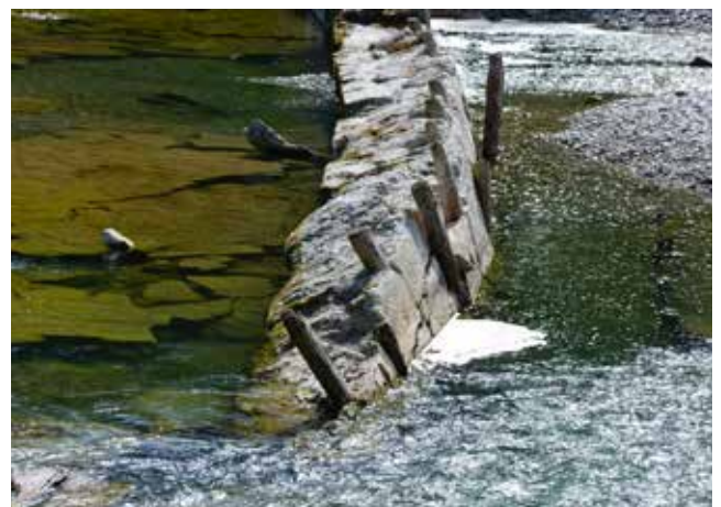
Beschädigte Sohlstufe.
