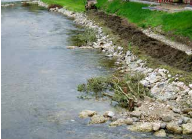
Ortsstrecken: Herstellung einer verzahnten Uferlinie mit Kurzbuhnen und Raubäumen.
