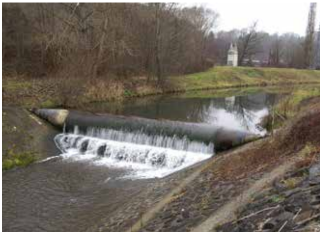
Wehr am Gamlitzbach vor Umbau.
