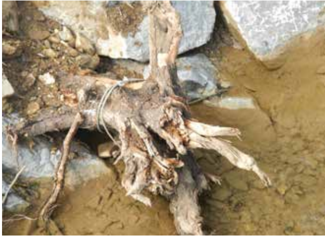
Mit Stahlseil (Erdanker) befestigter Wurzelstock.
