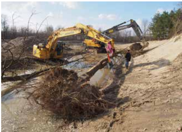
Befestigung von Raubäumen mittels Erdanker.
