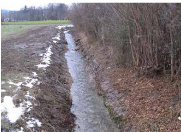
Negativbeispiel: Beidseitige Räumung ohne Strukturverbesserung.
