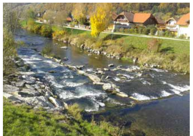
Sohlrampe an der Gölsen (Rainfeld). Herstellung Passierbarkeit durch Teilrampe.
