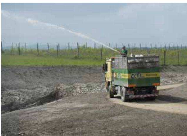
Ausbringung von Hydrosaat mit fertigem Mischgut an den neu angelegten Böschungen der FAH Greifenstein.
