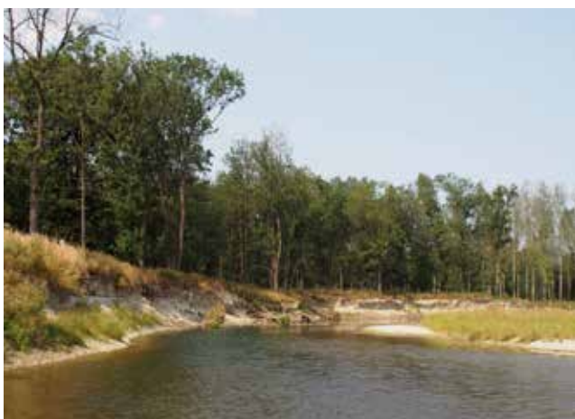
Dem Grundbesitzer entschädigter Uferstreifen im Pralluferbereich der Traisen. Ufererosion wird toleriert. LIFE-Traisen.
