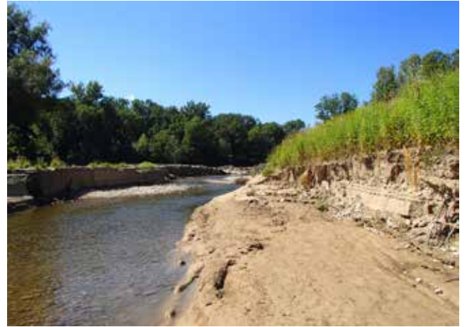
Uferanriss in einer Naturstrecke an der Ybbs.
