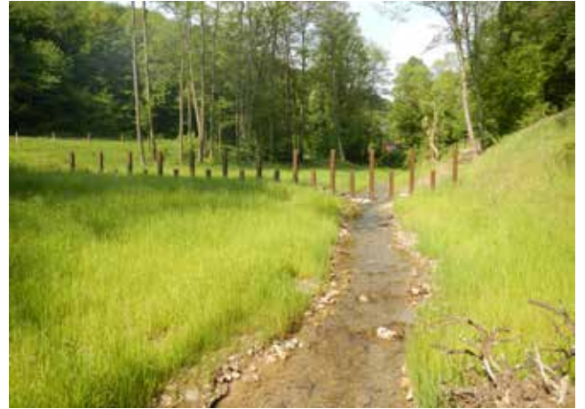
Mobilisiertes Wildholz stellt eine große Verkläuerungsgefahr für Brücken und Wehre dar. Wildholzrechen am Pöllerbach.
