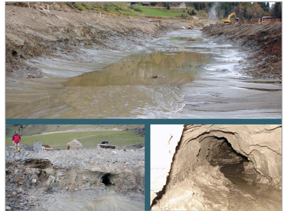
Abb. 27: hydraulischer Grundbruch infolge innerer Erosion (Jacobs) [13]
