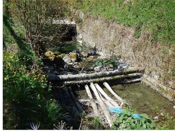
Abbildung 1 und 2: Bild links: Hochwasserereignis vom Jahr 1959 (© Feuerwehr Trattenbach); Bild rechts: Zahlreiche alte Schutzbauwerke weisen einen schlechten Zustand auf und sind zu sanieren.
