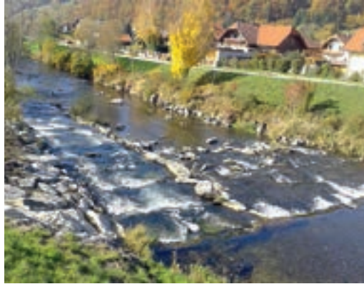
Foto 4.14: Teilrampe in Rainfeld an der Gölsen/ NÖ. (© ezb)
