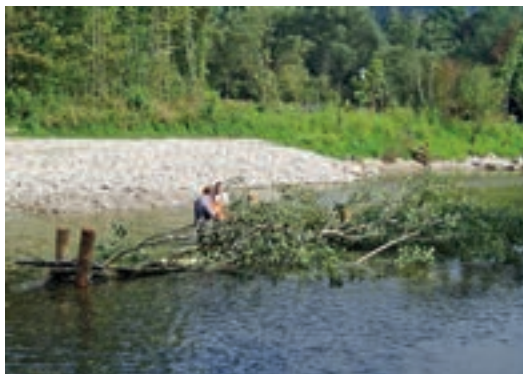
Fotos 5.38–5.39: Einbau von Raubäumen (links: Verankerung an Holzpiloten, rechts: Befestigung mit Erdankern). (© ezb)
