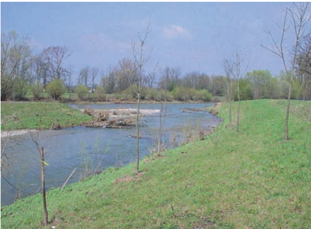
Foto 11.1: Bepflanzte Uferböschungen am Umgehungsarm Stufe 40 (Baumschulware, Steckhölzer an der Uferlinie), Traisen/NÖ. (© ezb)
