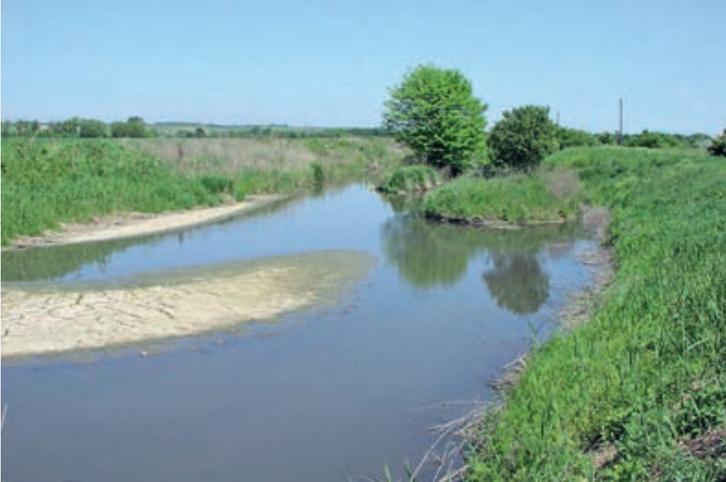
Foto 5.48: Überbreites MW-Bett durch sohlgleiche Aufweitung eines gewunden-mäandrierenden Gewässers. Aufgrund der geringen Gewässerdynamik entsteht ein kaum durchflossener, ökologisch unattraktiver Rückstaubereich, der sukzessive verlandet. (© ezb)
