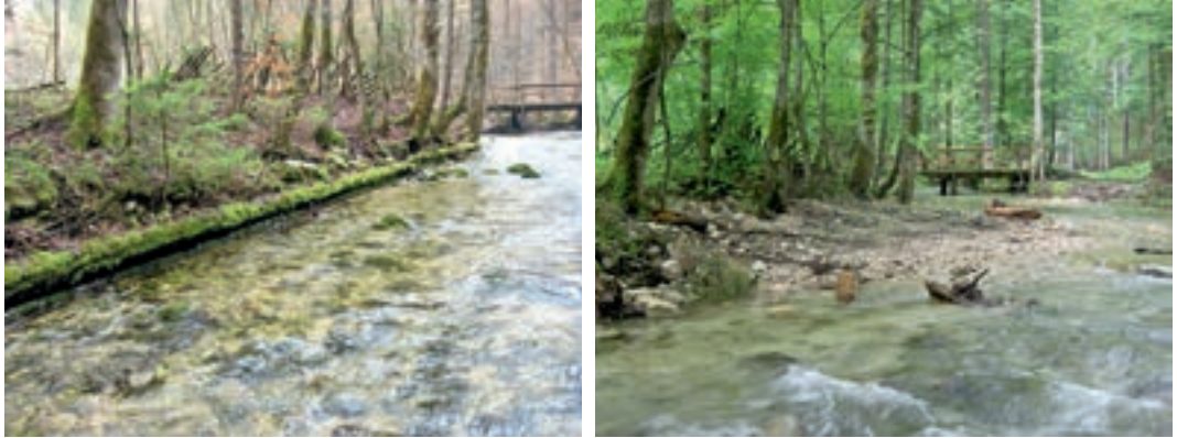
Fotos 5.5–5.6: Durch Holzstammverbau gesichertes Ufer (vorher) und naturnahes, flaches Ufer nach Entfernen der Ufersicherung (nachher) am Toplitzbach/Stmk. (© ezb, TB Zauner)
