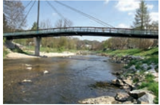
Foto 6.10: Rau verlegter Blockwurf mit guter Uferverzahnung. (© ezb, TB Zauner)
