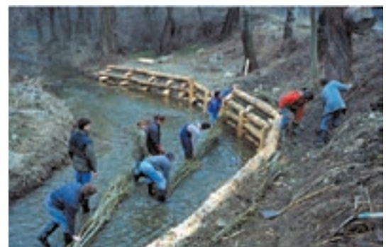
Fotos 6.13–6.14: Bau einer Uferpfahlwand an einem Prallufer, Liesing/NÖ. (© Florineth)
