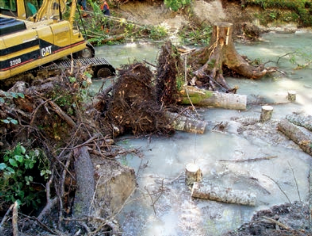
Foto 5.29: Einbau einer Wurzelstockbuhne. (© ezb)
