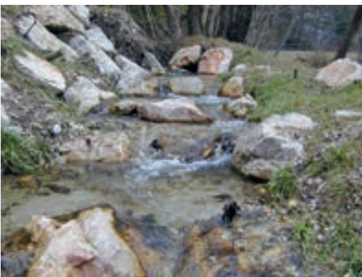
Foto 4.30: Links – die Ausbildung unterschiedlicher Fließgeschwindigkeiten und Tiefen macht die Schwelle auch für schwimm- und sprungschwache Fischarten passierbar. Ein durchströmtes Lückenraumsystem innerhalb der Schwelle ermöglicht die Wanderung der Bodenfauna. (© ezb)
