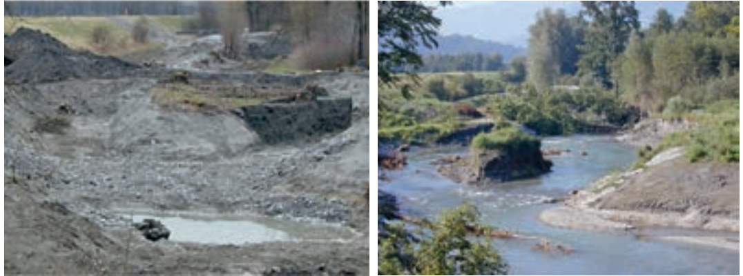
Fotos 5.54–5.55: Mündungsstrecke des Liechtensteiner Binnenkanals, Aufzweigung im Bau und nach erstem Hochwasser. Im Bereich der Insel wurde beim Bau das bestehende Geländeniveau belassen, um die Massenbewegung gering zu halten. (© ezb)
