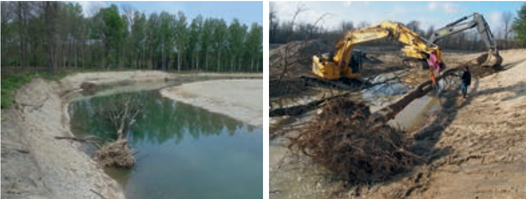
Fotos 5.19–5.20: Links: Raubbaumfixierung mit zwei Erdankern (Traisen/NÖ), rechts: Einbau. (© ezb)
