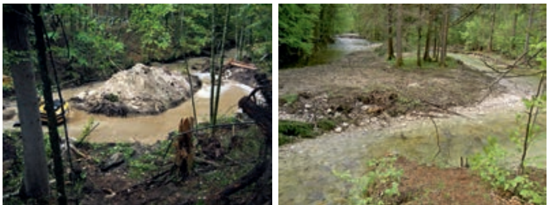
Fotos 5.44–5.45: Herstellung einer lokalen Laufverschwenkung beim gestrecktem Flusstyp (Toplitzbach/Stmk., links: Bauzustand, rechts nach Fertigstellung und Feinmodellierung nach Hochwasser. (© ezb, TB Zauner)
