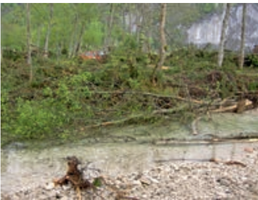
Foto 5.13: Raubbaum zur Ufersicherung am Topplitzbach/Stmk. (© ezb, TB Zauner)
