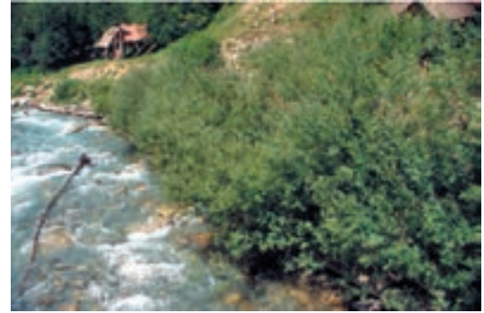
Foto 6.28–6.29: Doppelte Uferkrienerwand kurz nach Fertigstellung, links – nach 3 Jahren; rechts – Rambach/Schweiz. (© Florineth)
