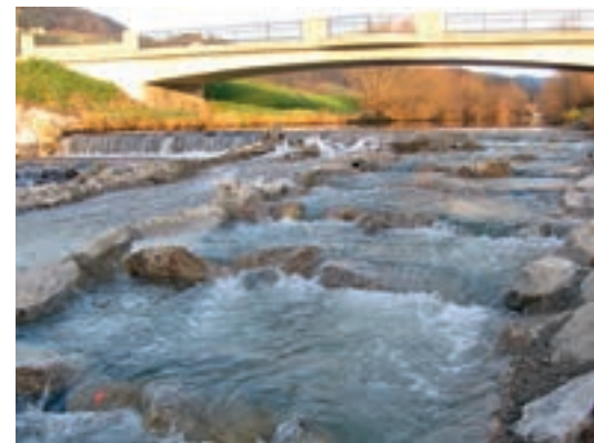
Foto 4.12: Teilrampe in Rainfeld an der Gölsen/NÖ. (© ezb)
