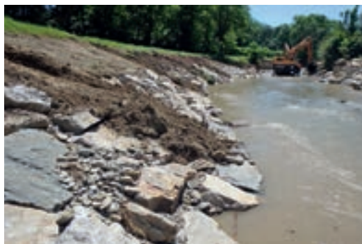
Foto 6.8: Flach ausgeführte Steinschichtung am Laabenbach, Neulengbach/NÖ. (© ezb)
