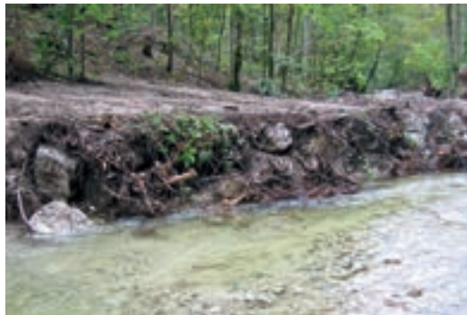
Foto 6.6: Als raue Steinschichtung ausgeführte Prallhangsicherung mit Steckhölzern. (© ezb)
