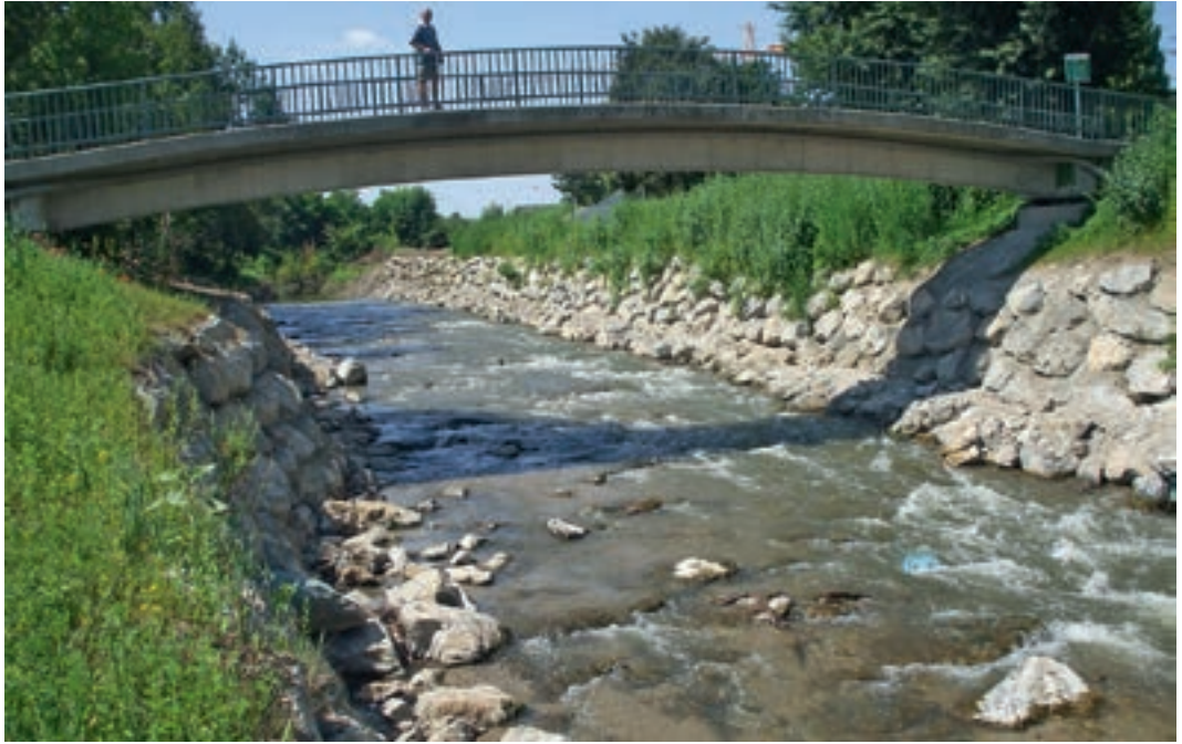
Foto 4.9: Asymmetrische Rampe an der Mündung der Liesing in die Schwechat. Deutlich erkennbar ist rechts die Tieferinne (hohe Geschwindigkeit – für schwimmstarke Fischarten) sowie linksseitig der flach überströmte Wanderkorridor für schwimmschwache Fischarten. (© ezb)
