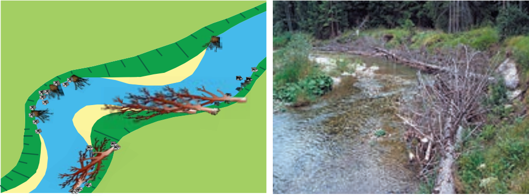
Abb. 6.11: Raubaum-Ufersicherung. (© ezb)
