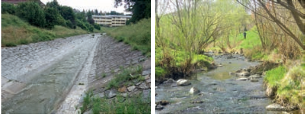
Fotos 5.1–5.2: Gestaltung eines naturnahen, gestreckten Flusslaufes nach Entfernen der Ufer- und Sohlpflasterung – links: gepflasterter Abschnitt, rechts nach Revitalisierung, Reiche Liesing/Wien. (© ezb)
