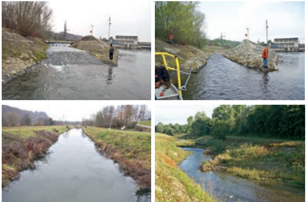
Fotos 4.1–4.4: Entfernung eines Querbauwerkes an der Mündung des Gamlitzbaches in die Mur. Das vorhandene Schlauchwehr wurde durch eine fischpassierbare Rampe ersetzt, der ehemalige Rückstauraum revitalisiert. (© ezb, TB Zauner)
