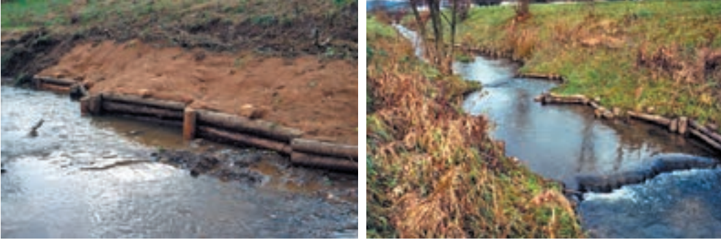
Foto 6.18–6.19: Links – Rangenverbau als Uferschutz kurz nach Fertigstellung, rechts – nach 6 Monaten, Doblach/Steiermark. (© Florineth)
