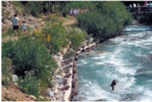
Foto 6.28–6.29: Doppelte Uferkrienerwand kurz nach Fertigstellung, links – nach 3 Jahren; rechts – Rambach/Schweiz. (© Florineth)
