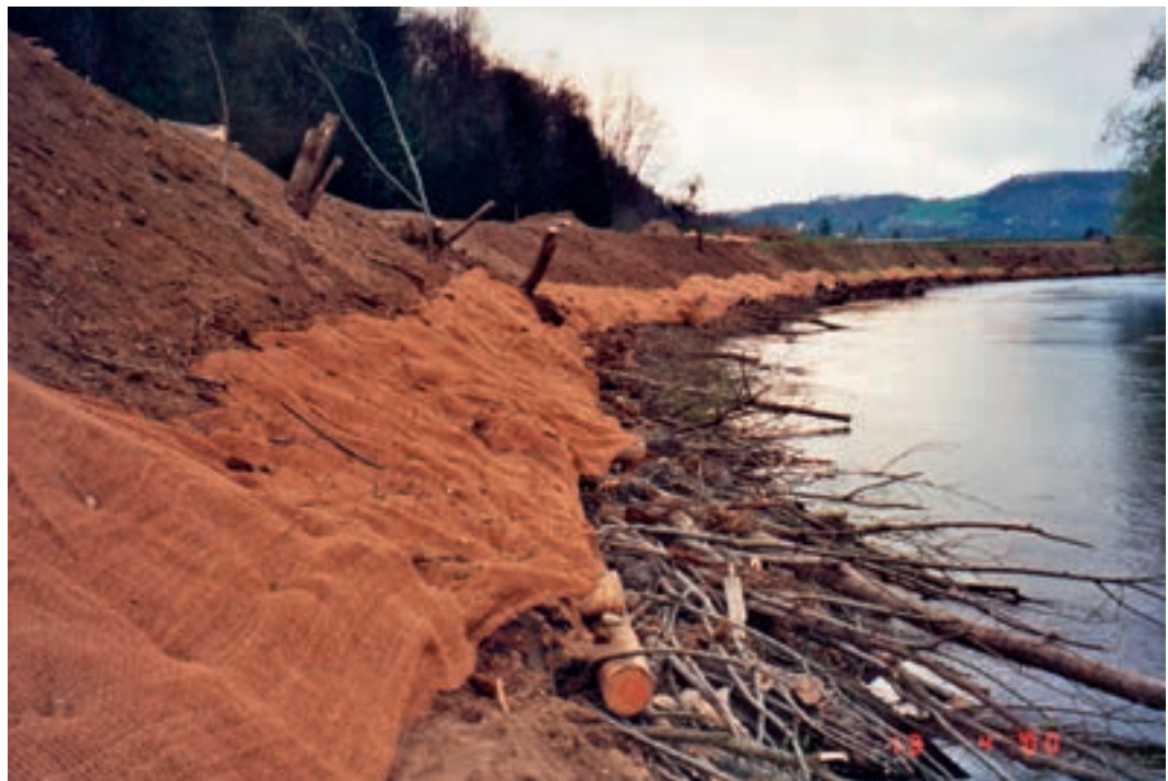
Foto 6.1: Sulm/Stmk.: Großflächig an den Uferböschungen ausgebrachtes verrottbares Jutenetz zur Sicherung der Böschung gegen Erosion. Am Böschungsfuß wurde zur Strukturierung des Uferbereiches zusätzlich eine raue Spreitlage eingebracht. (© Baubezirksleitung Leibnitz).
