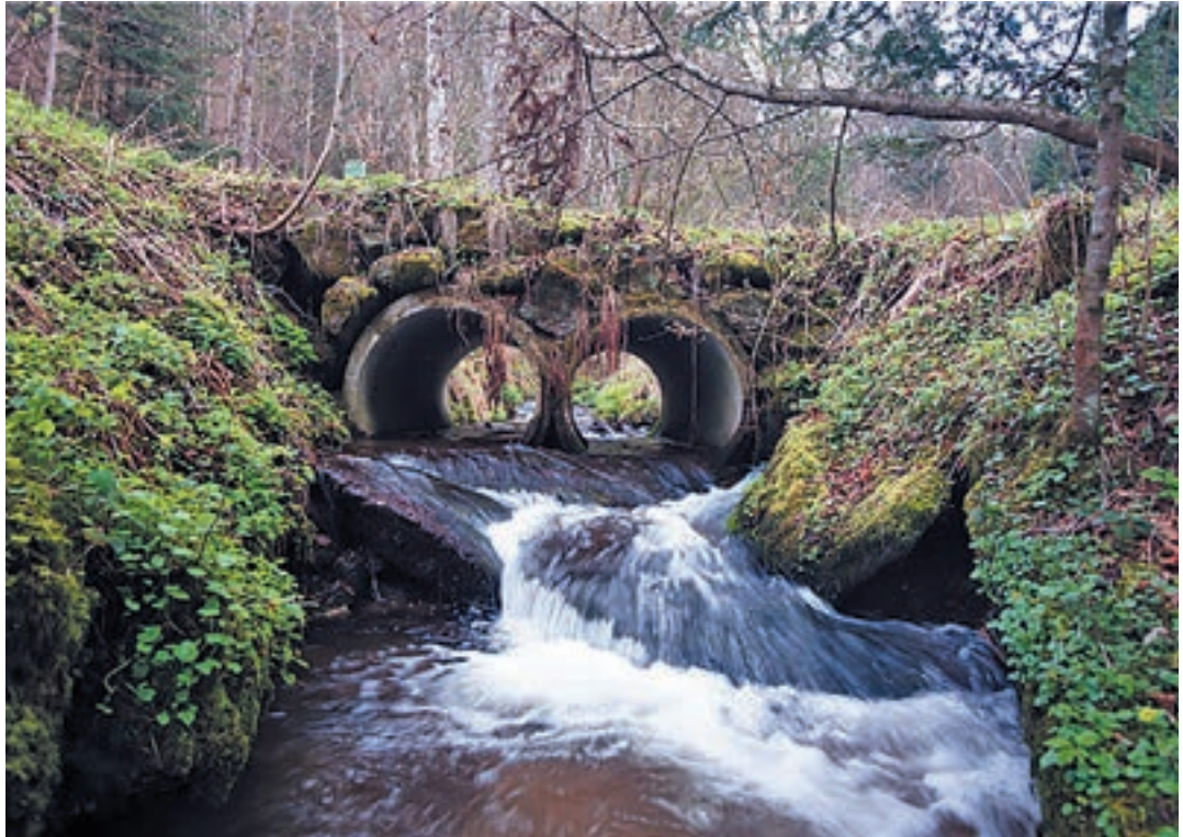
Foto 4.51: Durchlass mit Absturzkolk. (© ezb, TB Zauner)
