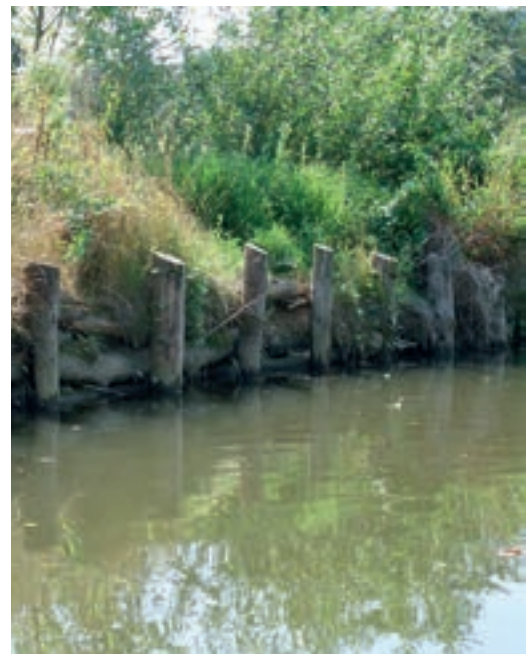
Foto 6.17: Aus Baumstämmen und starken Ästen aufgebauter Rangerverbau bei Schönberg am Kamp/NÖ. (© ezb)
