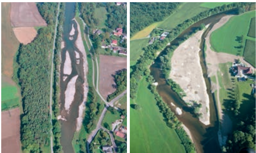
Fotos 5.61–5.62: links: Aufweitung mit Strömungsteilern zur rascheren Initiierung von Seitenarmen und Kiesinseln, Traisen/NÖ (© ezb), rechts: Beschleunigung einer sich selbst entwickelnden Aufweitung durch Anlage eines Initialgrabens, Ybbs bei Winklarn/NÖ. (© Haslinger extremfotos)
