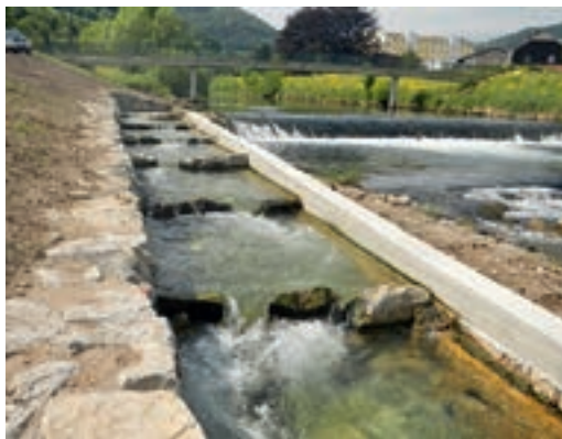
Foto 4.11: Teilrampe zur Sanierung einer Sohlstufe an der Traisen/NÖ. (© ezb)
