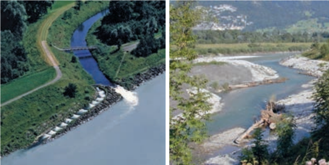
Fotos 4.44–4.45: Mündung Liechtensteiner Binnenkanal mit unpassierbarer Mündungsrampe vor (links) (© Amt für Umweltschutz/FL) und niveaugleicher Einmündung nach Fertigstellung (rechts). (© ezb)
