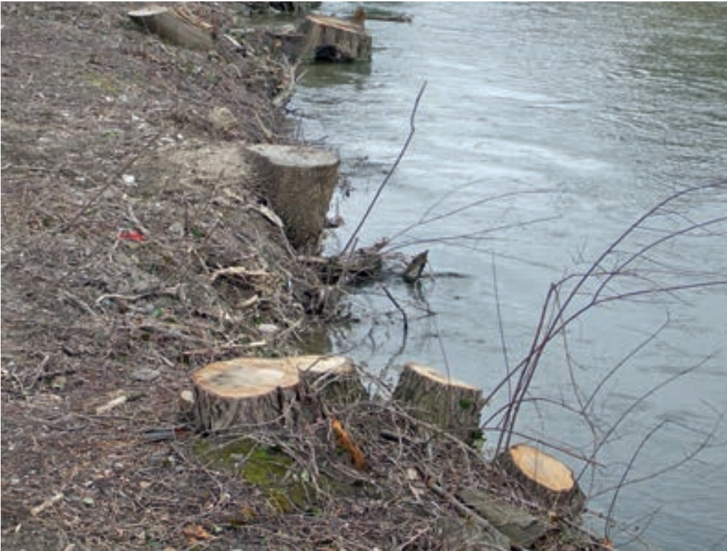
Foto 11.8: Radikale Gehölzentfernung: Das Abstocken sollte nur auf kurzen Abschnitten gleichzeitig, jeweils uferseitig alternierend durchgeführt werden. (© ezb)
