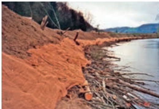
Foto 6.3: Sulm/Stmk.: Großflächig an den Uferböschungen ausgebrachtes verrottbares Jutenetz zur Sicherung der Böschung gegen Erosion. Am Böschungsfuß wurde zur Strukturierung des Uferbereiches zusätzlich eine raue Spreitlage eingebracht. Links Gewässerabschnitt 2 Jahre nach Fertigstellung der Böschungssicherung. Pfähle und Kokosfasern zersetzen sich im Laufe der Jahre. (© Baubezirksleitung Leibnitz)
