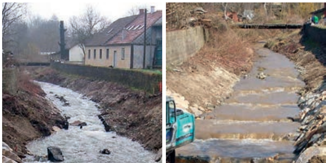
Fotos 4.46–4.47: Mündung Lengbach vorher (links) und mit Mündungsrampe (rechts). (© ezb)
