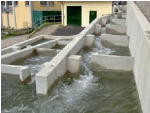
Foto 4.32: Vertical-Slot-Pass Murau; Mur/Stmk. (© ezb, TB Zauner)
