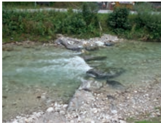
Foto 8.1: Strukturierung einer Restwasserstrecke durch fischpassierbare raue Steinschwelle in einem Gebirgsfluss. (© ezb)
