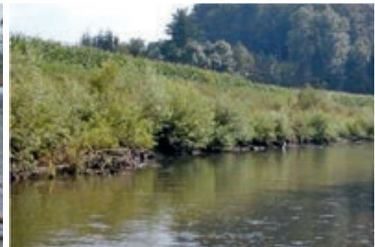
Foto 6.4: Spreitlage als Böschungssicherung an der Sulm/Stmk. nach 2 Vegetationsperioden. Die in die Böschungsfußsicherung integrierten Laub-Raubäume werden bereits kurz nach Fertigstellung der Maßnahmen von Jungfischen zahlreich besiedelt und dienen dem Eisvogel ( Alcedo atthis ) als idealer Ansatzplatz. (© ezb)
