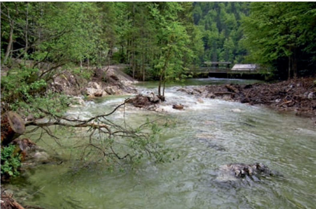
Foto 4.57: Seeausrinn Toplitzbach. Blick stromauf auf die naturnahe Rampe und die dadurch eingestaute Klause. Die Rampe wurde einem natürlichen Felsriegel nachempfunden, der den Bach quert. Bei der Bauausführung wurde auf eine raue Sohle und das Vorliegen von strömungsberuhigten Zonen innerhalb der Rampe geachtet, um eine optimale Fischpassierbarkeit zu gewährleisten. (© ezb, TB Zauner)
