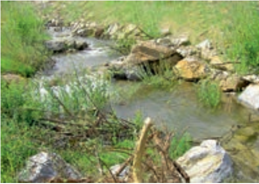
Foto 4.28: Beispiel naturnaher Beckenpass am KW Murau; Mur/Stmk.. (© ezb, TB Zauner)
