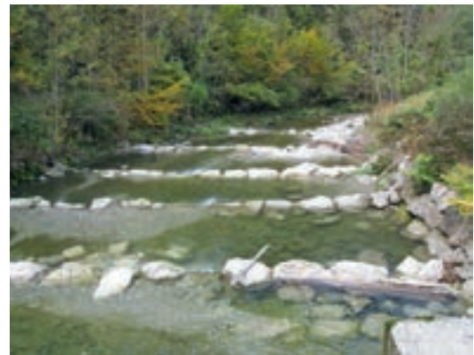
Foto 8.2: „Kolk-Kette“ ohne dazwischen liegende Furten durch zu nahe Aneinanderreihung von Steinschwellen. (© ezb)
