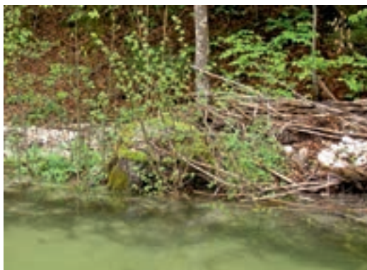
Foto 11.2: Toplitzbach/Stmk.: Im Herbst an der Uferlinie eingebaute Wurzelstöcke von Laubgehölzen nach dem Neuaustrieb im Frühjahr. (© ezb, TB Zauner)
