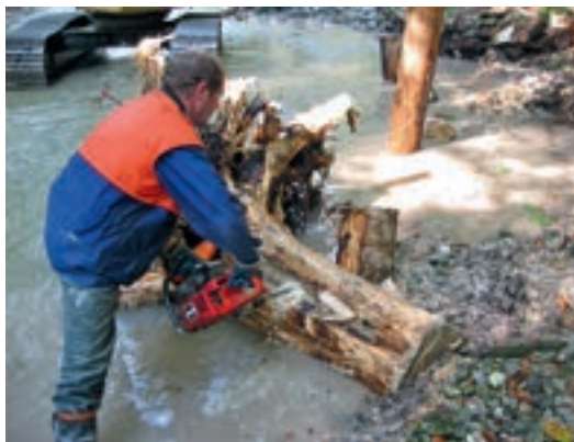
Fotos 5.9–5.10: Einbringen eines Wurzelstockes (links) und verankerter Wurzelstock (rechts, Toplitzbach/Stmk.). (© ezb, TB Zauner)
