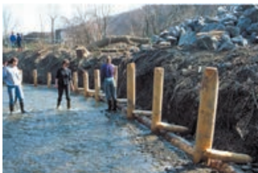
Fotos 6.13–6.14: Bau einer Uferpfahlwand an einem Prallufer, Liesing/NÖ. (© Florineth)
