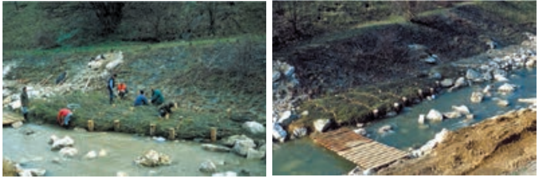
Foto 6.32–6.33: Längsgerichtete Astpackung im Bau, links – nach Fertigstellung; rechts – Wienfluss. (© Florineth)
