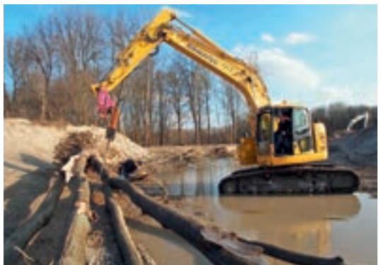
Fotos 5.38–5.39: Einbau von Raubäumen (links: Verankerung an Holzpiloten, rechts: Befestigung mit Erdankern). (© ezb)
