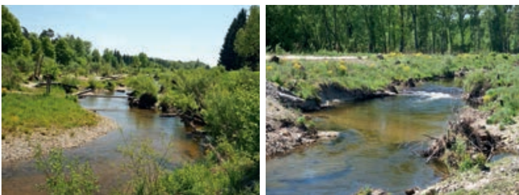
Fotos 5.49–5.50: Pendelndes MW-Bett mit Schotterbänken an den Innenufern und strukturreichen Tiefenrinnen an den Außenufern im aufgeweiteten HW-Abflussprofil, Naarn/OÖ. (© ezb, TB Zauner)
