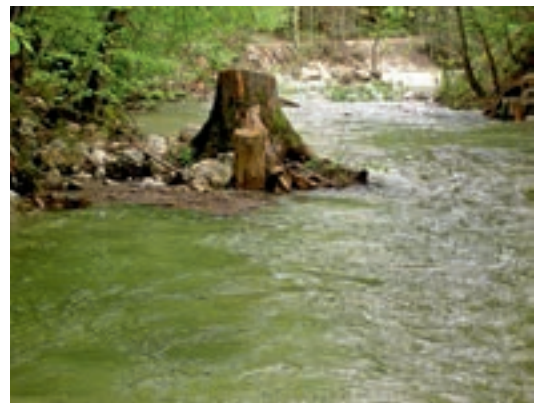
Fotos 5.9–5.10: Einbringen eines Wurzelstockes (links) und verankerter Wurzelstock (rechts, Toplitzbach/Stmk.). (© ezb, TB Zauner)
