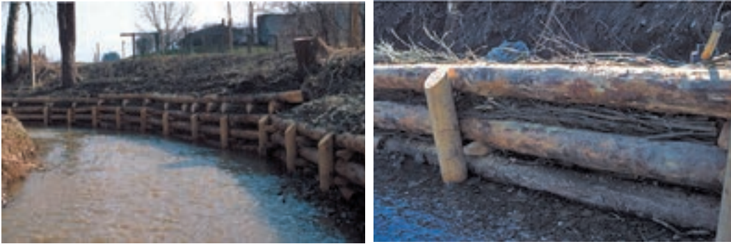
Fotos 6.15–6.16: Links – fertiggestellte Uferpfahlwand an einem Prallufer, rechts – Weidenfaschineneinlage, Liesing, NÖ. (© Florineth)
