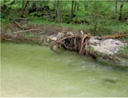
Fotos 5.11–5.12: Strukturierung und Sicherung eines Prallufers mit Wurzelstöcken, Topplitzbach/Stmk. (© ezb, TB Zauner)
