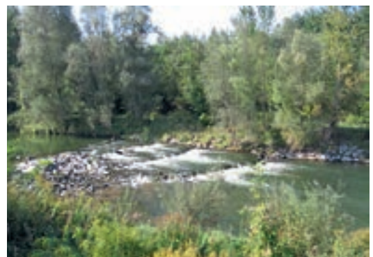
Foto 4.8: Aufgelöste Sohlrampe am Kamp/NÖ. (© ezb)
