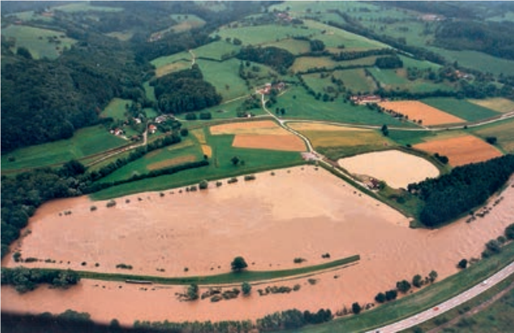
Foto 5.67: Hochwasser 1997 – überfluteter Retentionsraum an der Traisen in Göblasbruck/NÖ. (© WA3 NÖ)
