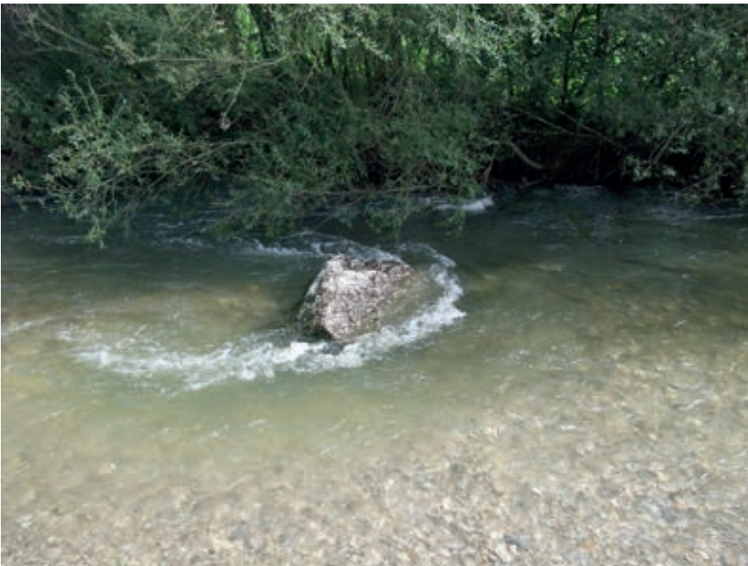
Foto 5.8: Störstein zur Strukturierung der Uferlinie, Traisen/NÖ. (© ezb)
