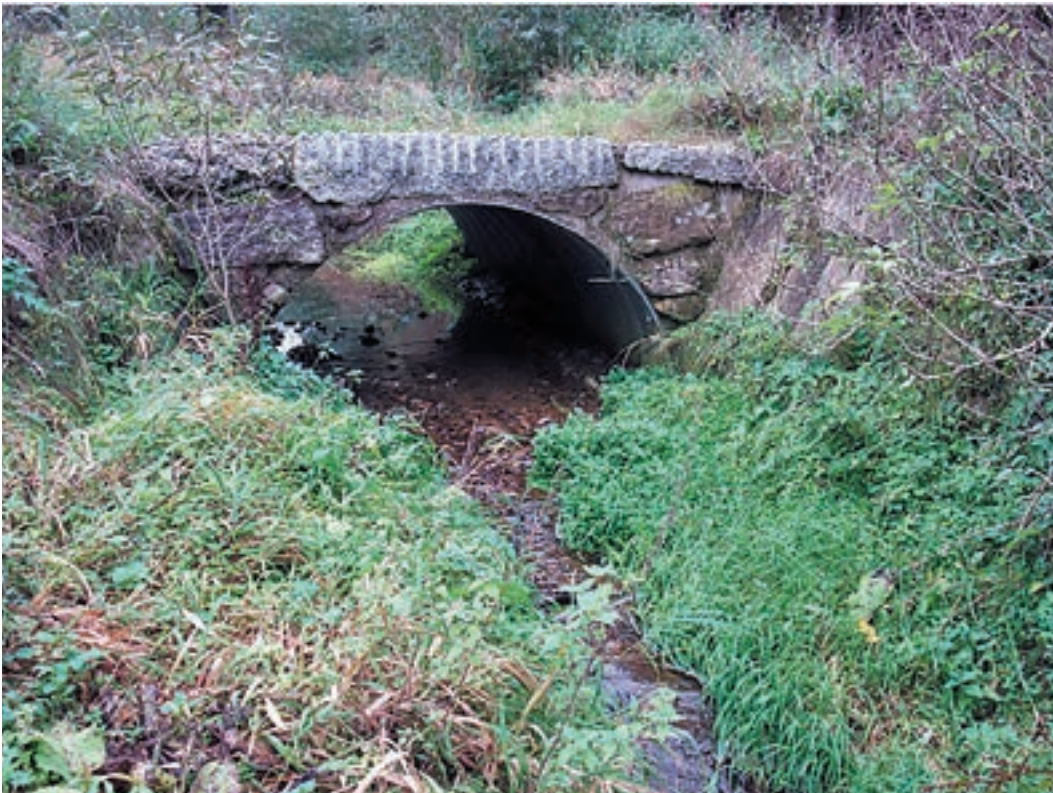
Foto 4.52: Durchlass mit Halbprofil. (© ezb)
