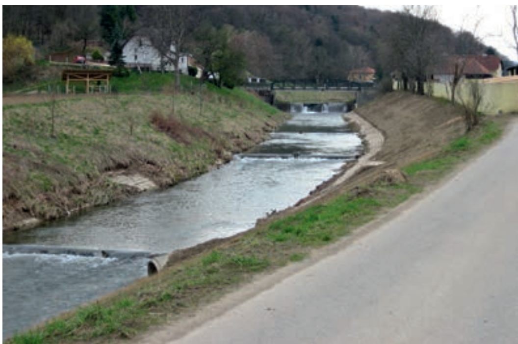
Foto 7.1: Reguliertes Flussbett mit großen und zahlreichen kleinen Querbauwerken zur Sohlfixierung. Die Rückstaubereiche der zahlreichen Querbauwerke erzeugen bei Nieder-/Restwasser eine durchgehende Tümpelkette, Große Tulln/NÖ. (© ezb)
