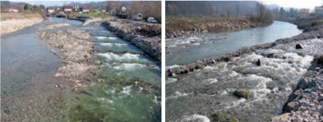
Fotos 4.48–4.49: Mündung des Halbaches in die Gölser/NÖ (Köckwehr): Durch den Bau einer Mündungsrampe wird die sohlebene Einmündung in den Vorfluter erreicht. Das Gerinne wurde im Mündungsbereich verlängert, das Gefälle dadurch ausgeglichen. Fische und andere Gewässerorganismen können so auch bei Niederwasser wieder ungehindert in den Zubringer aufsteigen. (© ezb)
