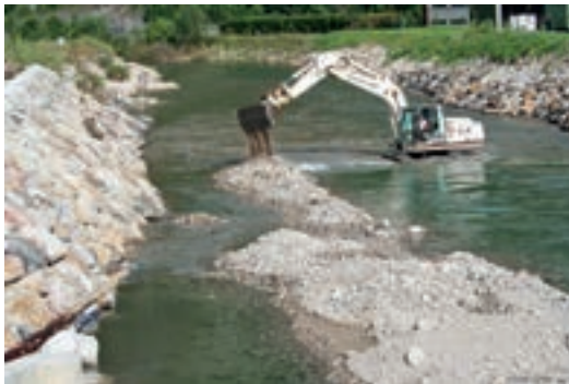
Foto 6.5: „Glatte“ Steinschichtung an der Traisen. (© ezb)
