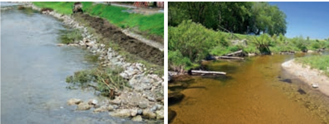
Fotos 5.22–5.23: Links: mit Raubaumpaketen kombinierte Steinsporne zur Strukturierung, rechts: Sporne aus Holzstämmen zur Strukturierung der Ufer der Naarn/OÖ. (© ezb, TB Zauner)
