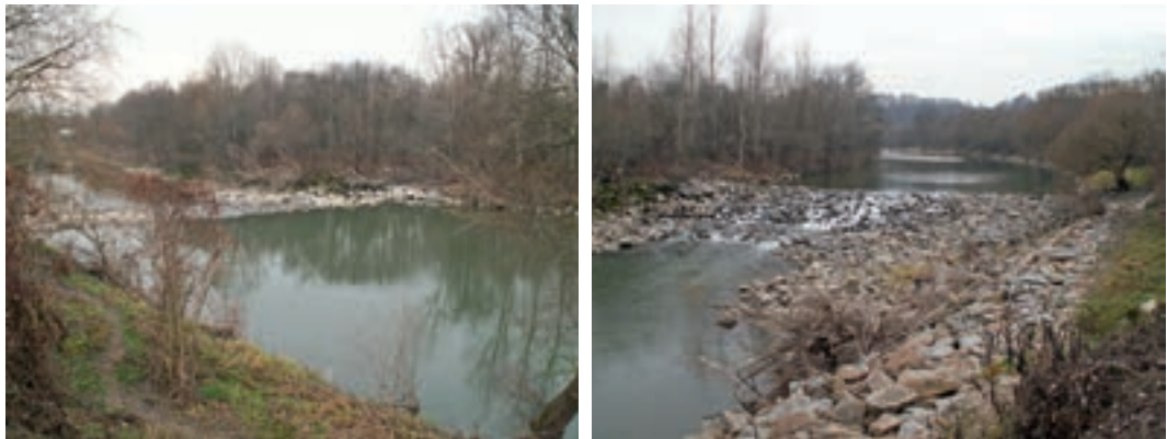
Fotos 10.2–10.3: Ökologisch unattraktive Staubereiche durch sukzessive Sohlerosion zwischen Rampen an der Unteren Ybbs/NÖ. (© ezb)
