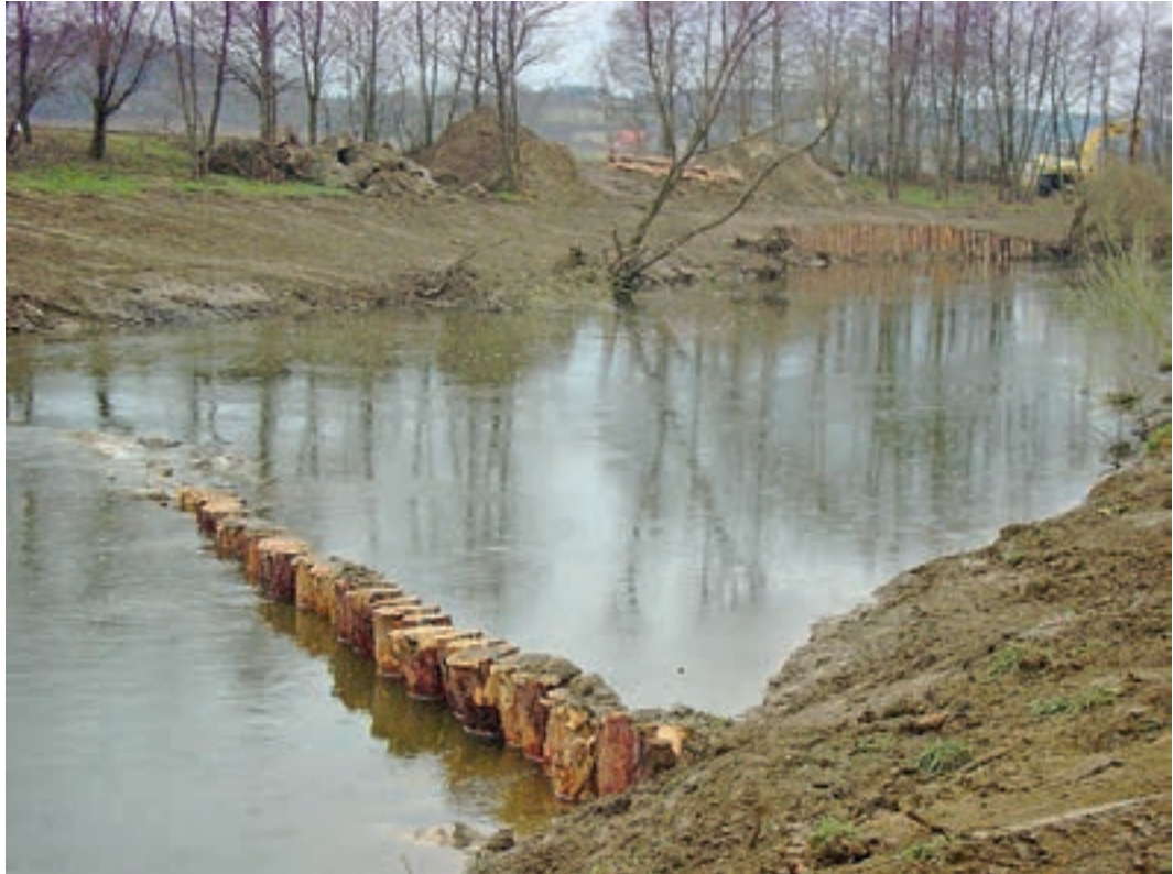
Foto 5.28: Pfahlbuhne an der Raab/Burgenland. (© ezb)
