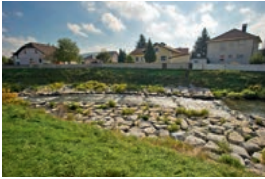
Foto 4.5: Aufgelöste Sohlrampe an der Großen Tulln bei Judenau/NÖ. (© BMLFUW, Newman)
