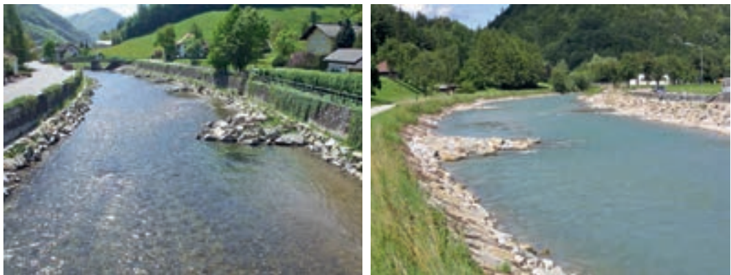
Fotos 5.32–5.33: HW-Schutz Schrambach. Die am Prallufer angeordneten Dreiecksbuhnen bewirken eine Strömunglenkung zum Innenufer und eine Strukturierung der Ufer. (© ezb)
