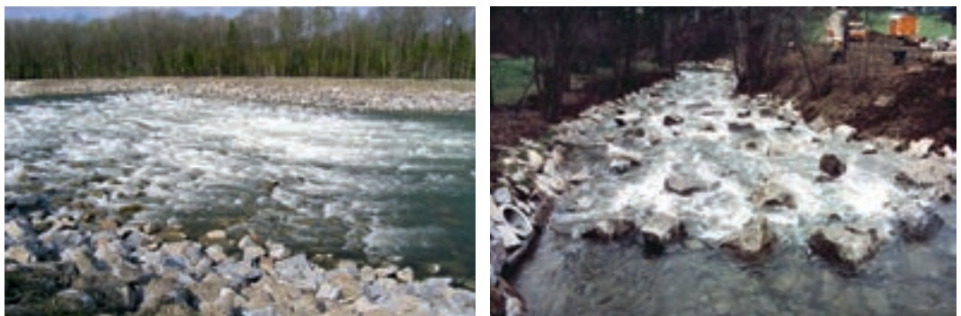
Fotos 4.15–4.16: Steilstrecken – links: mit gleichmäßiger Struktur, rechts: mit Störsteinen. (© GEBLER)
