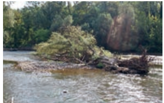
Fotos 5.36–5.37: Links: Strömungsteiler aus Baumstämmen und Wurzelstöcken, Ybbs/NÖ (© Lazowski), rechts: ca. 15 m langer Raubaum als Strömungsteiler, Ybbs bei Hausmening/NÖ. (© ezb)
