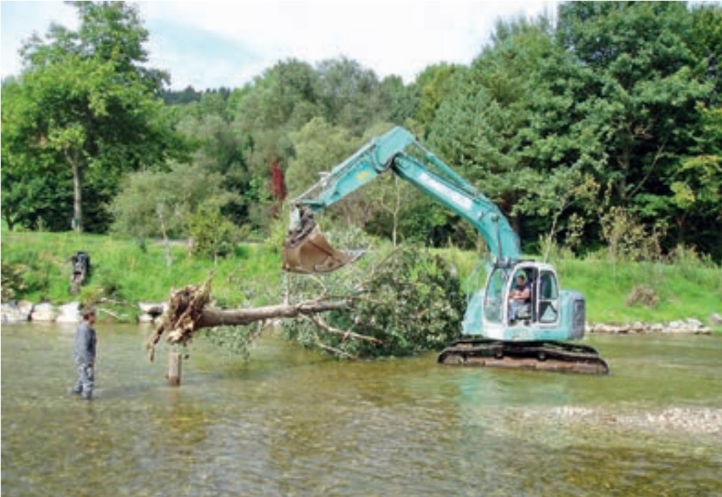
Foto 5.21: Fixierung von Raubäumen mittels eingeschlagener Holzpiloten. (© ezb, TB Zauner)
