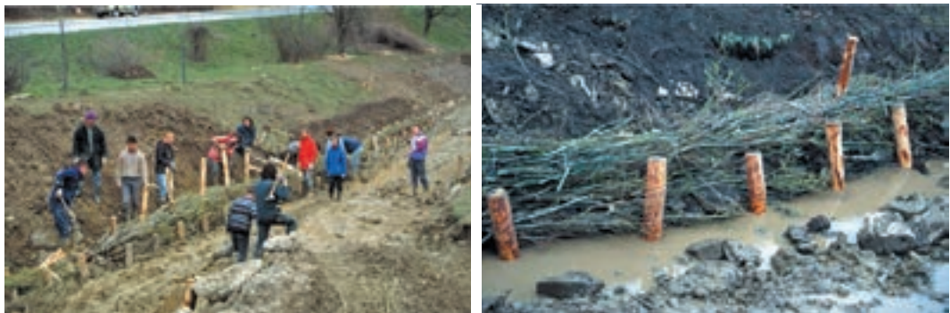
Foto 6.22–6.23: Faschinenreihen – links – Einlegen einer Weidenfaschine, rechts – Verankerung mit Holzpflocken. (© Florineth)
