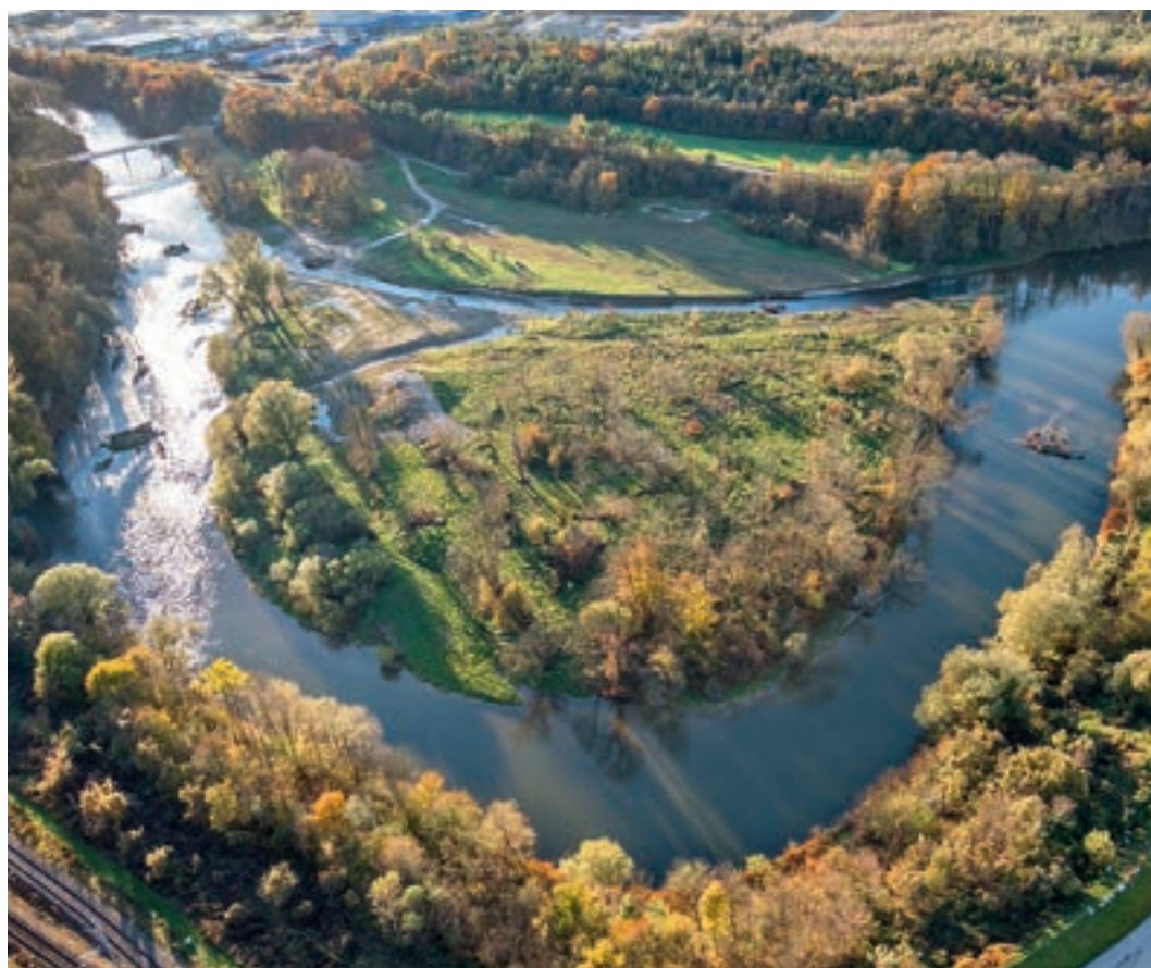
Foto 7.5: Im Zuge des LIFE-Projekts Mostviertel geschaffene Aufweitung und Nebenarm im Stauwurzelbereich des KW Hausmending/Ybbs/NÖ. (© Haslinger extremfotos)
