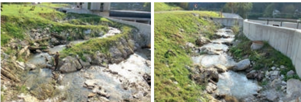
Foto 4.26–4.27: Beispiel naturnaher Beckenpass Reichraming; Enns/OÖ. (© ezb, TB Zauner)
