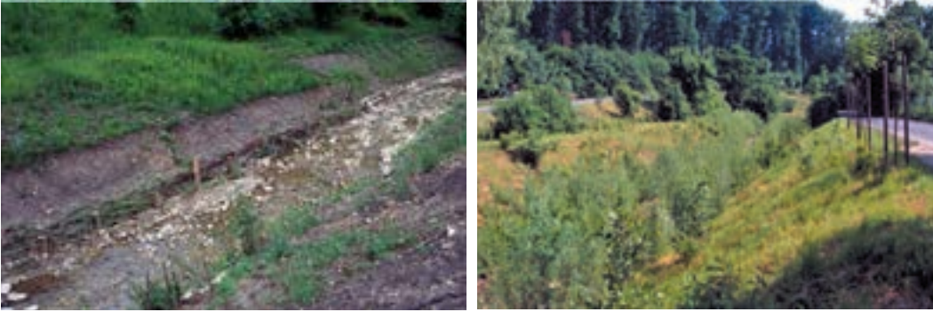
Foto 6.24-6.25: Faschinenreihen am Alsbach – links – nach 2 Monaten, rechts – nach 12 Monaten. (© Florineth)
