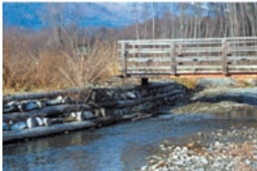
Foto 6.30–6.31: Doppelte Uferkrienerwand kurz nach Fertigstellung, links – nach 4 Jahren; rechts – Saldurbach/Südtirol. (© Florineth)
