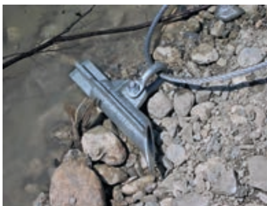
Fotos 5.17–5.18: Einbau eines Erdankers mittels Bohrhammer. (© ezb)
