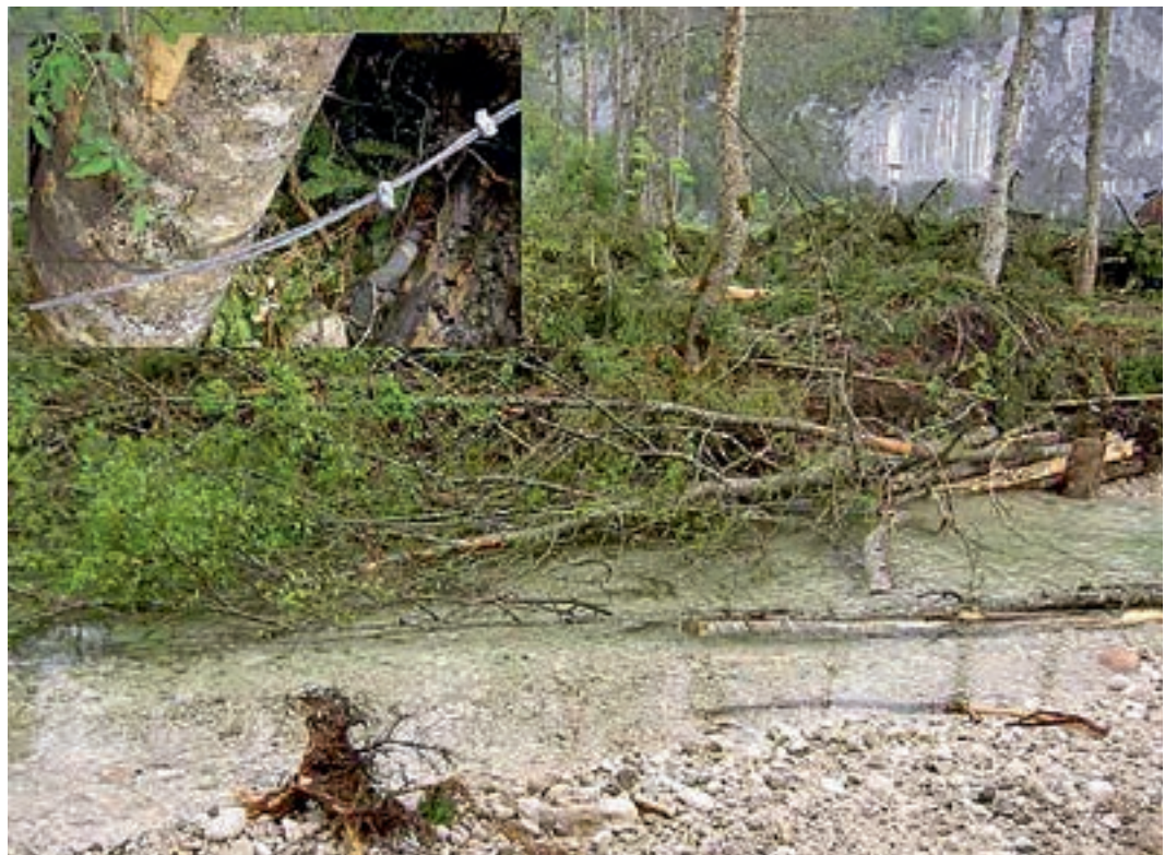
Foto 6.35: Lokale Ufersicherung/Strömunglenkung durch Laub-Raubäume, Toplitzbach/Stmk. (© ezb, TB Zauner)
