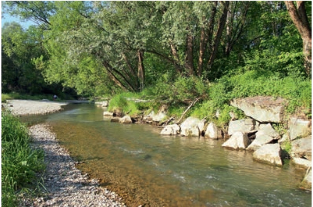
Foto 6.11: Rau verlegter Blockwurf, Pielach/NÖ. (© ezb)
