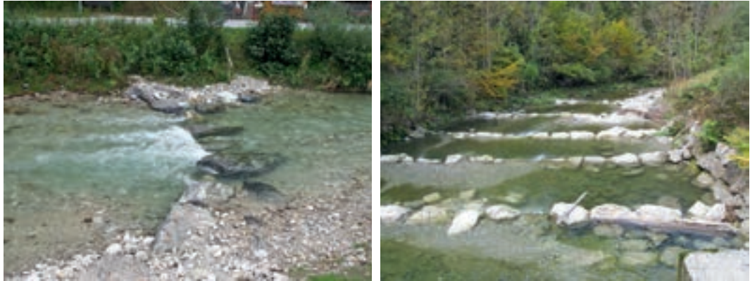
Fotos 5.40–5.41: Links: Strukturierung einer regulierten Strecke durch fischpassierbare raue Steinschwellen in einem Gebirgsfluss, rechts: „Kolk-Kette“ ohne dazwischen liegende Furten durch zu nahe Aneinanderreihung von Steinschwellen. (© ezb)
