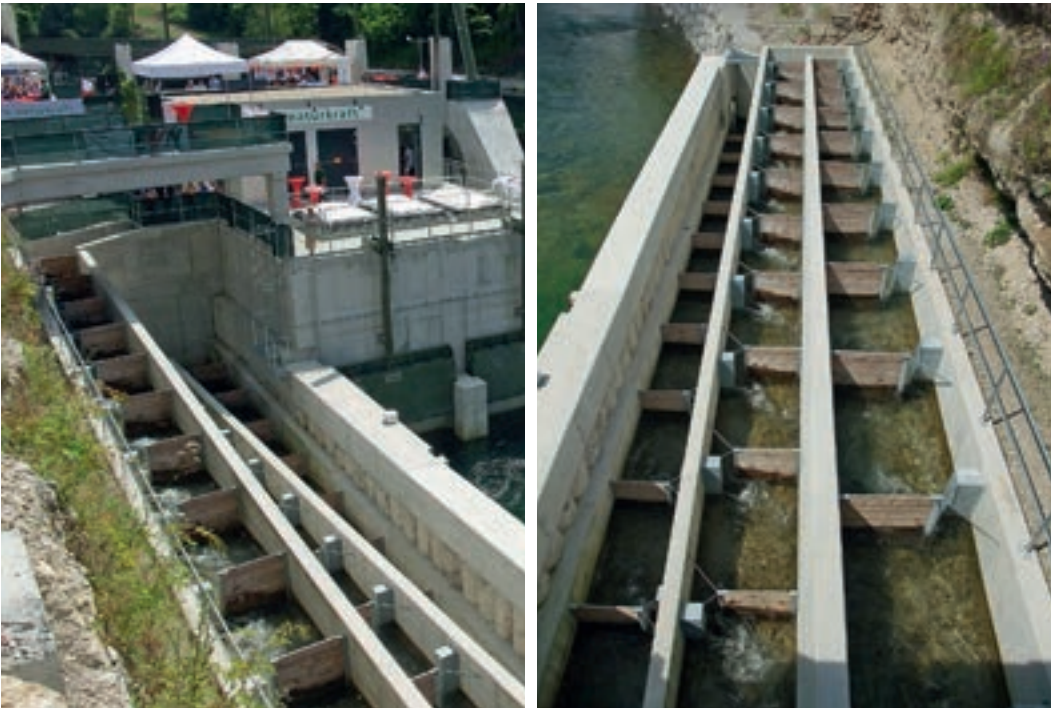
Fotos 4.34–4.35: Vertical-Slot-Pass beim KW Schütt an der Ybbs/NÖ. (© ezb)
