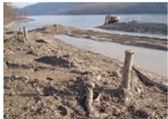
Foto 11.3: Nebenarmsystem Girmsing, Donau/NÖ.: Die bei der Rodung der Uferböschungen anfallenden Wurzelstöcke wurden als Initialbepflanzung der neu geschütteten Ufer eingebracht. (© ezb)
