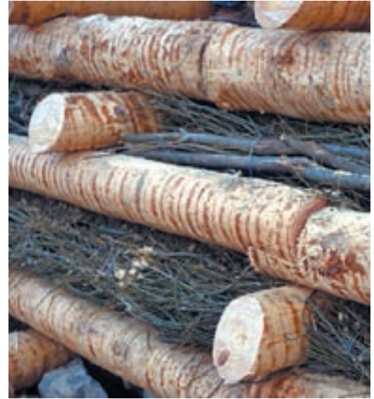
Foto 6.12: Uferpfahlwand mit Weidenfaschinen. (© Florineth)
