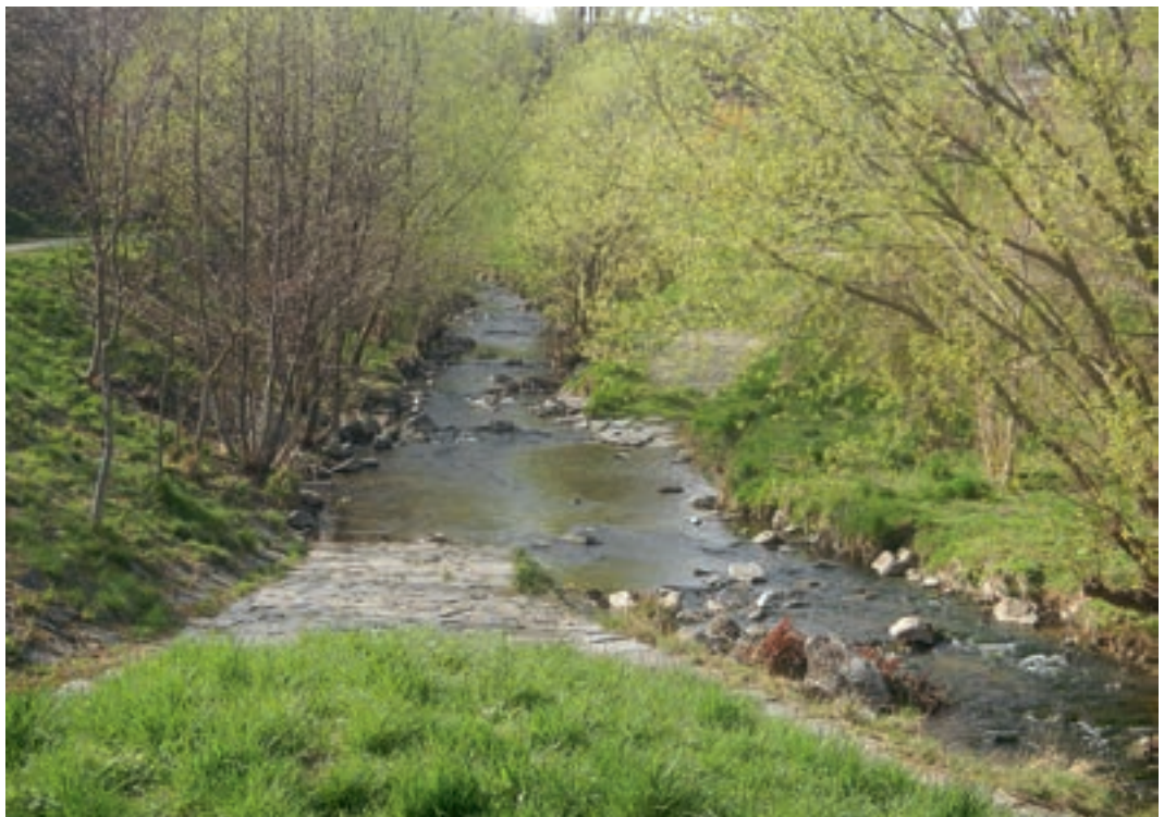
Foto 4.54: Befahrbare Furt Liesing/Wien. Ausreichende Wassertiefe, raue Sohle und geringe Strömungsgeschwindigkeiten stellen die Passierbarkeit von befahrbaren Furten sicher. (© ezb)
