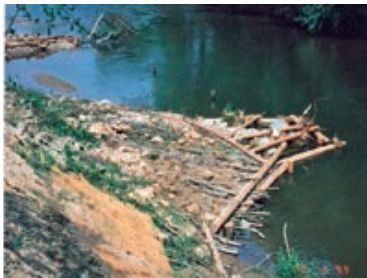
Foto 5.35: Dreiecks-Kastenbuhne an der Sulm/Stmk. (© BBL Leibnitz)
