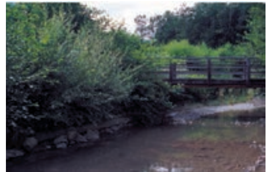
Foto 6.30–6.31: Doppelte Uferkrienerwand kurz nach Fertigstellung, links – nach 4 Jahren; rechts – Saldurbach/Südtirol. (© Florineth)
