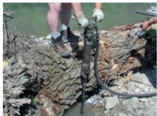
Fotos 5.17–5.18: Einbau eines Erdankers mittels Bohrhammer. (© ezb)
