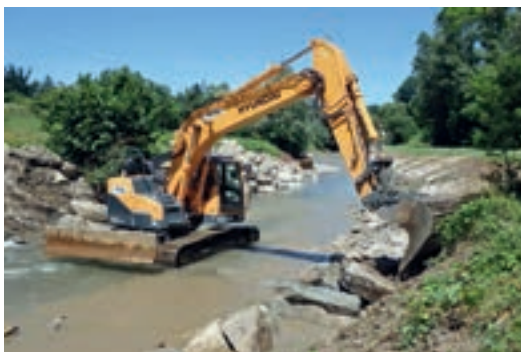
Foto 6.7: Steinschichtung im Bau – Laabenbach, Neulengbach/NÖ. (© ezb)
