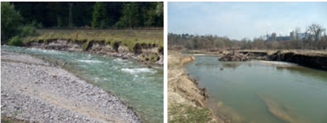
Fotos 5.3–5.4: Links: Ufererosion am ungesicherten Prallhang an der Unrechttraisen – rechts: Nebenarm an der Ybbs (Hausmening/NÖ) Initiierung von Ufererosion durch flussauf am gegenüberliegenden Ufer angeordnete Buhnen. (© ezb)
