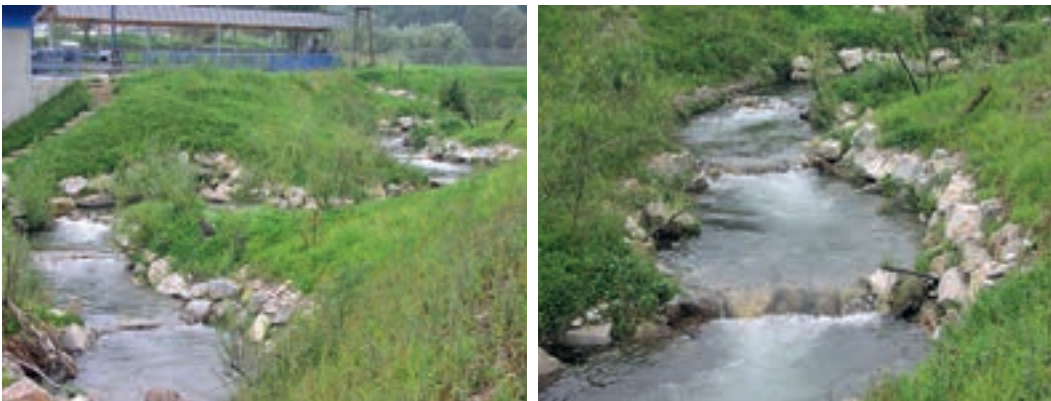
Fotos 4.24–4.25: Beispiel naturnaher Beckenpass; Tümpelpass KW Fischer, Traisen/NÖ. (© ezb)
