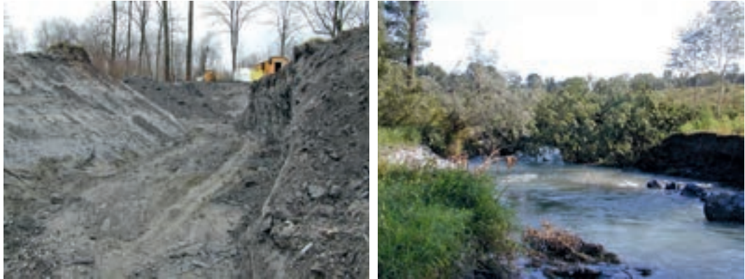
Fotos 5.46–5.47: Initialmäander Liechtensteiner Binnenkanal (links Bauzustand, rechts nach Flutung und erstem HW. (© ezb)
