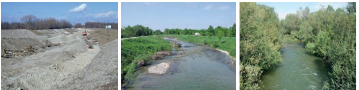
Fotos 4.19–4.21: Umgehungsarm an der Sohlstufe 40, Traisen/NÖ, 2001, 2006, 2012. (© ezb)
