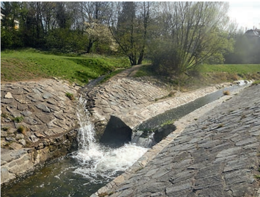
Foto 4.40: Mündung Dürre Liesing/Wien in verbautes Bett der Reichen Liesing: Abstürze und harte Verbauungen unterbrechen die biologische Durchgängigkeit. (© ezb)
