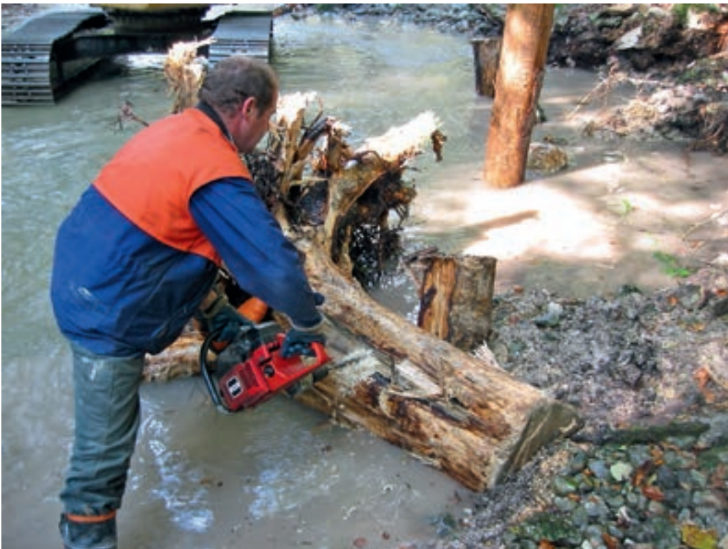
Foto 6.34: Einbau von Wurzelstöcken. (© ezb, TB Zauner)
