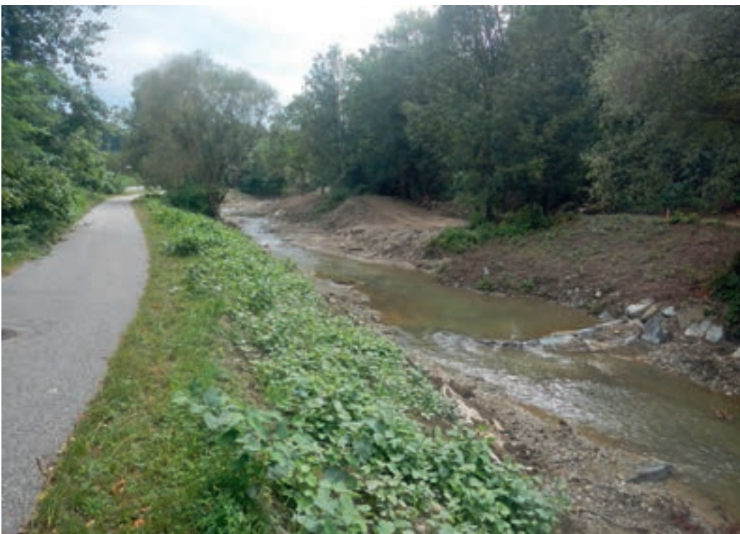
Foto 5.24: Sichelbuhne am Laabenbach bei Neulengbach/NÖ. (© ezb)
