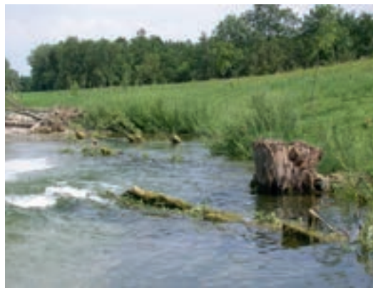
Foto 5.14: Wurzelstöcke und Raubaumbunnen strukturieren das neu gestaltete Ufer an einer Aufweitung an der Traisen/NÖ. (© ezb)
