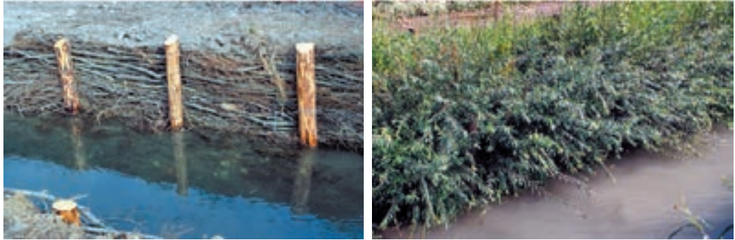
Foto 6.26–6.27: Faschinenwand am Sackbach, links – nach Fertigstellung, rechts – nach 6 Monaten. (© Florineth)
