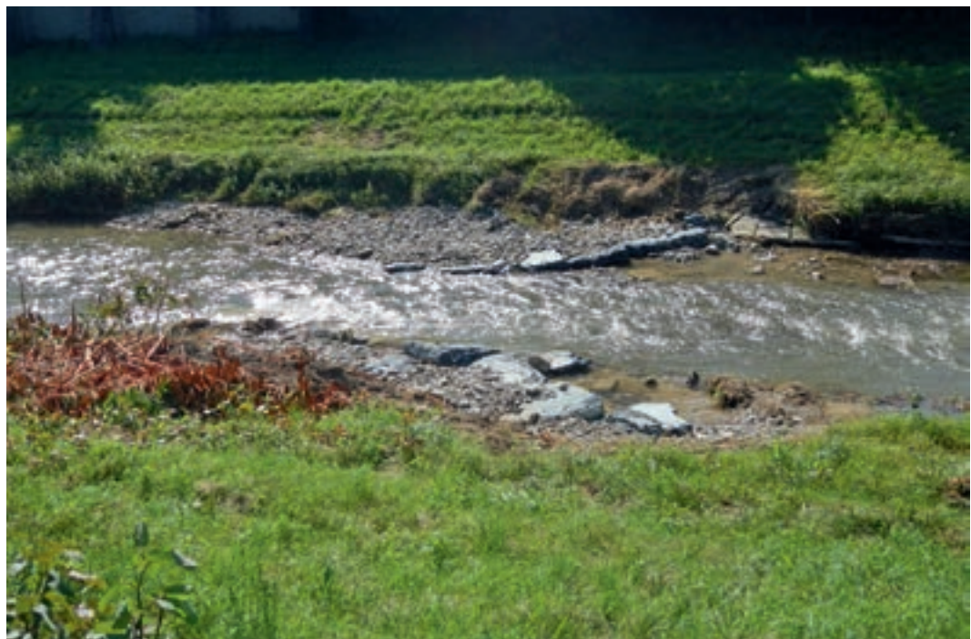
Foto 5.25: Trichter am Laabenbach/NÖ. (© ezb)
