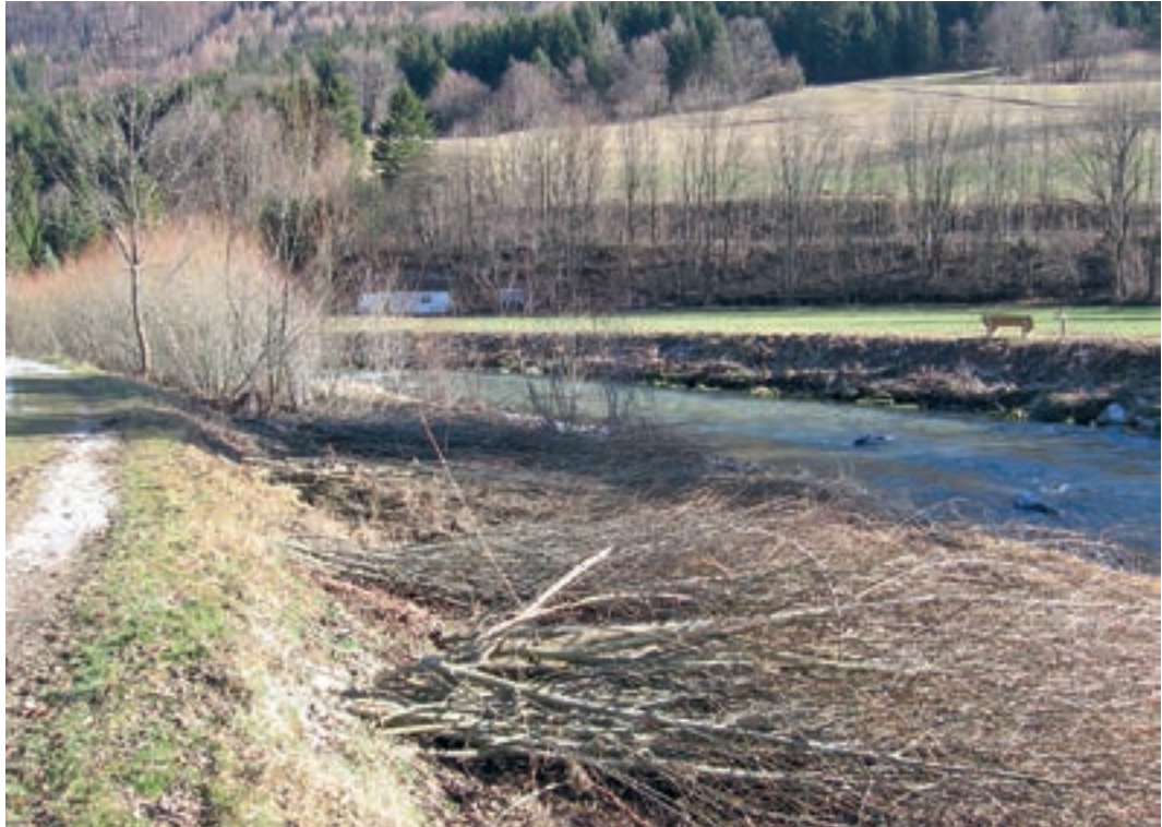
Foto 11.9: Flächig Auf-Stock-gesetzter Weidensaum an der Traisen/NÖ: Die Ufervegetationspflege ist hier mit hohem Aufwand verbunden. Zur Herstellung eines weniger pflegeintensiven Zielzustandes sind selektive Pflegemaßnahmen über mehrere Jahre notwendig. (© ezb)
