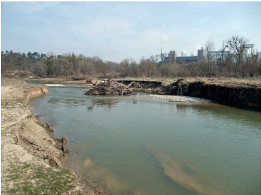
Foto 5.58: Initiierung von Ufererosion durch Bühnen am gegenüberliegenden Ufer des neu angelegten Nebenarmes an der Ybbs bei Hausmening/NÖ. (© ezb)
