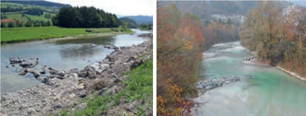
Fotos 5.26–5.27: Links: Buhnen an der Traisen Wasenmühle/NÖ, rechts: alternierende Steinbuhnen. (© ezb)
