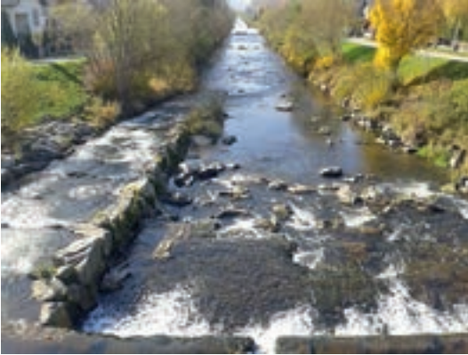
Foto 4.13: Teilrampe in Rainfeld an der Gölsen/ NÖ. (© ezb)
