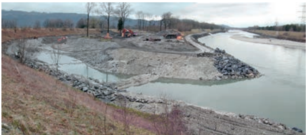
Foto 4.41: Mündung des Liechtensteiner Binnenkanals in den Alpenrhein: im Bauzustand. (© ezb)
