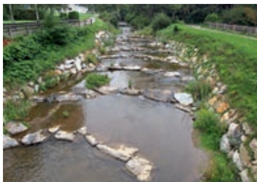
Foto 4.7: Pendelrampe Leitsberg – Große Tulln/NÖ. Durch die wechselnde Anordnung der Beckenübergänge in den Einzelschwellen entsteht eine pendelnde Niederwasserrinne. (© ezb)
