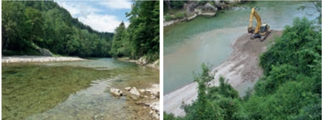
Fotos 7.7–7.8: Ybbs/NÖ, KW Schütt: Furtaufhöhung zur Schaffung einer attraktiven Stauwurzel. (© ezb)
