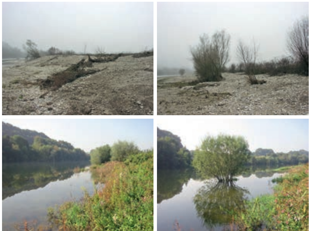
Fotos 7.12–7.15: Anschüttungen und resultierende Flachwasserbereiche im Stauraum vor (oben) und nach (unten) Einstau, KW Kemmelbach / Ybbs. (© ezb)
