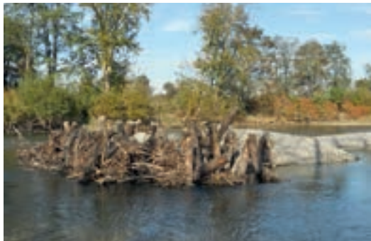
Fotos 5.36–5.37: Links: Strömungsteiler aus Baumstämmen und Wurzelstöcken, Ybbs/NÖ (© Lazowski), rechts: ca. 15 m langer Raubaum als Strömungsteiler, Ybbs bei Hausmening/NÖ. (© ezb)
