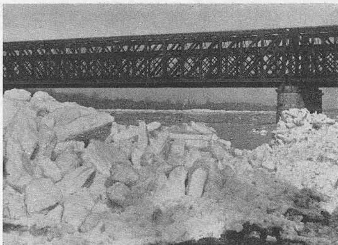
Reste des Eisstoßes bei der Tullner Eisenbahnbrücke, km 1963.
