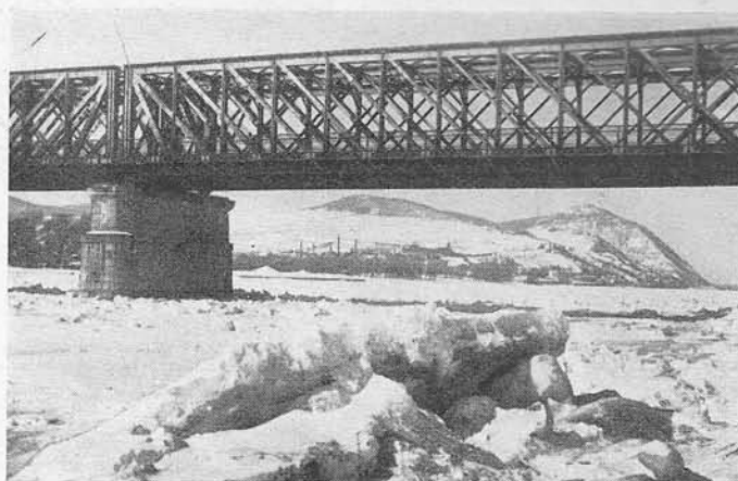
Eisstöß bei der Nordwestbahnbrücke in Wien, km 1933.
