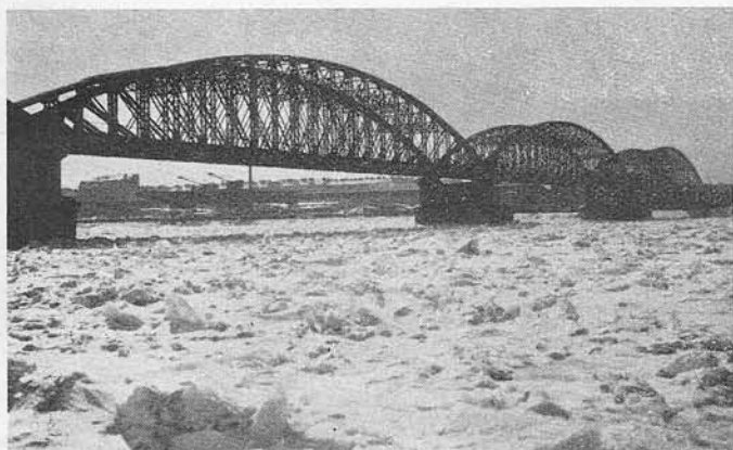
Eisstöß bei der Nordbahnbrücke in Wien, km 1931.
