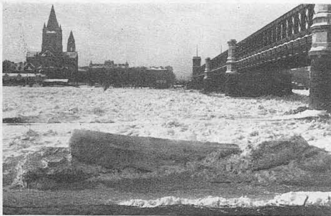
Eisstöß bei der Reichsbrücke in Wien, km 1929.
