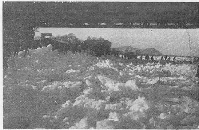
Partie unter der Reichsbrücke in Wien, km 1929.
