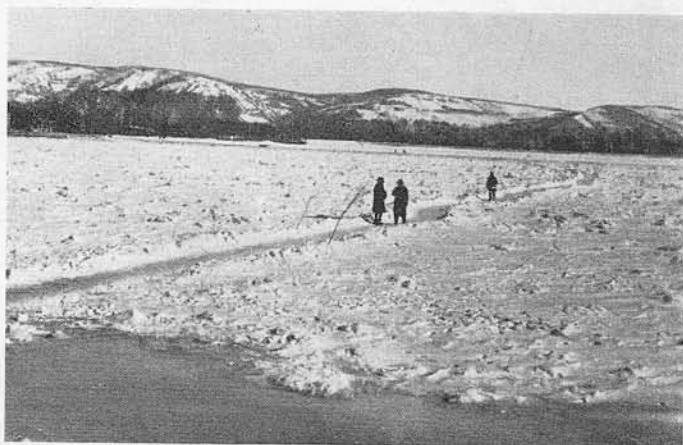
Weg über den Eisstoß bei Lang-Enzersdorf, km 1938.
