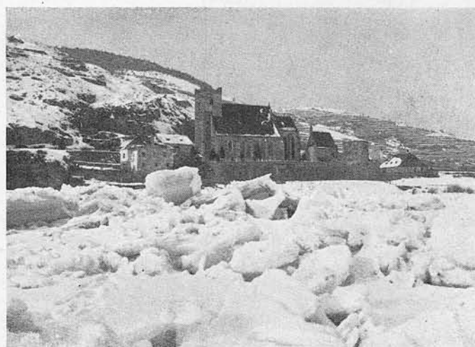
Aufgetürmte Eismassen bei St. Michael, km 2017.
