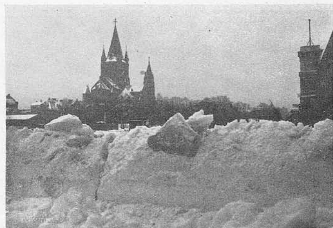
Aufgetürmte Eismassen unterhalb der Reichsbrücke in Wien, km 1929.
