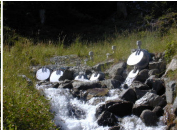
Abbildung 3: Überlauf des gefassten Quellbereiches
