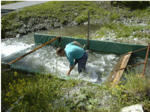
Abbildung 2: Das alte Messgerinne musste öfter geräumt werden
