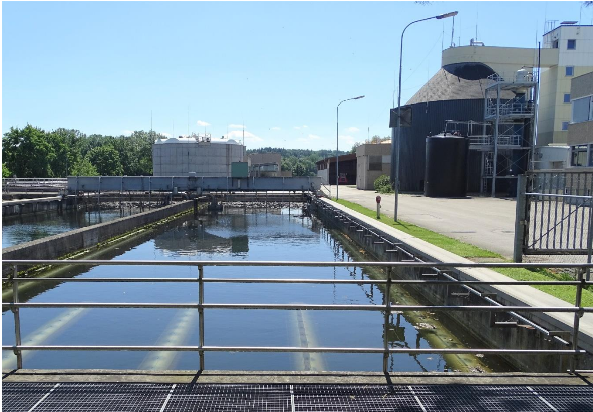
Kommunale Kläranlage ARA Trattnachtal, © Umweltbundesamt/Katharina Lenz.
