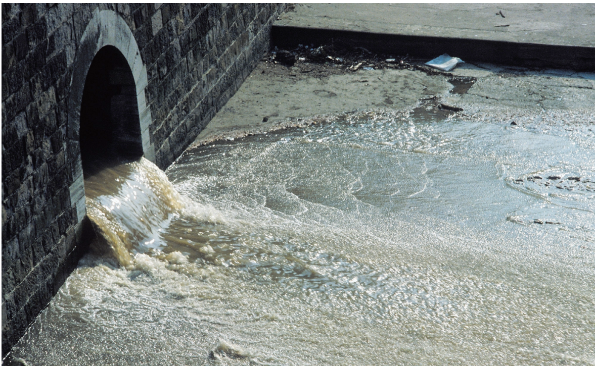
Abwassereinleitung, © Umweltbundesamt/Bernhard Gröger.
