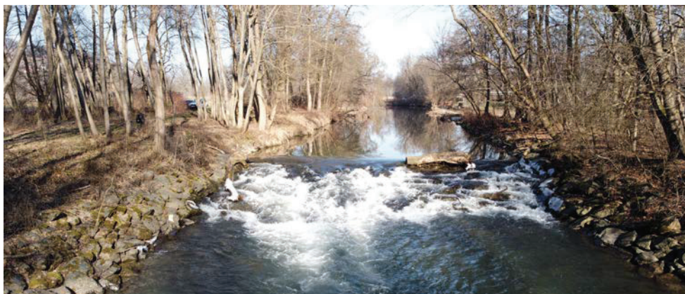
Situation an der Wehranlage vor Errichtung der Fischaufstiegshilfe. Blickrichtung flussaufwärts
