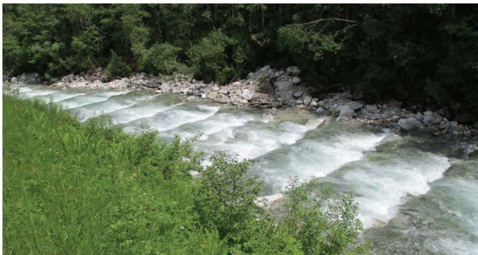
Querbauwerk 1 nach Sanie- rung
