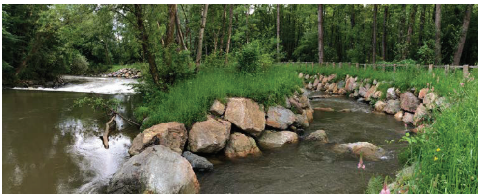
Ausstieg aus der Fischaufstiegshilfe. Blickrichtung flussabwärts
