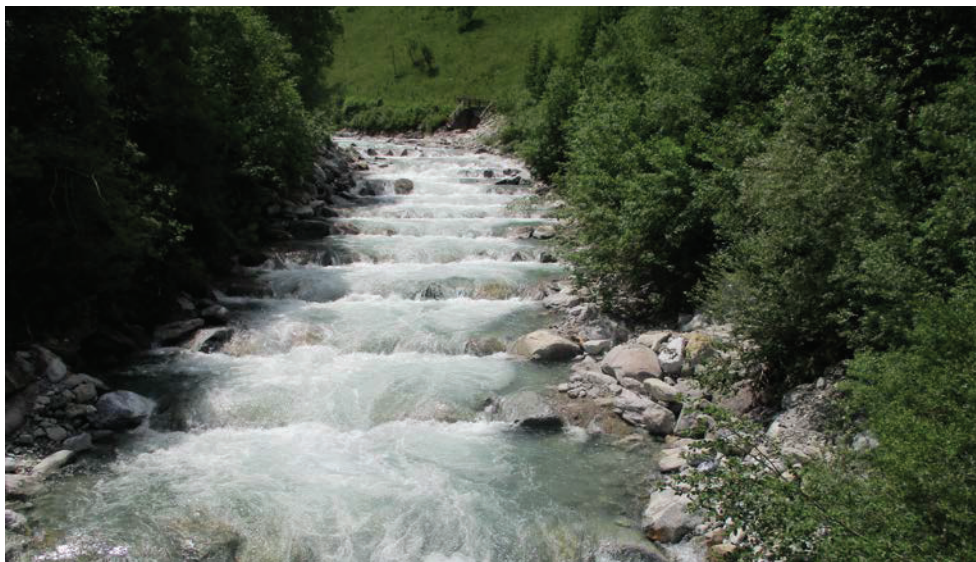
Querbauwerk Triebwasser- leitung nach Sanierung
