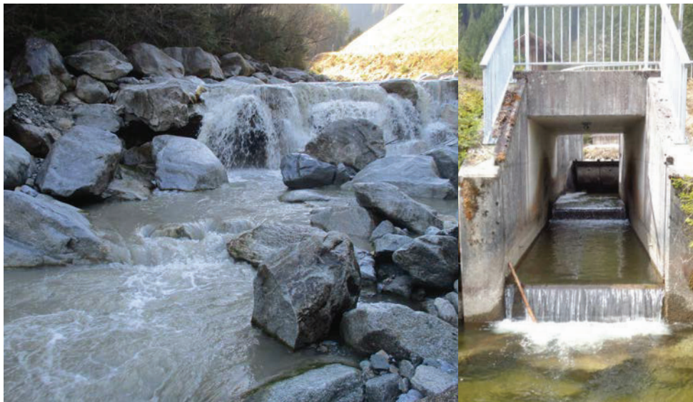
links: Querbauwerk 1 vor Sanierung
