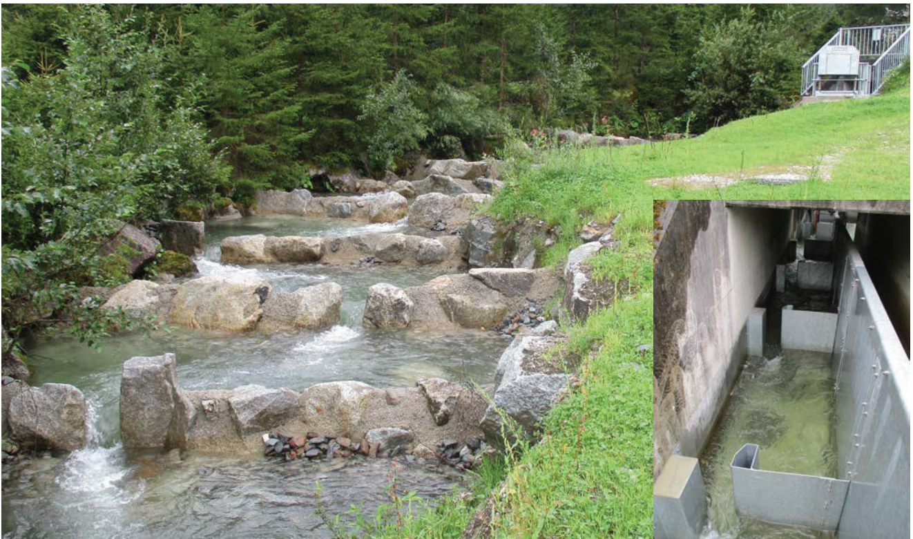
rechts: Fischaufstiegshilfe technisch neu
