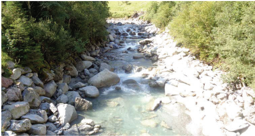
Querbauwerk Triebwasser- leitung unpassierbar
