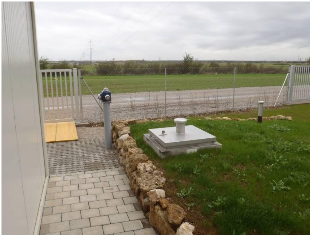
Abbildung 12: Einlaufschacht mit Schieberkammer
