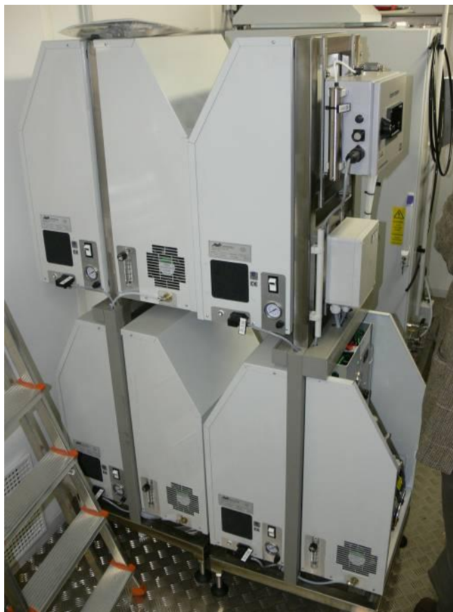
Abbildung 27: ursprüngliche Sauerstoffgeneratoren: sieben AirSeps
