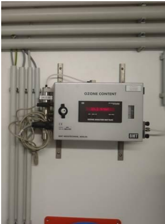
Abbildung 23: BMT-Sonde: Messung des Ozongehalts im Gas
