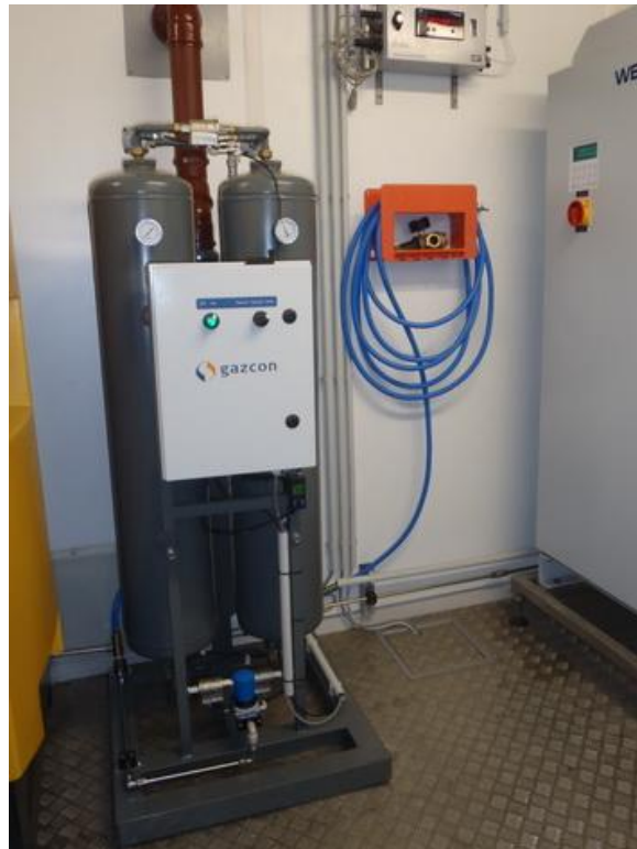
Abbildung 20: Sauerstoffgenerator: PSA-Anlage
