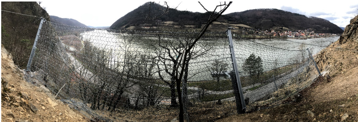
Abbildung 1: Technische Schutzmaßnahmen gegenüber Steinschlag
