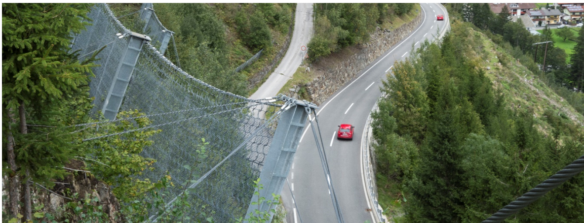
Abbildung 13: Technischer Steinschlagschutz konzipiert und gebaut durch die WLW
