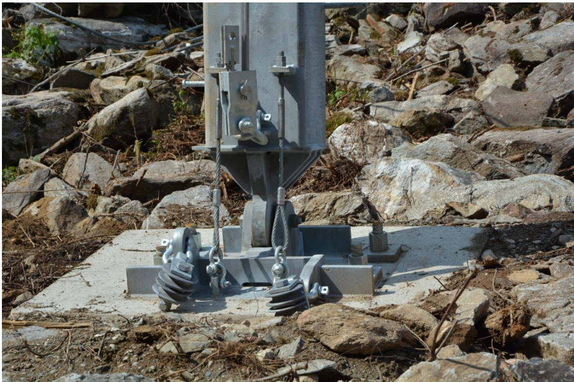
Abbildung 14: Detailansicht der Stützenplatte mit Betonfundament
