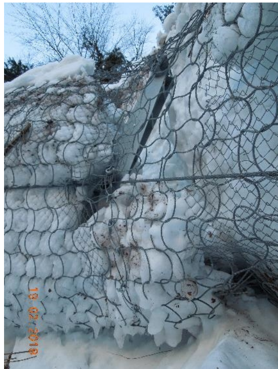
(b) beschädigte Auflagegitter
