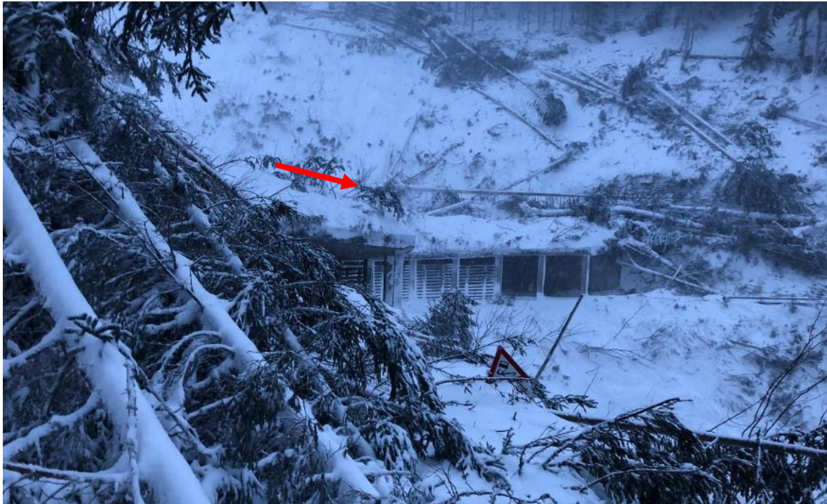
Abbildung 40: Eingewehte Stützverbauung mit Restanbruchgebiet der Heuberg-Lawinen, Häselgehr
