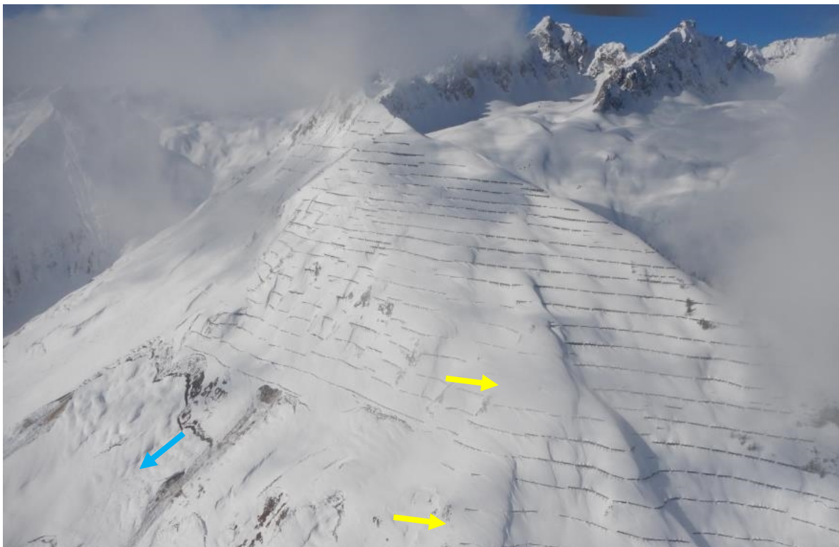
Abbildung 40: Eingewehte Stützverbauung mit Restanbruchgebiet der Heuberg-Lawinen, Häselgehr
