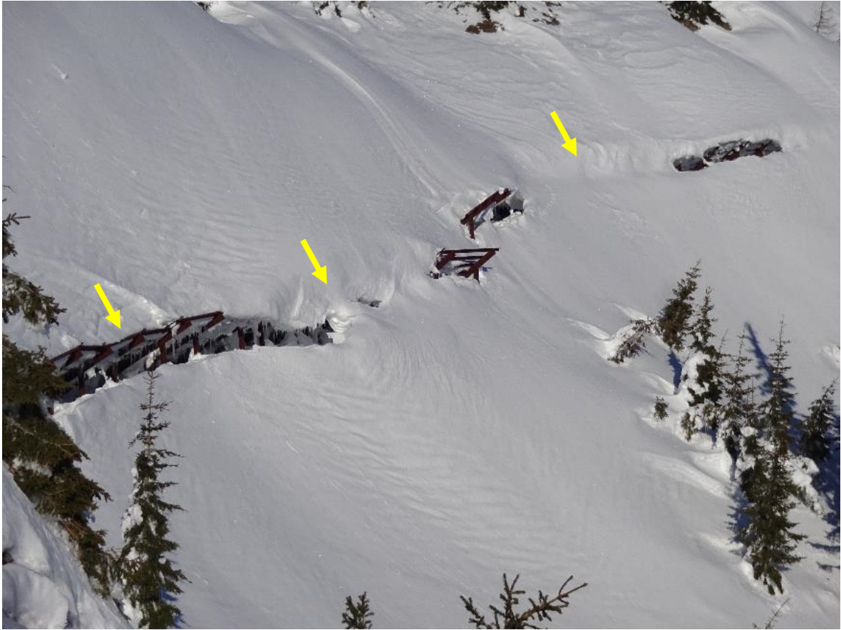
Abbildung 33: Überschneite Anbruchverbauungen der Wetterin-Lawinen, Mariazell
