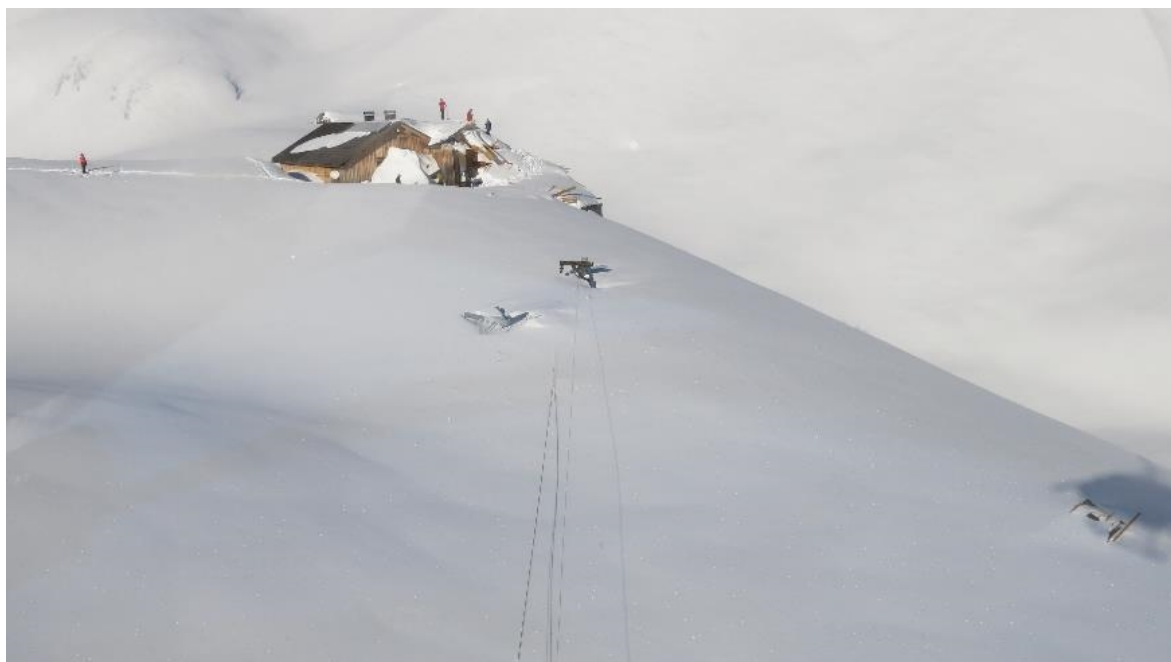
Abbildung 71: Von der Zirnenkopf-Lawine beschädigte Totalphütte und Materialseilbahn, Vandans
