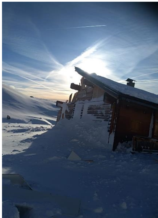
(b) Beschädigte Schmiedleralm
