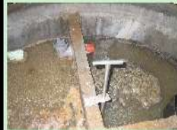
3-Kammer Absetzanlage
