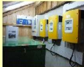
Inselwechselrichter mit BHKW
