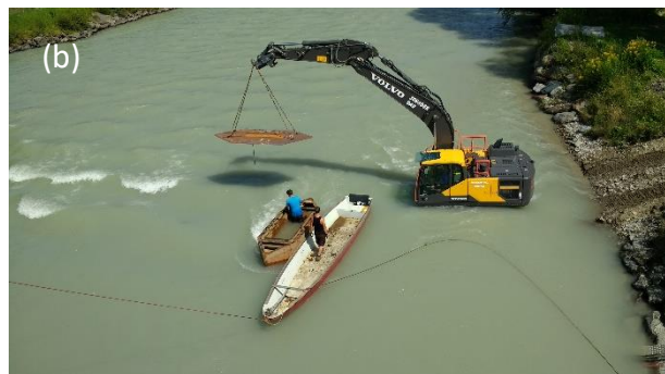
Abbildung 45: a) Wartung im Frühjahr, b) Wartung der elevierbaren Geschiebefalle
