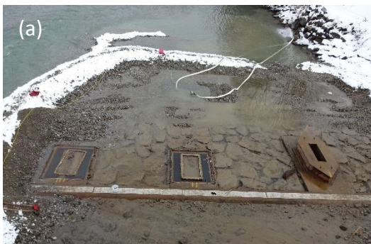
Abbildung 45: a) Wartung im Frühjahr, b) Wartung der elevierbaren Geschiebefalle
